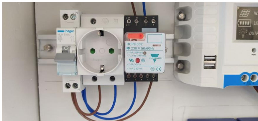
Εικόνα 46: Τοποθέτηση εξαρτημάτων πίνακα ελέγχου Φ/Β συστήματος
