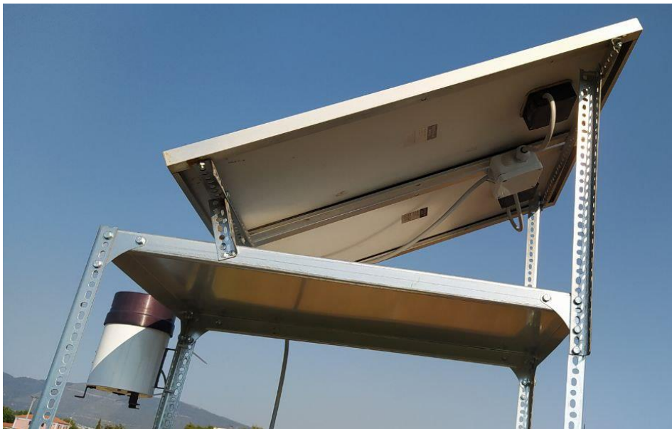
Εικόνα 24: Προσαρμογή των πάνελ στην κατασκευή
