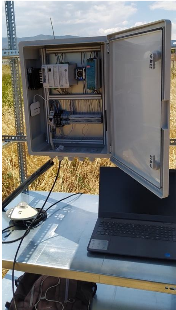
Εικόνα 39: Εγκατάσταση πίνακα ελέγχου στον αγρό
