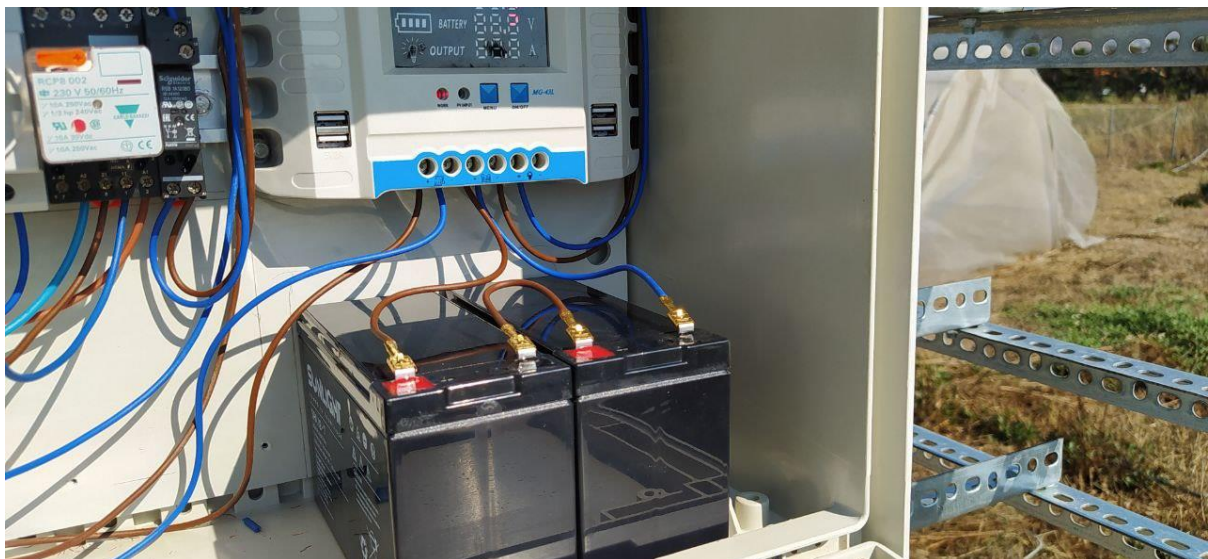
Εικόνα 49: Τοποθέτηση πίνακα Φ/Β συστήματος στον αγρό 2
