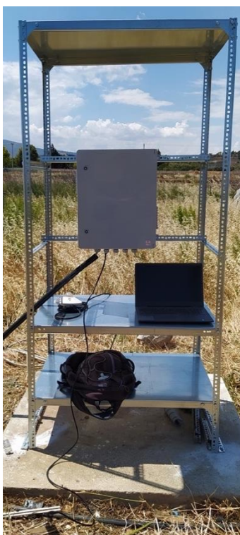
Εικόνα 23: Σκελετός κατασκευής χωρίς πίνακες και φωτοβολταϊκά πάνελ.
