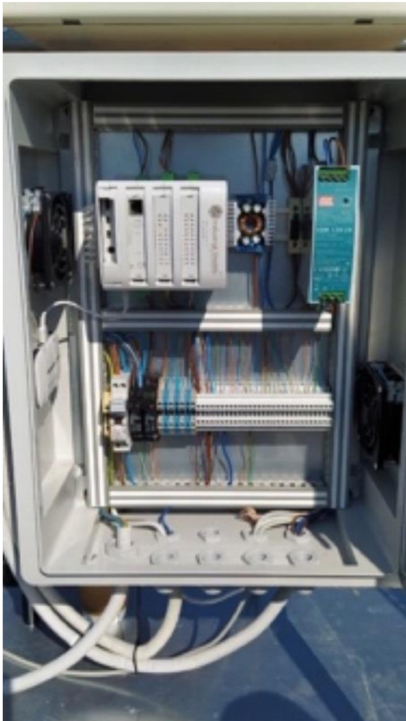
Εικόνα 38: Εγκατάσταση πίνακα ελέγχου στον αγρό 1
