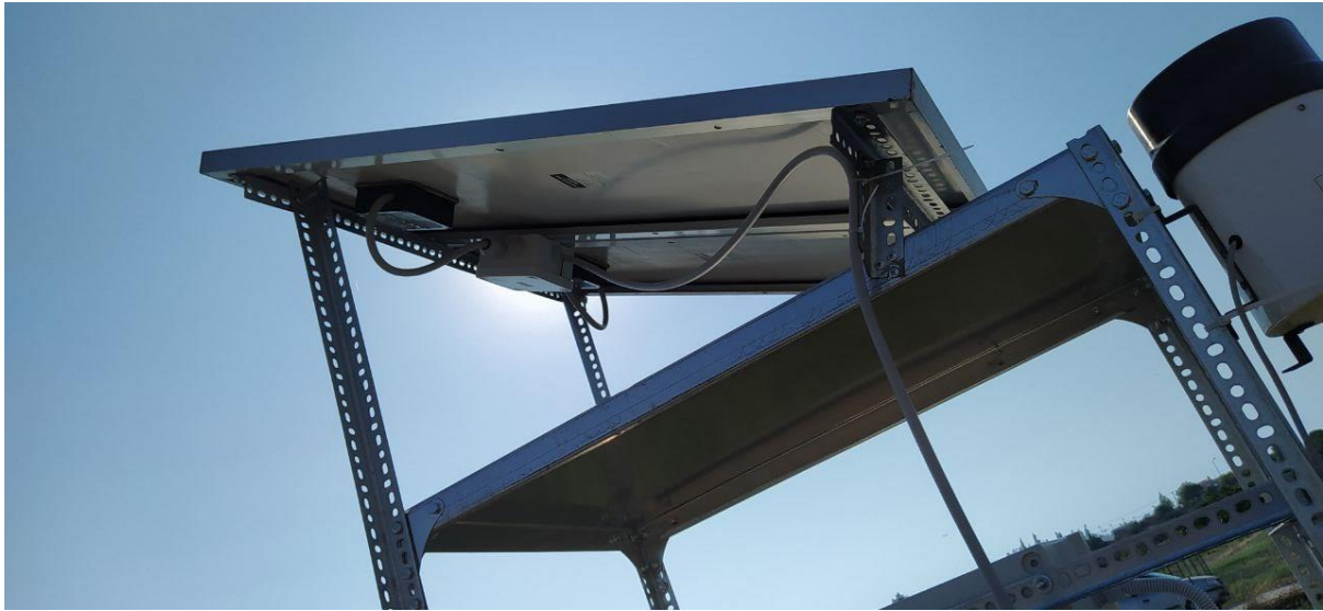
Εικόνα 25: Τα πάνελ τοποθετημένα στην κατασκευή
