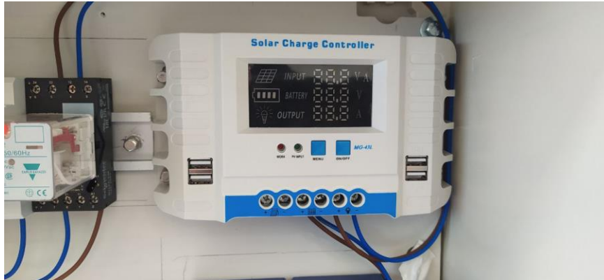
Εικόνα 45: Τοποθέτηση ελεγκτή φόρτισης
