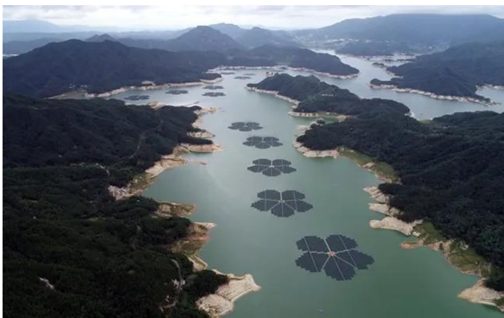
Εικόνα 3.3: Εγκατάσταση πλωτών Φ/Β σε σχήμα λουλουδιών στη Ν. Κορέα [57]
