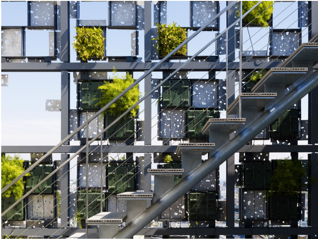
Εικόνα 15 Πάνελ πρόσοψης Green Cast, πηγή ArchDaily
