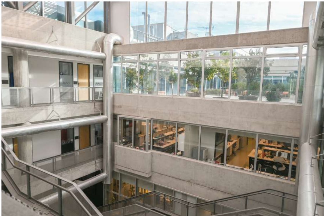
Εικόνα 14. Φωτογραφία από την επίσκεψη στις εγκαταστάσεις, 5/12/2022.
