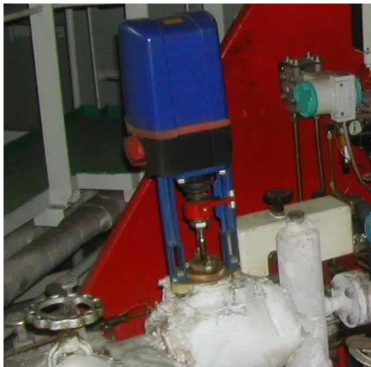
Εικόνα 4.24-Ηλεκτρικός Ενεργοποιητής [56].
