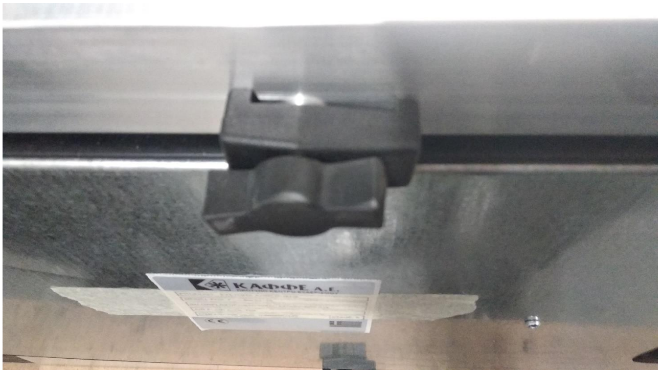
Προσθήκη ειδικού κλειστρου διασφάλισης της στεγανοποίησης της θύρας των φίλτρων.
