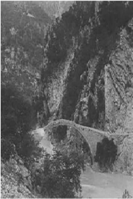
Εικόνα 8 Γέφυρα Κοράκου (Philippson Alfred, 1893)
