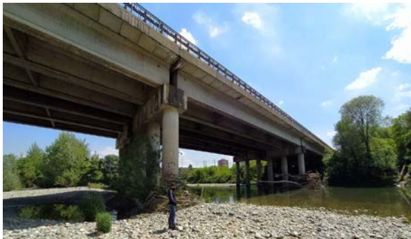
Εικόνα 13 Γέφυρα Stura - Τορίνο Ιταλίας (Gianluca Colia, 2021)
