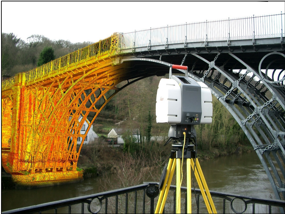
Εικόνα 20 Γεωμετρική Τεκμηρίωση Γέφυρας με Επίγειο Σαρωτή Λείζερ (Laser Scanner) ( geourbgroup.com , 2018)
