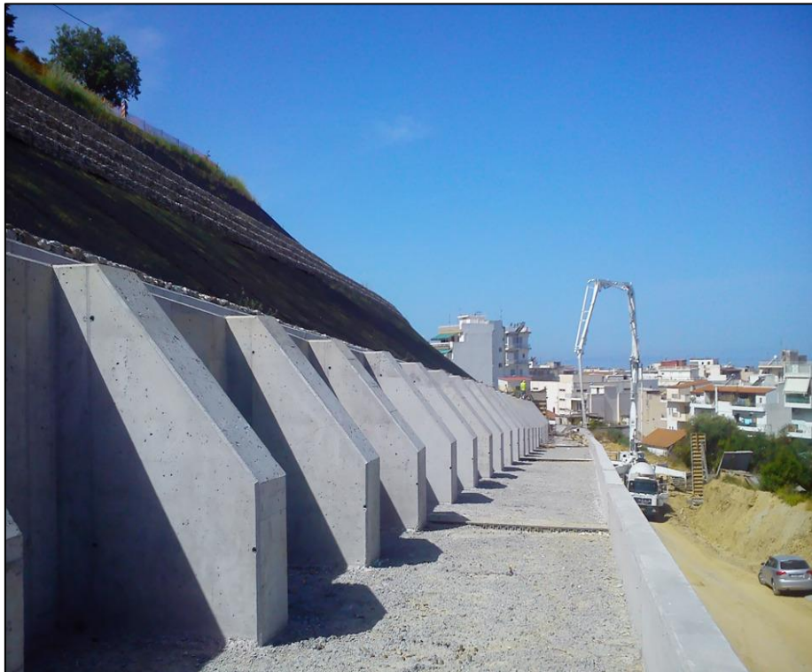
Σχήμα 1.6: Τοίχος αντιστήριξης από οπλισμένο σκυρόδεμα. (φωτογραφία από εργοτάξιο)
