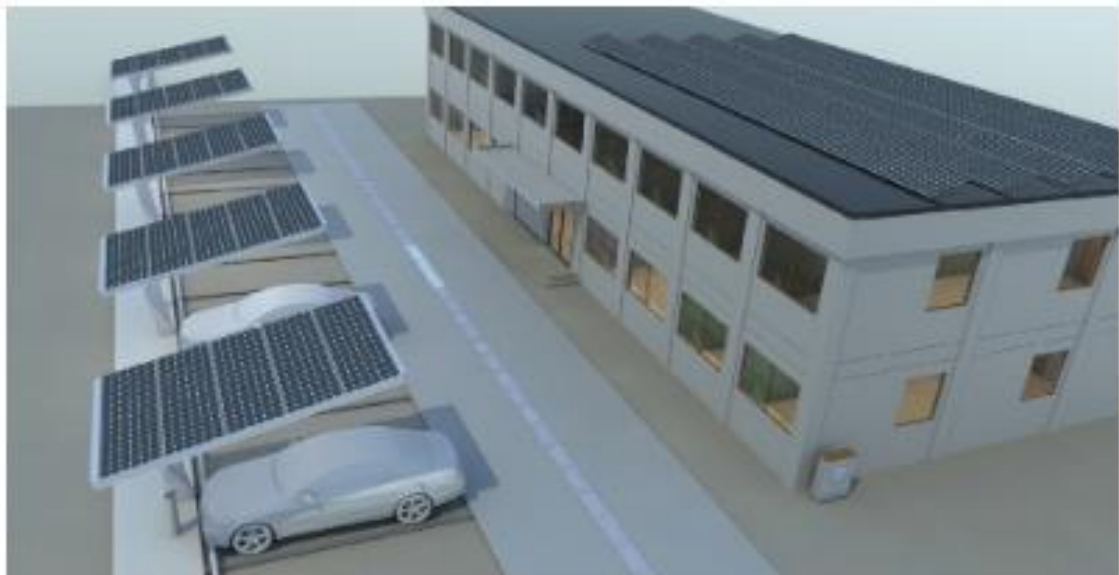
Σχήμα 4.2 Σταθμός φόρτισης βασισμένος σε ηλιακά πάνελ
