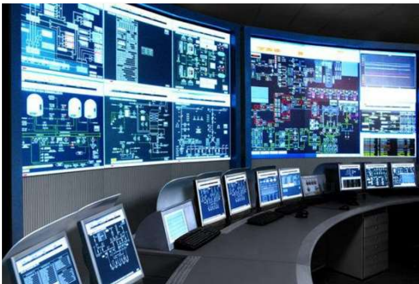
Εικόνα 40: Master Station Computer
