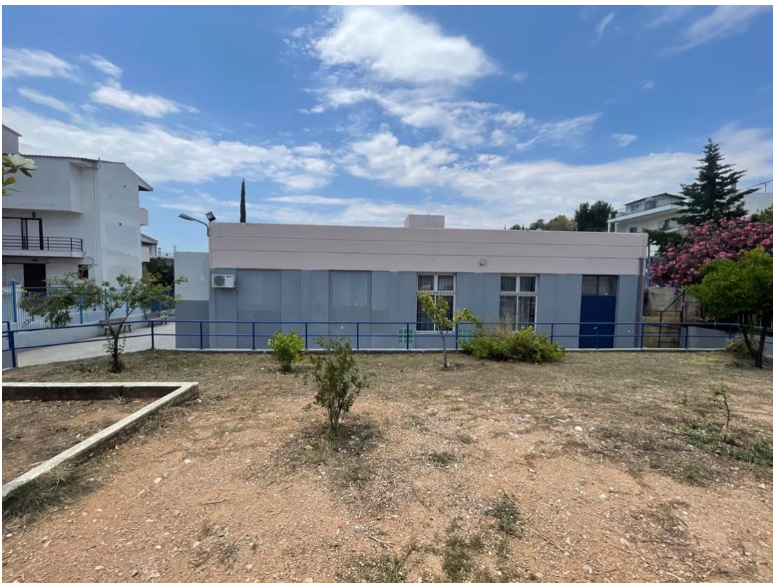
Εικόνα 3 Ανατολική Όψη Κτηρίου
