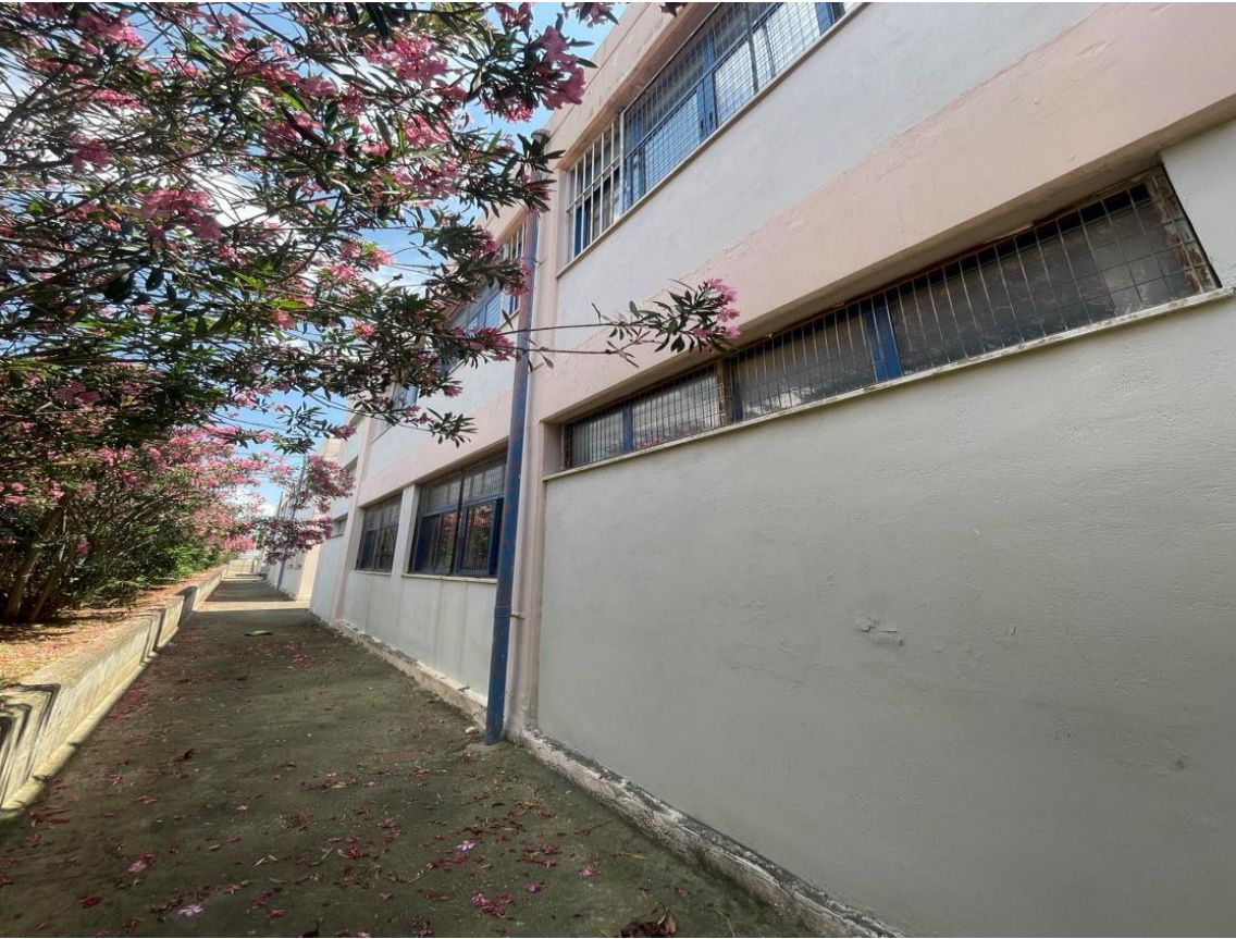
Εικόνα 6: Βόρεια Όψη Κτηρίου
