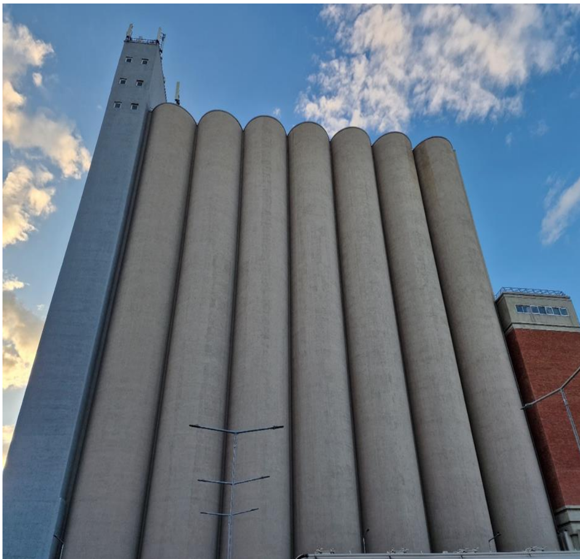
Εικόνα 7. Εξωτερική απεικόνιση του σιλό σίτου στην εγκατάσταση Κερασινίου των Μύλων Λούλη.
