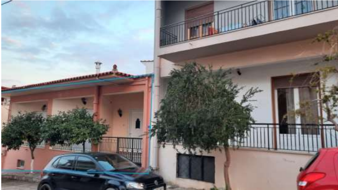
Εικόνα 7: Λήψη στην οποία διαφαίνεται το όμορο κτίριο από την βορειοανατολική πλευρά.
