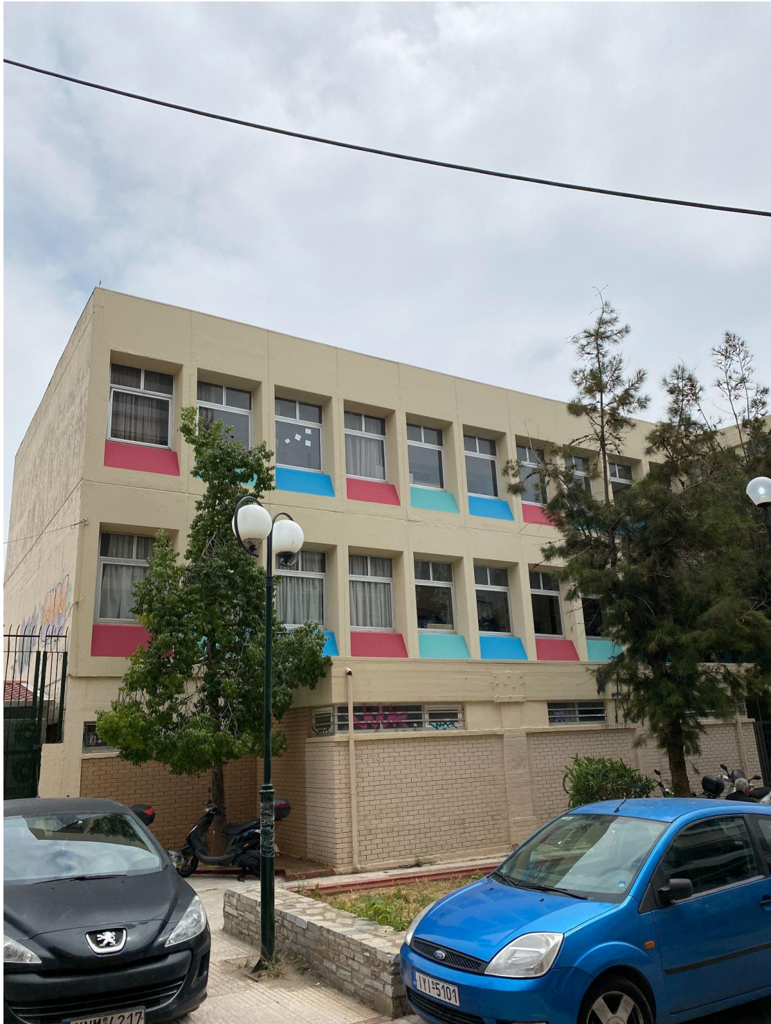
Εικόνα 24 Δυτική όψη κτιρίου Β'
