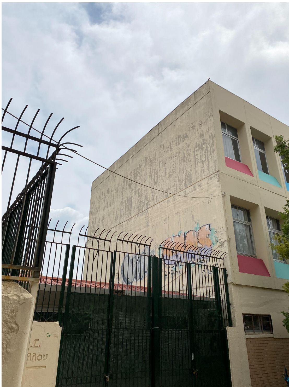
Εικόνα 26 Βόρεια όψη κτιρίου Β'
