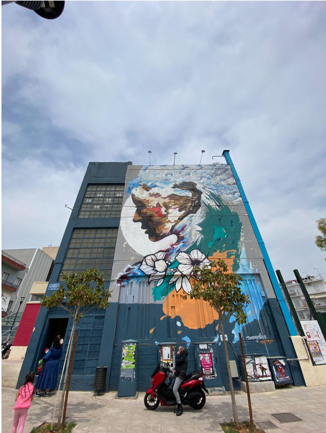
Εικόνα 27 Νότια όψη κτιρίου
