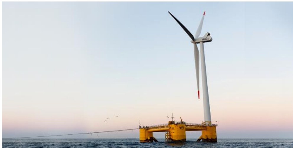
Εικόνα 3.8 - Πλωτή αιολική ανεμογεννήτρια - WindFloat Atlantic
