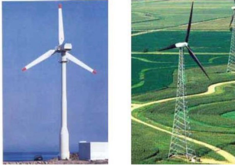
Εικόνα 2.6 - Ανεμογεννήτριες με Χαλύβδινους και Δικτυωτούς πυλώνες
