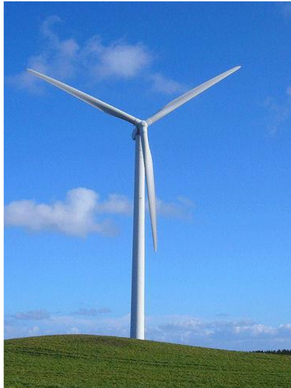
Εικόνα 2.2 - Τύπος ανεμογεννήτριας σε οριζόντιο άξονα
