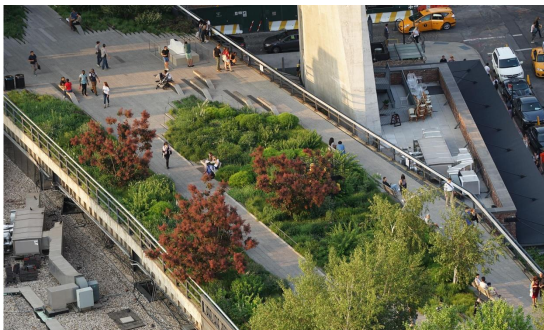
Εικόνα 19: High Line στη Νέα Υόρκη, (Πηγή: /www.thehighline.org)
