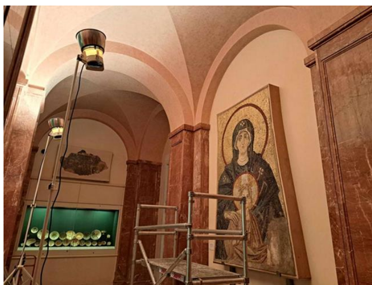
Εικόνα 52: Τοποθέτηση σκαλωσιάς και φωτιστικών πηγών κοντά στο αντίγραφο ψηφιδωτό «Θεοτόκος και Παιδί». Πηγή: Προσωπικό αρχείο.
