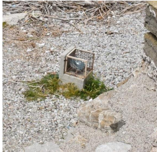
Εικόνα 4.16: Φωτιστικά μέσα σε προστατευτικούς κλωβούς. Πηγή: Τσαντίλα Ε.
