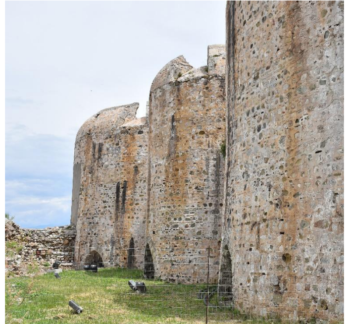
Εικόνα 4.9 & 4.10: Προβολέας Philips Decoflood MVF 617 (αριστερά) και κυκλικοί πύργοι κτισμένα κατά την οθωμανική περίοδο (δεξιά). Πηγή: Τσαντίλα Ε.
