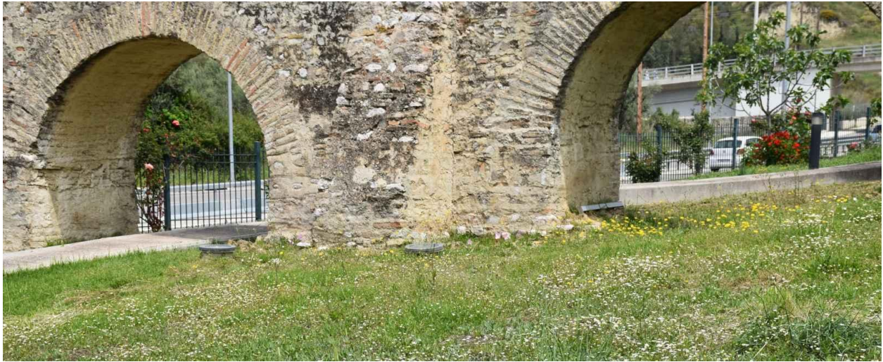
Εικόνα 4.47: Ενδοδαπέδια φωτιστικά για τον φωτισμό των κάθετων επιφανειών της υδατογέφυρας. Πηγή: Τσαντίλα Ε.
