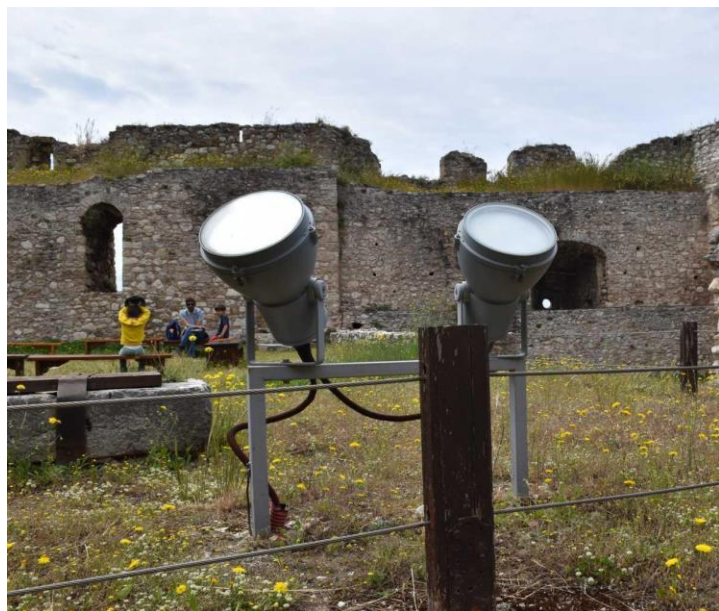
Εικόνα 4.35: Προβολείς με φακό φερνέλ για την προέκταση της φωτεινής δέσμης. Πηγή: Τσαντίλα Ε.
