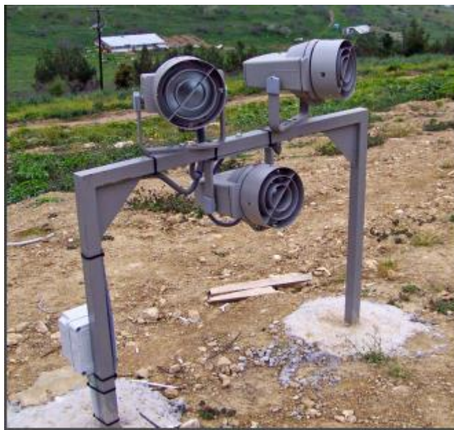
Εικόνα 3.8: Παράδειγμα φωτιστικών με αντιθαμβωτικές περσίδες. Πηγή: Κάπος Κ.
