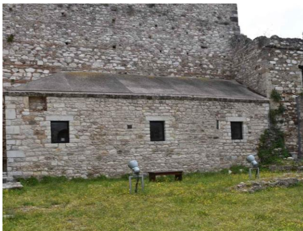
Εικόνα 4.36: Προβολέας με ευρεία δέσμη (αρ.) και προβολείς με φίλτρα φερνέλ (δεξ.). Πηγή: Τσαντίλα Ε.
