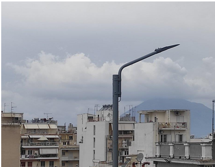
Εικόνα 5.17: Φωτιστικό οδοφωτισμού Led. Πηγή: Λήψη Τσαντίλα Ε.
