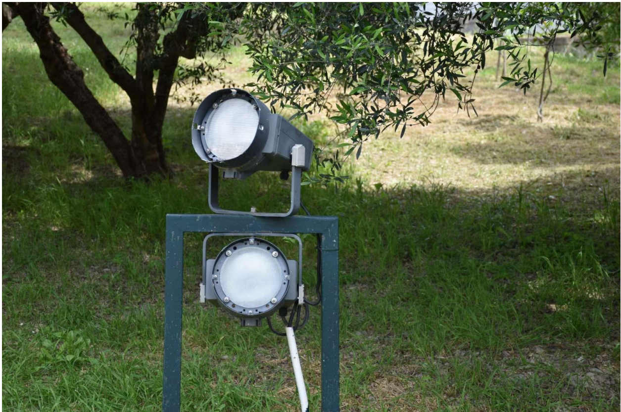
Εικόνα 4.44: Προβολέας με φακούς φερνέλ για την προέκταση της δέσμης. Πηγή: Τσαντίλα Ε.
