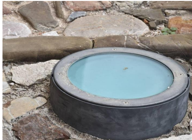
Εικόνα 4.33:Φωτιστικά φωτισμού κάθετων επιφανειών. Πηγή: Τσαντίλα Ε.
