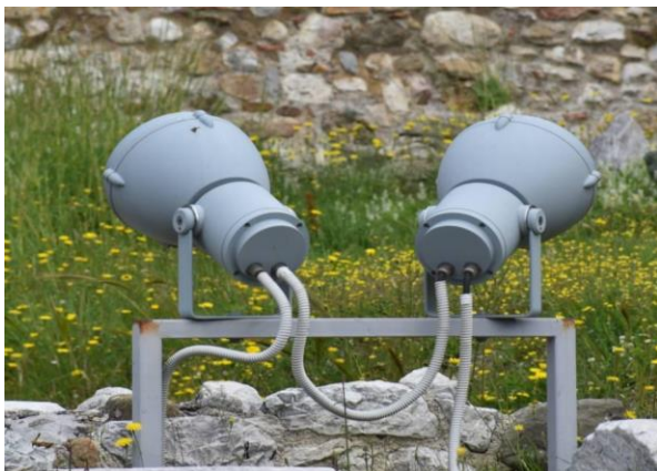
Εικόνα 4.32: Προβολείς που χρησιμοποιούνται για την ανάδειξη των πύργων. Πηγή: Τσαντίλα Ε.
