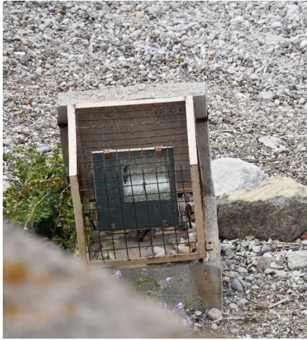
Εικόνα 4.16: Φωτιστικά μέσα σε προστατευτικούς κλωβούς. Πηγή: Τσαντίλα Ε.
