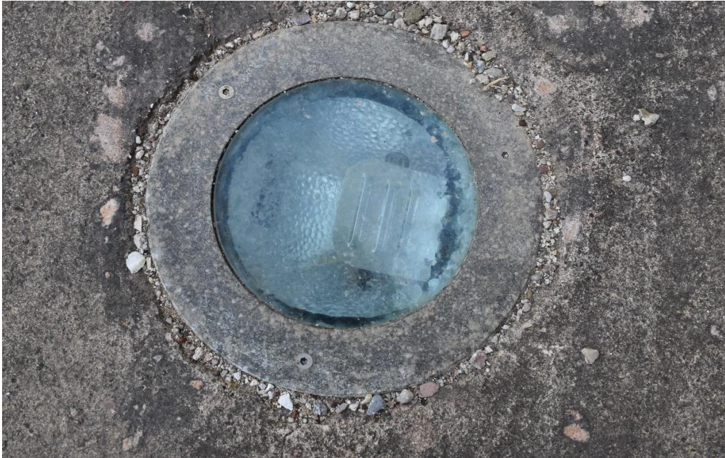
Εικόνα 3.7: Παράδειγμα μη γραμμικού χωνευτού φωτιστικού. Πήγη: Λήψη Τσαντίλα Ε.
