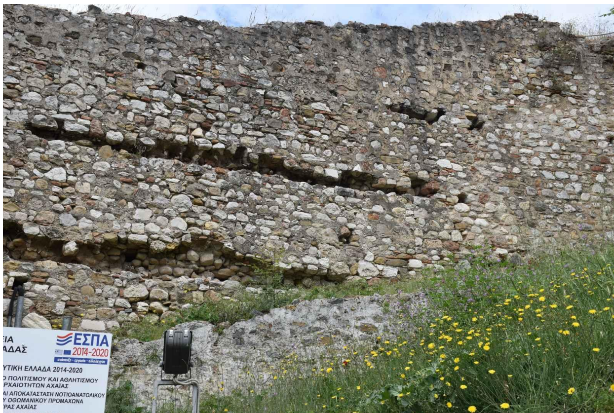
Εικόνα 4.28: Φωτιστικά κατά μήκος της εξωτερικής τάφρου. Πηγή: Τσαντίλα Ε.
