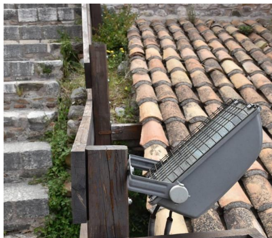
Εικόνα 4.36: Προβολέας με ευρεία δέσμη (αρ.) και προβολείς με φίλτρα φερνέλ (δεξ.). Πηγή: Τσαντίλα Ε.
