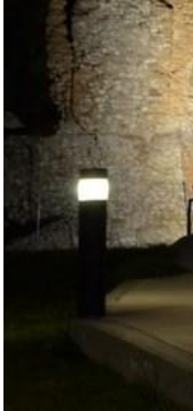
Εικόνα 3.4: Φωτιστικό τύπου «φανάρι» στο Ρωμαϊκό Υδραγωγείο Πατρών. Πηγή: www.thebest.gr/article/595157-gnoriste-to-romaiko-ydragogeio-tis-patras-mesa-apo-mia-uperochi-archaiologiki-tainia-binteo
