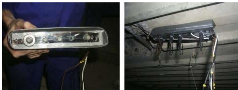
Εικόνα 6-2: Τοποθέτηση αισθητήρων επί της κατασκευής (I. Martínez & C. Andrade, 2009) [25]
