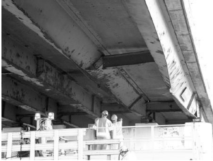
Εικόνα 9-5: Βλάβη από πρόσκρουση (Courtesy of New York State Department of Transportation) [37]
