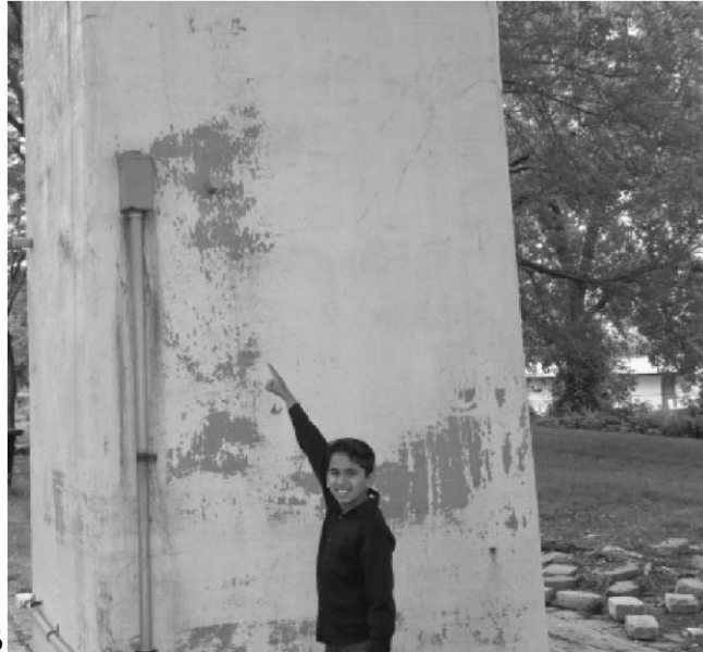
Εικόνα 6-4: Τοποθέτηση εξωτερικά αισθητήρα διάβρωσης (Ettouney & Alampalli, 2012) [27]
