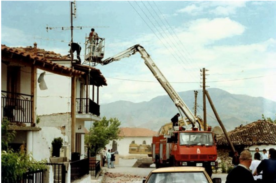
Εικόνα 15.Επισκευάσιμο κτήριο- Σεισμός 13.5.1995 Γρεβενά-Κοζάνη (προσωπικό αρχείο)
