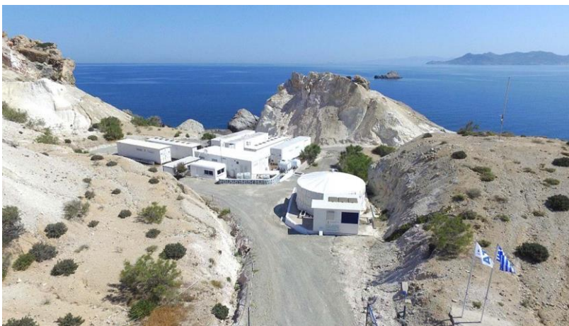
Εικόνα 19. Μονάδα αφαλάτωσης βασισμένη στην αιολική ενέργεια & στην τεχνολογία της αντίστροφης ώσμωσης στη Μήλο (itagroup.gr, 2021)
