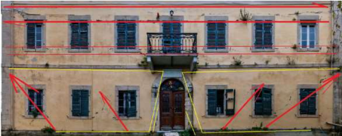
Σχήμα 3.48 Συμπεριφορά βλαβών δυτικής όψης (VR_Architects, et al., 2022)
