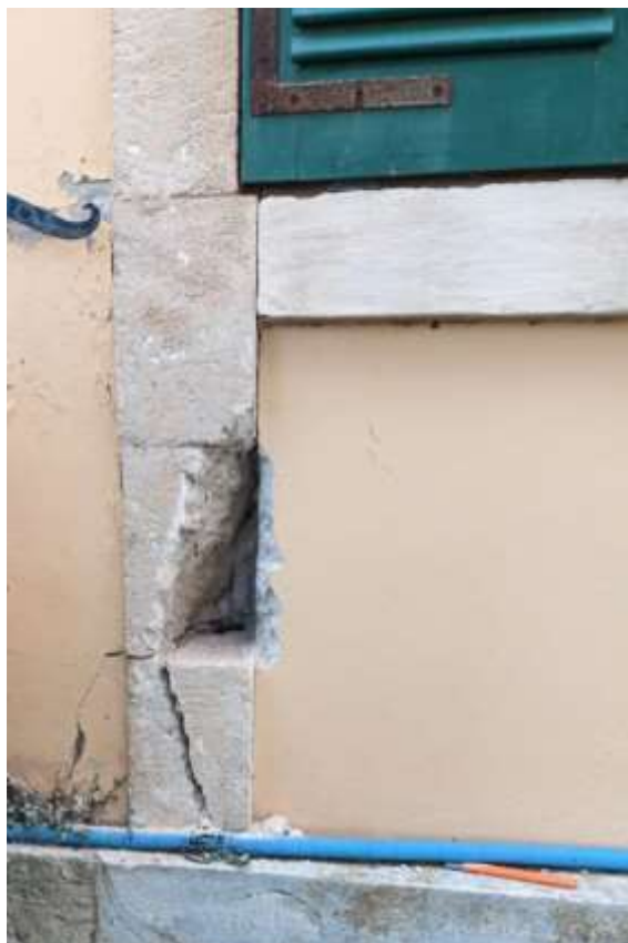
Σχήμα 3.16 Οξειδωμένος οπλισμός στο σημείο α, σύνδεση τοίχου με ποδιά παραθύρου (αριστερά) & λεπτομέρεια (δεξιά) (Αλεξιάδης κ.α., 2022)
