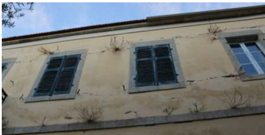
Σχήμα 2.11 Λεπτομέρεια κλειστών εξωφύλλων (σκούρα) Α' ορόφου
