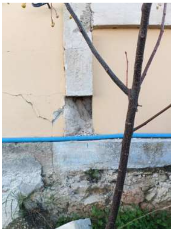
Σχήμα 3.17 Οξειδωμένος οπλισμός στο σημείο β, σύνδεση τοίχου με ποδιά παραθύρου (αριστερά) & λεπτομέρεια (δεξιά) (Αλεξιάδης κ.α., 2022)
