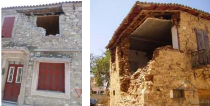
Σχήμα 3.41 Τοπικοί μηχανισμοί (Πηγές: https://eclass.duth.gr/modules/document/file.php/TMB325/%2010.6%20Masonry%20-%20Behavior%20and%20example.pdf & https://www.oasp.gr/node/2067 )
