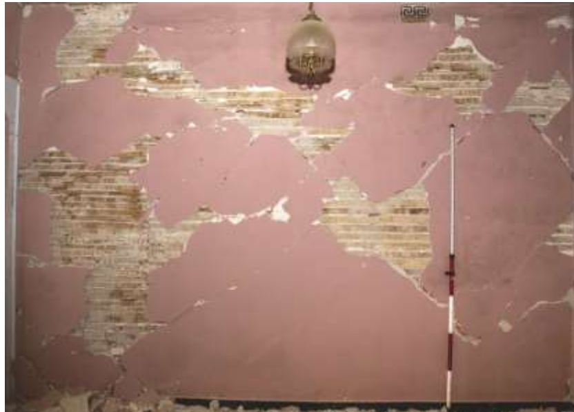
Σχήμα 5.2 Λεπτομέρεια εσωτερικού τοίχου με την τεχνική μοροφίντο
