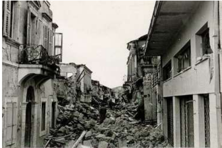
Σχήμα 1.3 Το αποτέλεσμα του σεισμού (Πηγή: https://gerryco23.wordpress.com/2015/05/24/the-ruins-of-kefalonia/ )
