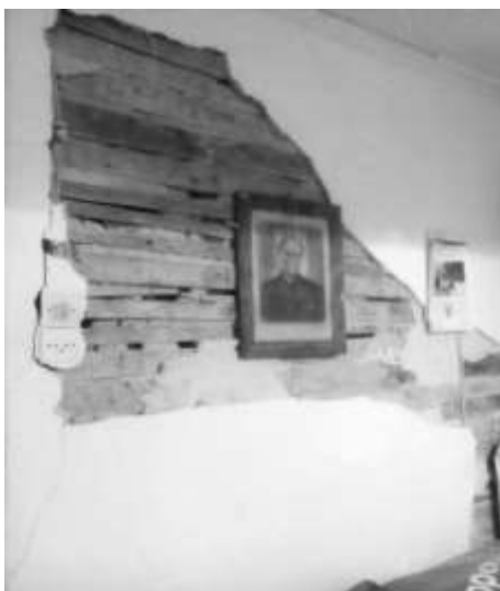
Σχήμα 2.4 Ενδεικτικός τοίχος μοροφίντο (Σελ.2201(9/13), (Theotokatou, 2019))
