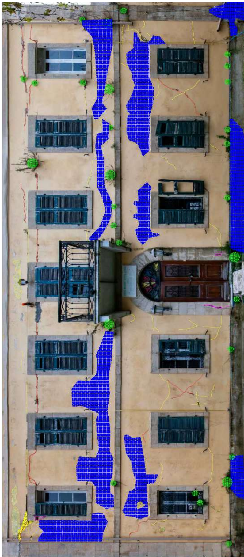
Σχήμα 3.51 Παθολογία δυτικής όψης (Από μελέτη Ομάδας Έργου (VR_Architects, et al.,
