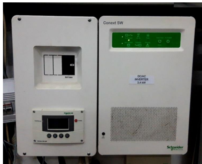
Εικόνα 9: Αντιστροφέας ισχύος πειραματικής διάταξης
