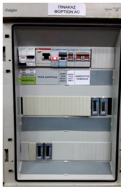
Εικόνα 19: Πίνακας AC φορτίων πειραματικής διάταξης
