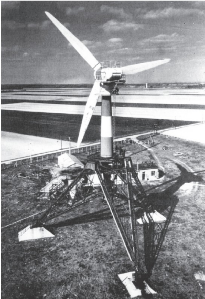
Εικόνα 1.1.9 : Ανεμογεννήτρια Best-Romani στο Nogent-le-Roi (Eure et Loir), Γαλλία, 1958. (Πηγή: Jos Beurskens – The History of Wind Energy)
