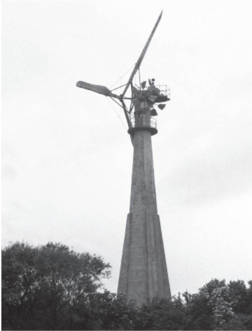
Εικόνα 1.1.6 : Μια εκτός λειτουργίας Smith ανεμογεννήτρια στη Δανία, με διάμετρο δρομέα 24m και ονομαστική ισχύ περίπου 70 kW. Φωτογραφία του Paul Smulders το 1972 (Beurskens, 2014).
