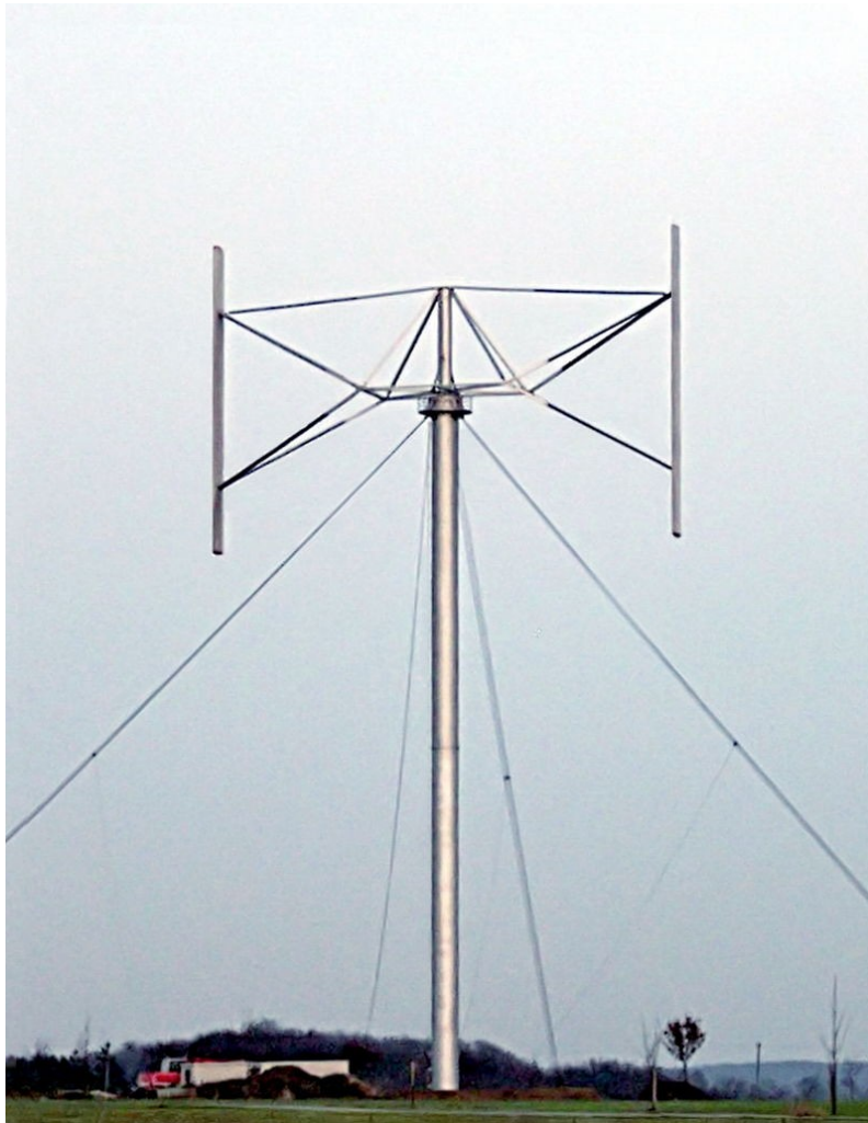
Εικόνα 2.1.2 : Ανεμογεννήτρια κάθετου άξονα τύπου Giromill. (φωτογραφία τραβηγμένη από Stahlkocher – Πηγή Wikimedia Commons)
