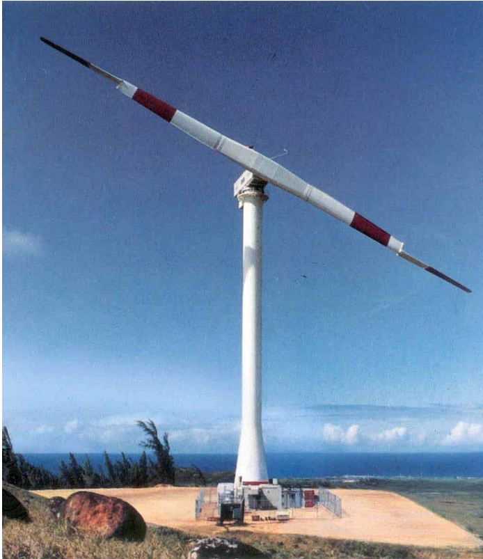
Εικόνα 2.2.4 : Ανεμογεννήτρια οριζοντίου άξονα με δύο πτερύγια στο νησί Oahu της Χαβάης – Φωτογραφία από NASA Glenn Research Center. ( https://commons.wikimedia.org/ )
