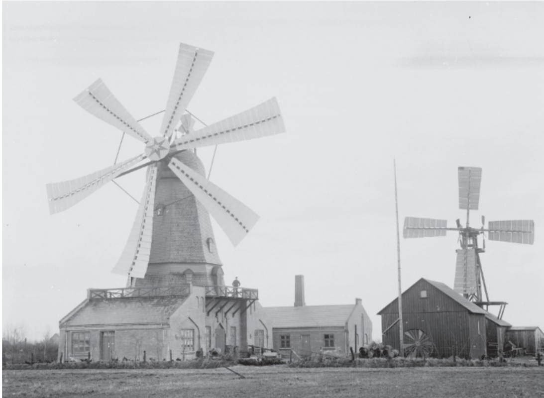
Εικόνα 1.1.4 : Δεξιά η δοκιμαστική ανεμογεννήτρια του Poul la Cour το 1891 στη Δανία. Αριστερά μια μεγαλύτερη ανεμογεννήτρια το 1897 (Beurskens, 2014).
