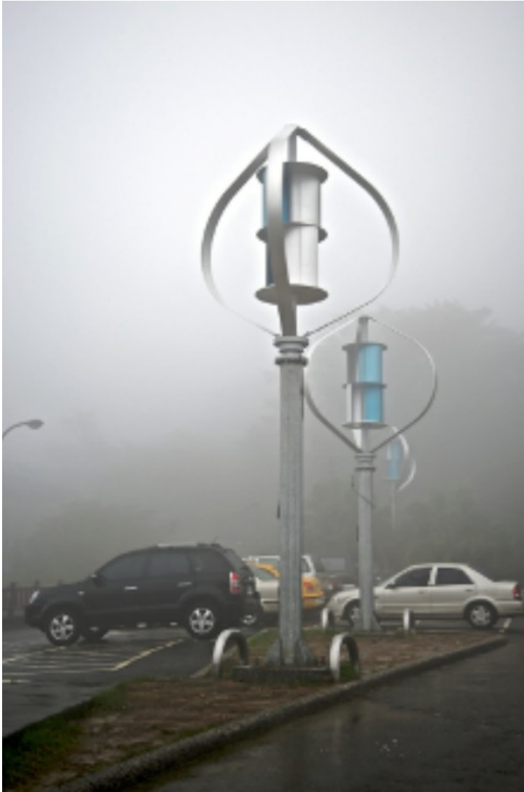
Εικόνα 2.1.4 : Ανεμογεννήτρια κάθετου άξονα τύπου συνδυασμός Darrieus-Savonius (Corke & Nelson, 2018).
