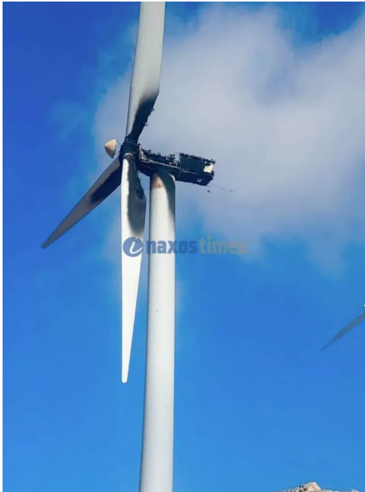
Εικόνα 3.2 : Φωτογραφία της ανεμογεννήτριας που πήρε φωτιά στην Νάξο. ( Πηγή: Naxos Times)
