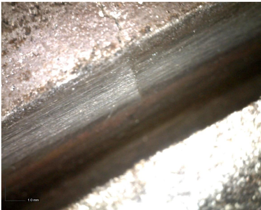
Εικόνα 84 Συνέχεια της ρωγμής στην επιφάνεια
