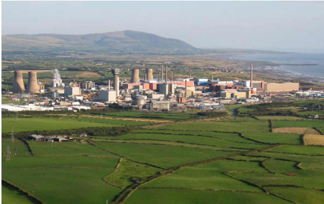
Εικόνα 23. Το πυρηνικό εργοστάσιο Sellafield (πηγή: https://en.wikipedia.org/wiki/Sellafield )
