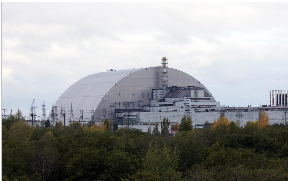
Εικόνα 14. Η σαρκοφάγος πάνω από τον εκτεθειμένο αντιδραστήρα (πηγή: https://el.wikipedia.org/wiki/Πυρηνικό_ατύχημα_του_Τσερνόμπιλ#/media/Αρχείο:NSC-Oct-2017.jpg )
