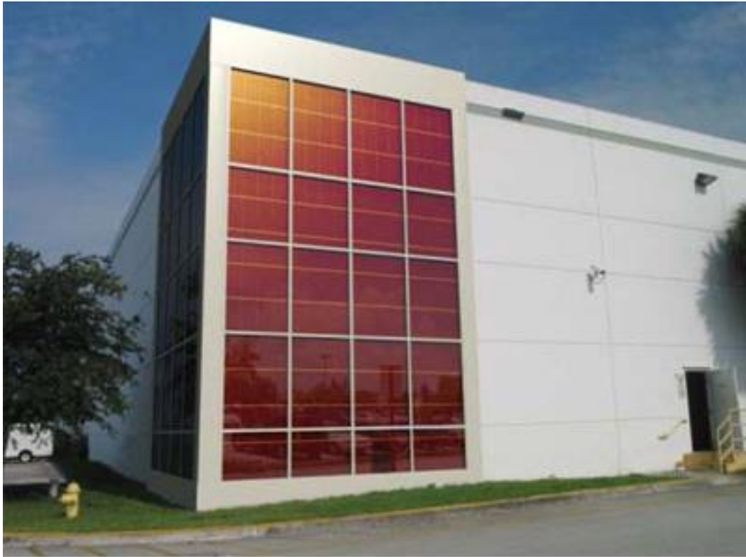
Εικόνα 2. 13: Φ/Β πλαίσια στην όψη κτιρίου ( https://www.decobook.gr/tecnica-arthra/oikologiki-domisi/441-2010-10-10-19-35-46 )
