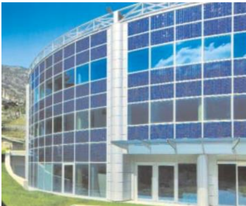
Εικόνα 2. 14: Φ/Β σκίαστρα σε κτίριο (Τσούτσου & Γκούσκος, 2010)
