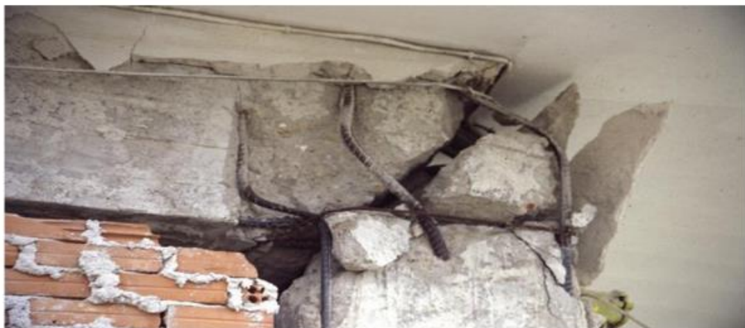
Εικόνα 3. 7: Αστοχία εξωτερικού κόμβου και πρακτική απώλεια στήριξης (Γιαννόπουλος, 2005)
