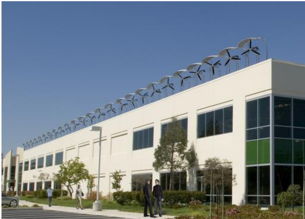
Εικόνα 2. 17: Ανεμογεννήτριες οριζόντιου άξονα σε στέγη κτιρίου (EWEA, 2021)
