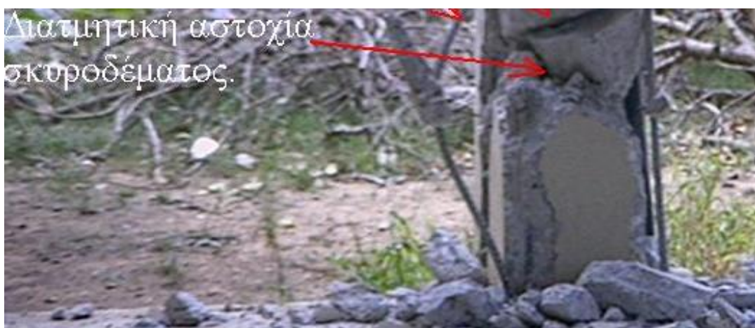
Εικόνα 3. 4: Διατμητική αστοχία υποστυλώματος ( http://ecourses.dbnet.ntua.gr/9420.html )
