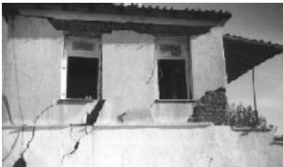
Εικόνα 3. 9: Ψαθυρή βλάβη τοιχίων ( http://teicm.panaqop.com/files/ferousa/yliko/Sariqianni/7o_Mathima.pdf )
