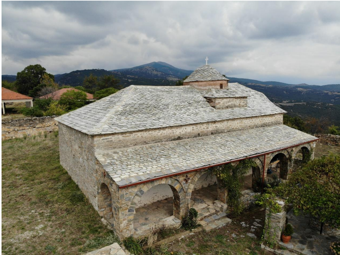
Εικ. 40. Νοτιοδυτική άποψη του καθολικού.
