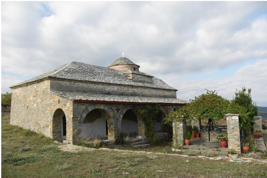
Εικ. 19. Νοτιοδυτική άποψη του Καθολικού.
