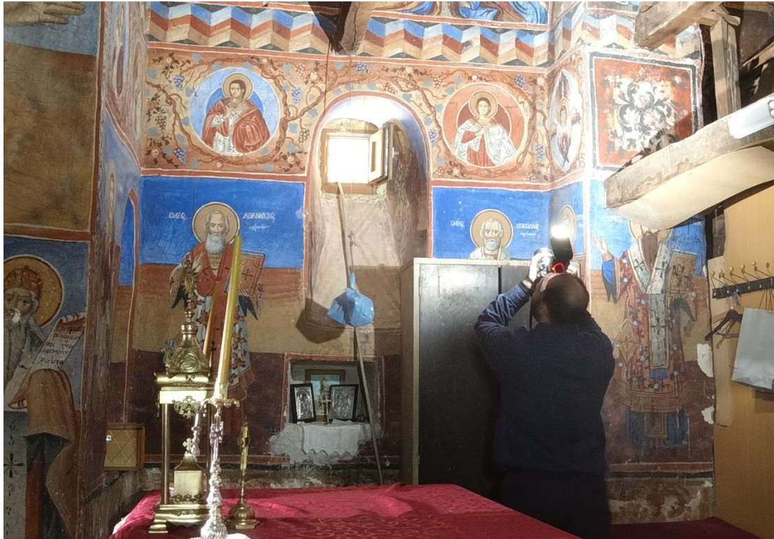
Εικ. 31. Αβαθής εσοχή νότιου τοίχου Ιερού Βήματος.
