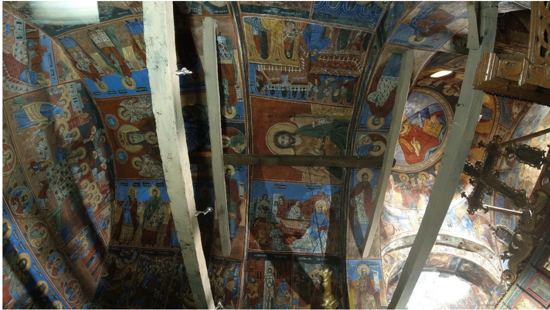
Εικ. 48. Ελκυστήρες στο εσωτερικό του ναού.
