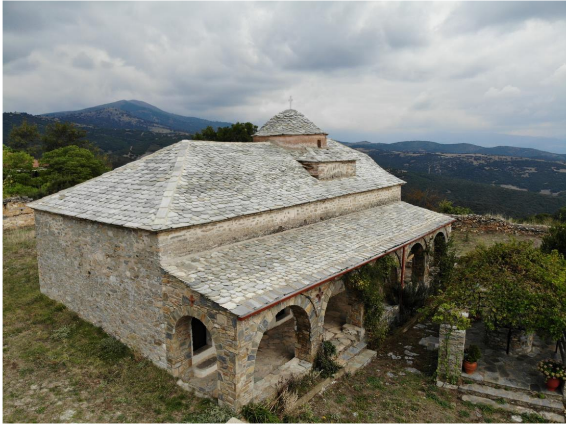
Εικ. 54. Το καθολικό. Νοτιοανατολική άποψη. Αεροφωτογραφία
