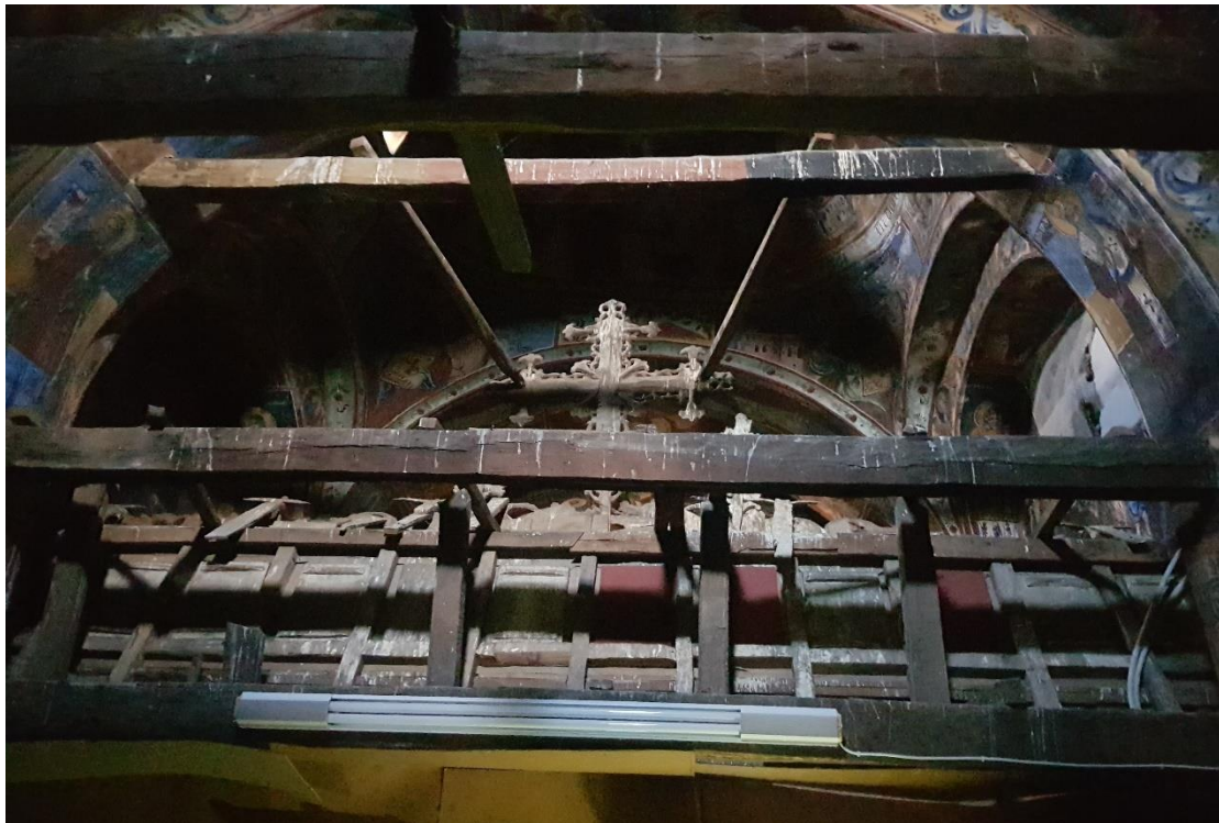
Εικ. 49. Ελκυστήρες στο Ιερό Βήμα πίσω από το τέμπλο.
