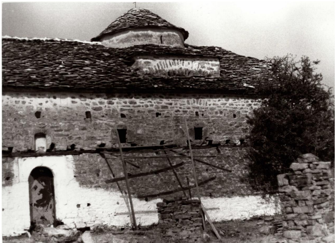
Εικ. 47. Νότια άποψη του καθολικού χωρίς την στοά. (Αρχείο ΕΦΑ Λάρισας 19-10-1993)
