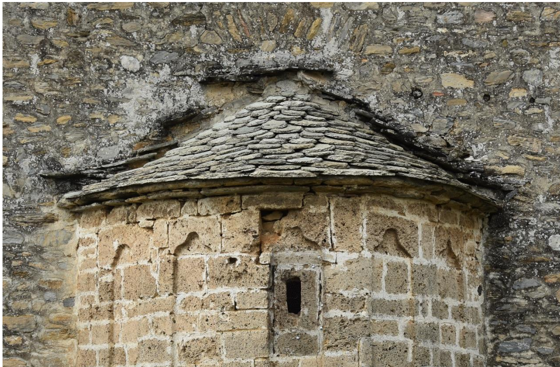
Εικ. 58. Λεπτομέρεια στέγασης κόγχης Ιερού Βήματος.
