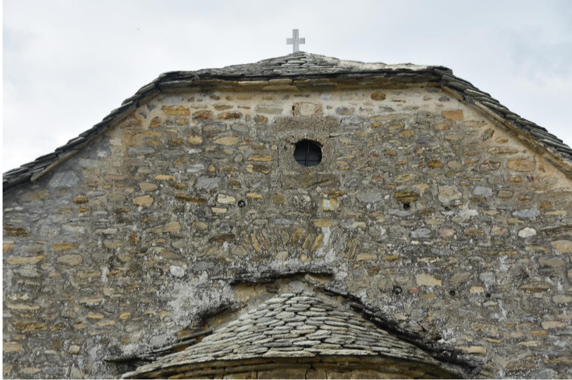
Εικ. 60. Κυκλικός φεγγίτης ανατολικής όψης.
