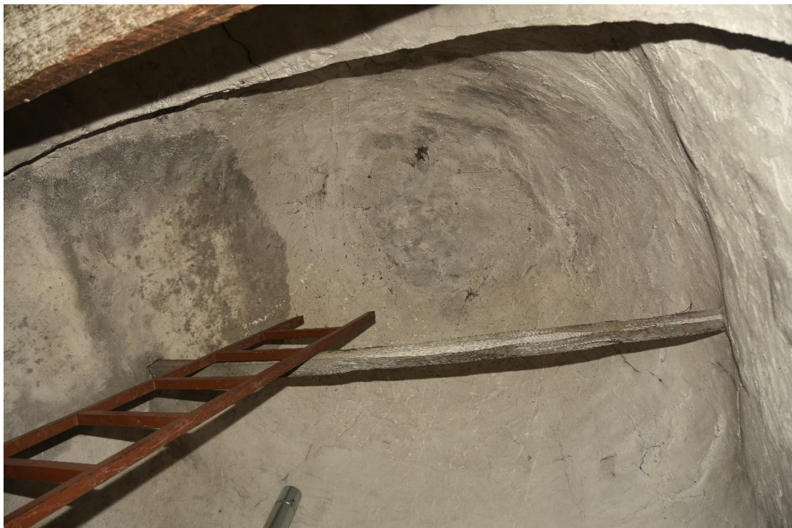
Εικ. 51. Ελκυστήρες βόρειου φουρνικού του νάρθηκα.
