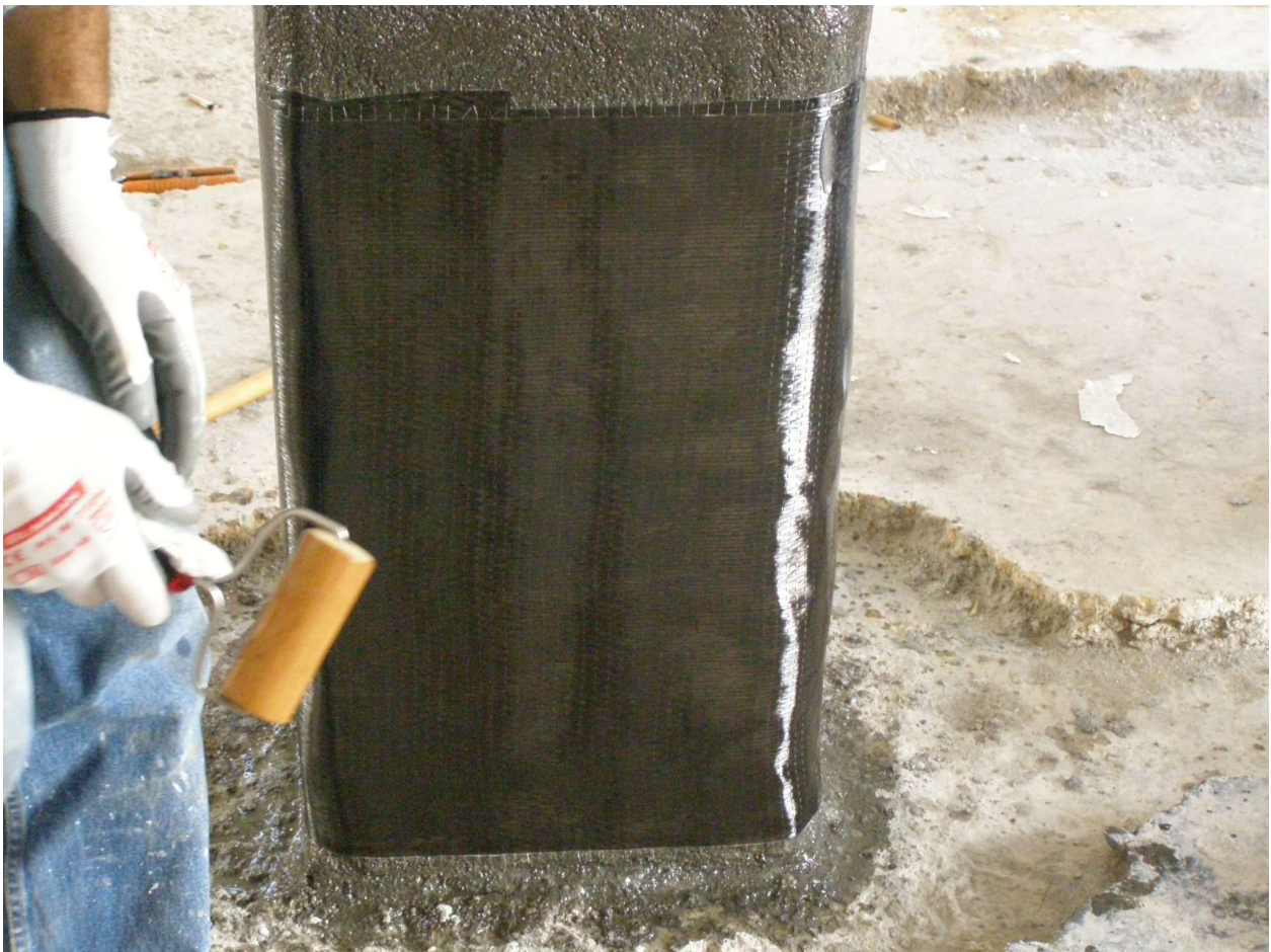
Εφαρμογή ανθρακούφασματος σε υποστήλωμα
