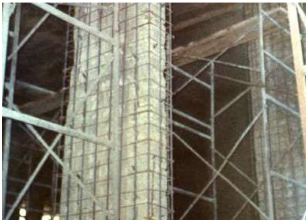
4 Ενίσχυση υποστυλώματος με μανδύα
