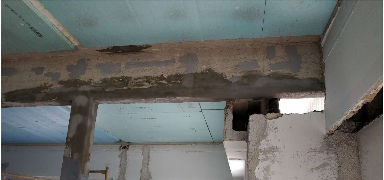
Προετοιμασία επιφανειών που θα δεχτούν ελάσματα
