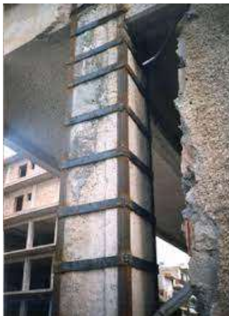
Ενίσχυση υποστηλώματος με λάμες
