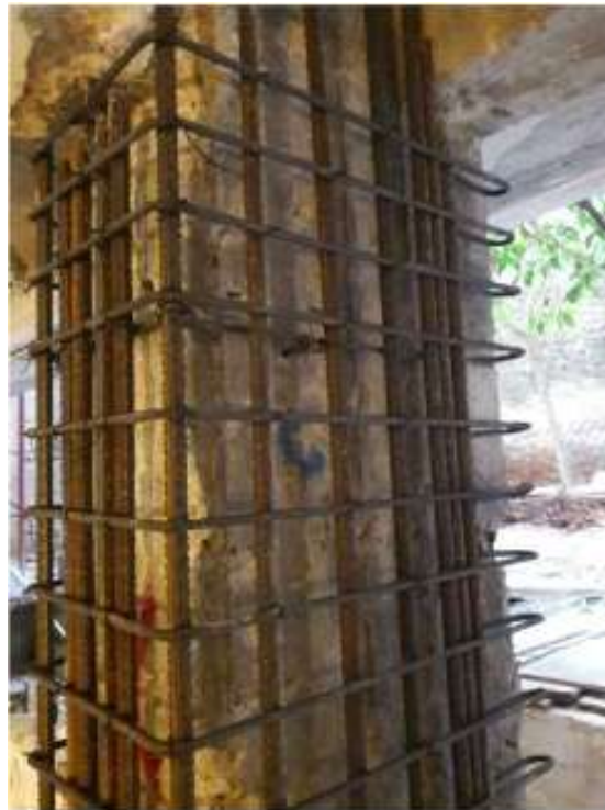
Τοποθέτηση οπλισμού μανδύα σε υποσύλωμα
