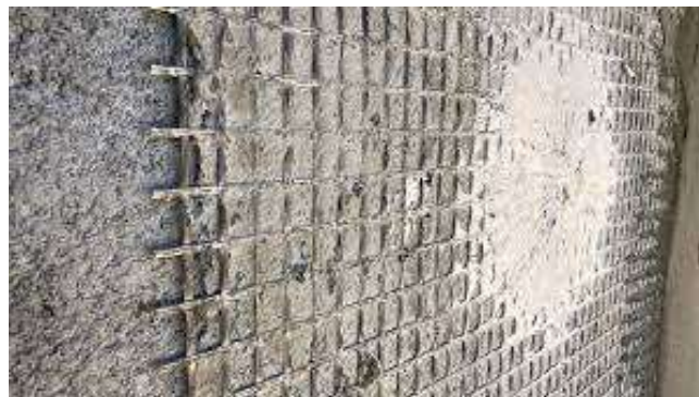
Αποκατάσταση τοιχοποιίας με ίνες υάλου
