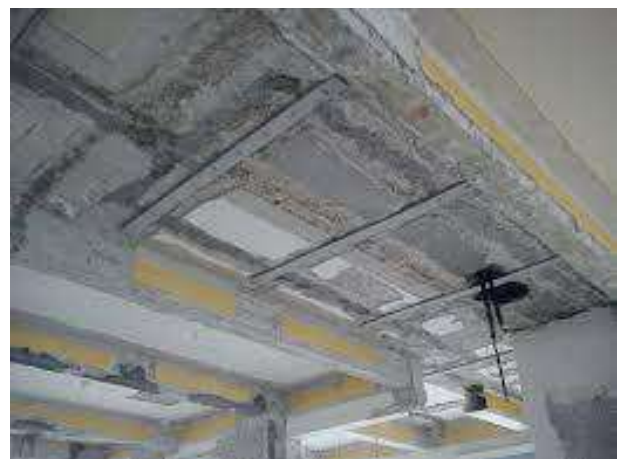
- 2 Εφαρμογή χαλυβδοελασμάτων σε πλάκα
