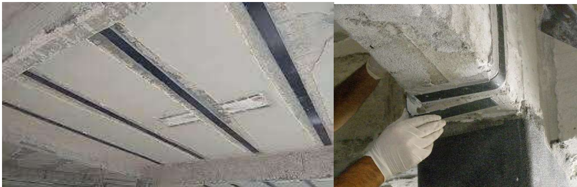
1 Εφαρμογή ανθρακοελασμάτων σε πλάκα
