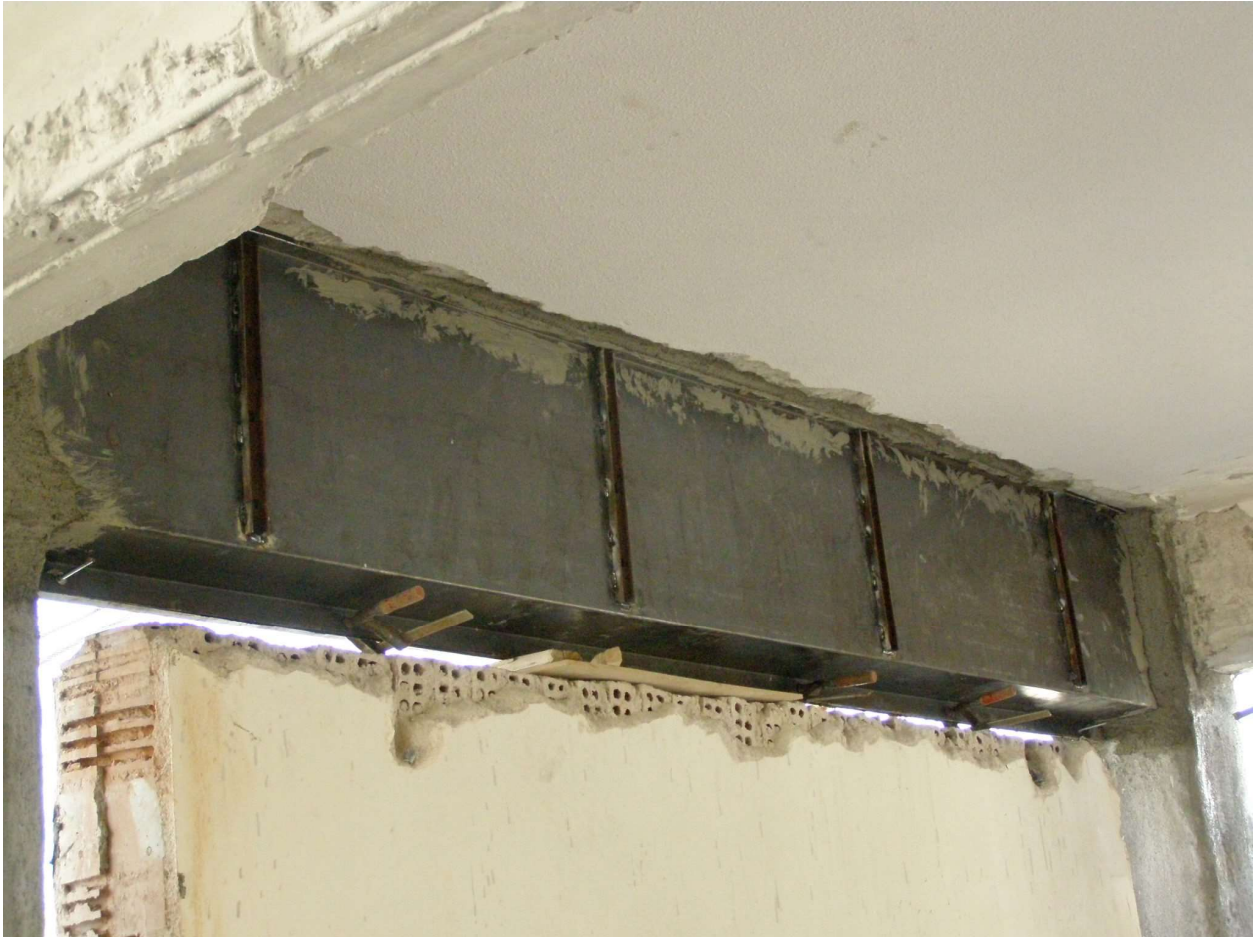
Αποκατάσταση δοκού με έγχυτο σκυρόδεμα
