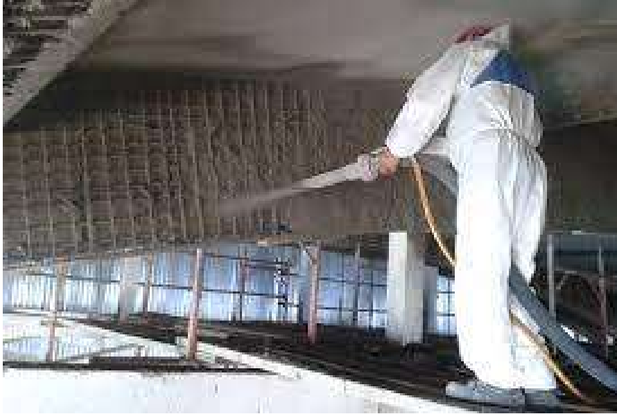
Εφαρμογή εκτοξευόμενου σκυροδέματος σε δοκό που ενισχύθηκε ο οπλισμός της με προσθήκη πλέγματος εξωτερικά
