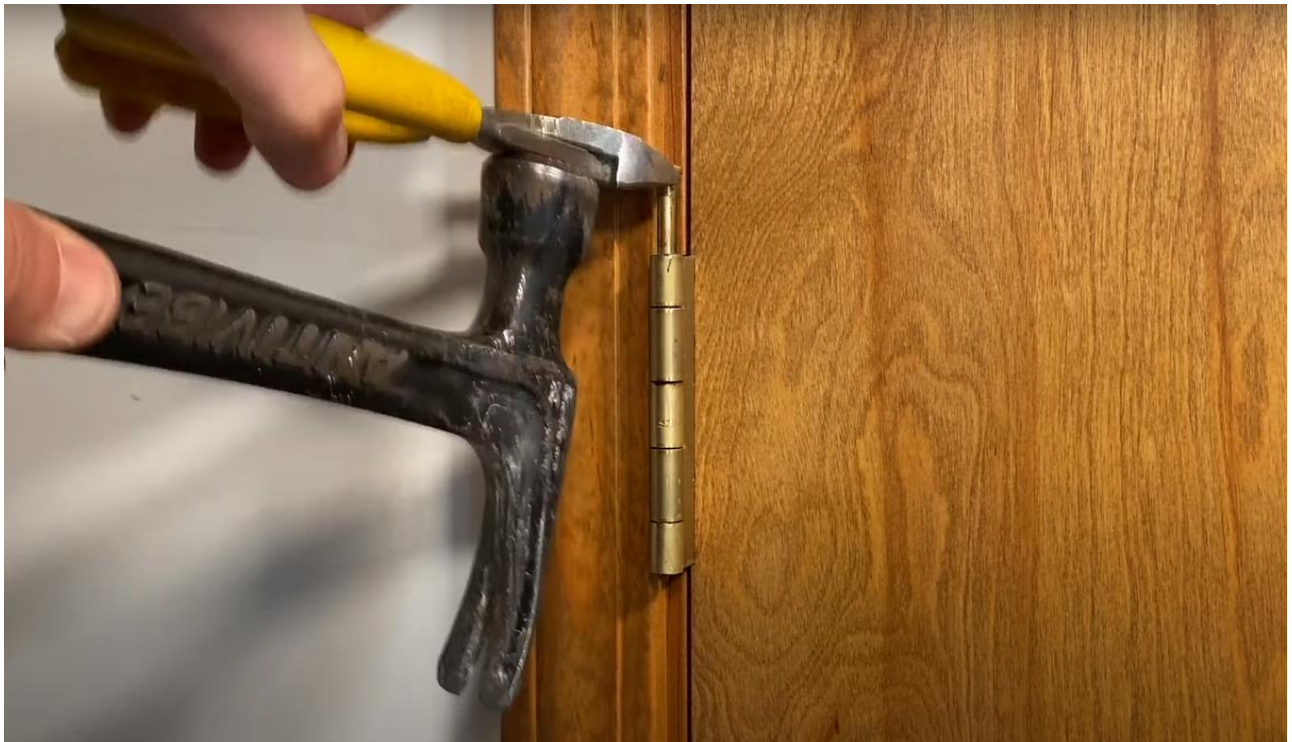
Εικόνα 1.10: Αφαίρεση μεντεσέδων εσωτερικών θυρών ( channel=AmericanTradeMasters )
