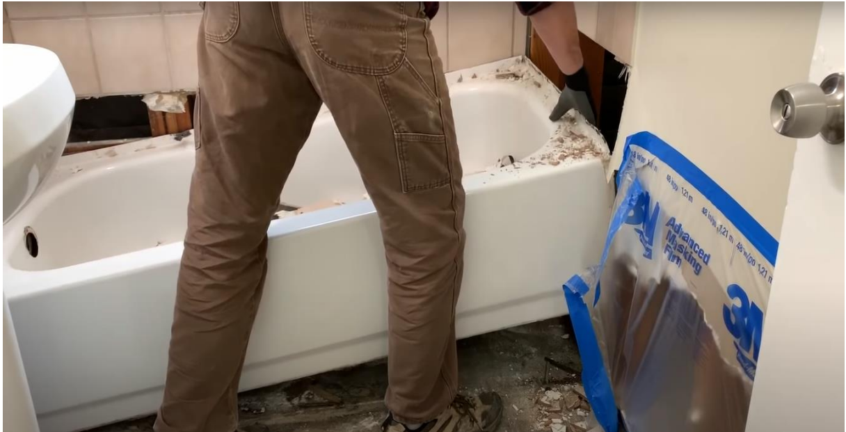
Εικόνα 1.6: Καθαίρεση μπανιέρας. ( channel=ToolRev )
