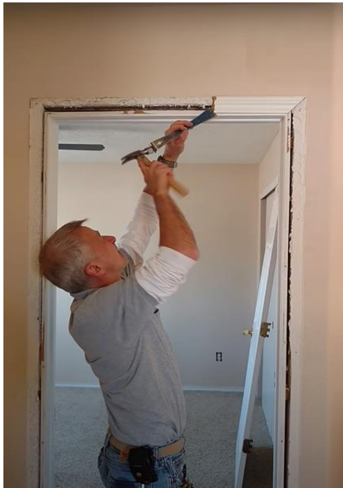
Εικόνα 1.9: Αποξήλωση κάσας εσωτερικής θύρας
