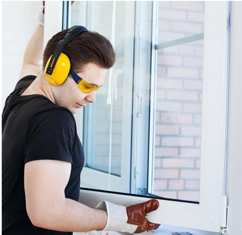
Εικόνα 2.13: Τοποθέτηση κουφώματος αλουμινίου ( https://fenestral.gr/ )
