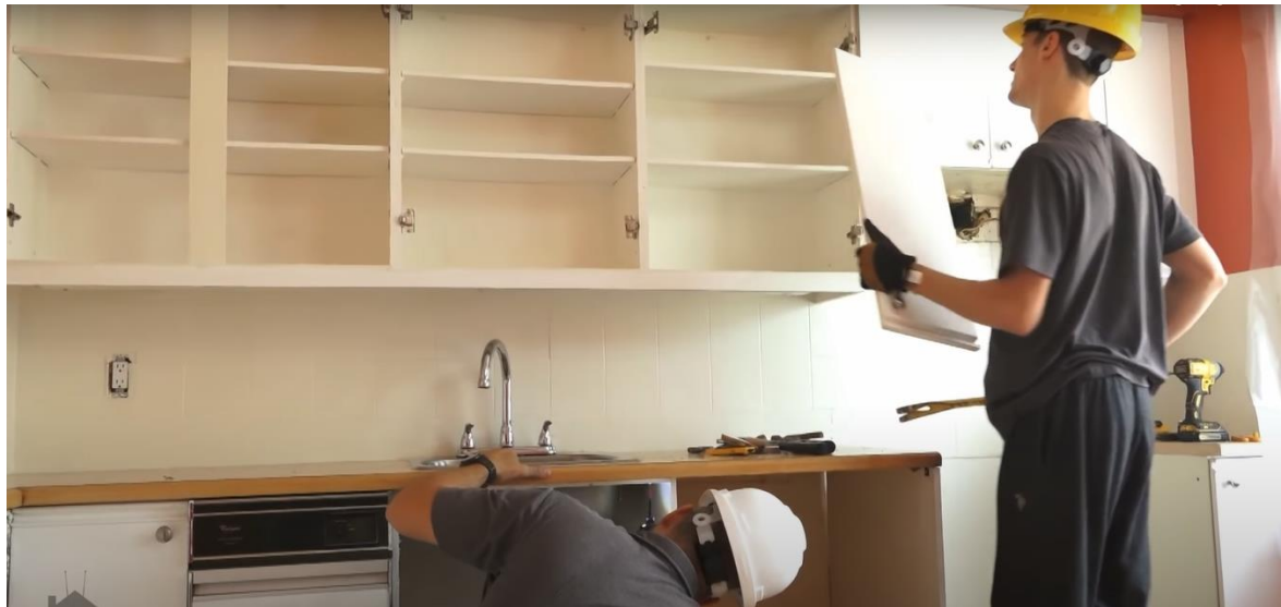
Εικόνα 1.8: Καθαίρεση ντουλαπιών κουζίνας
