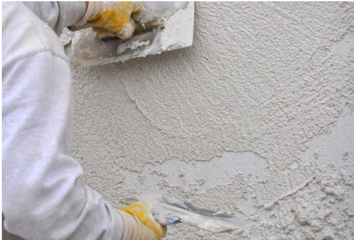
Εικόνα 2.4: Σοβάτισμα τοιχοποιίας
