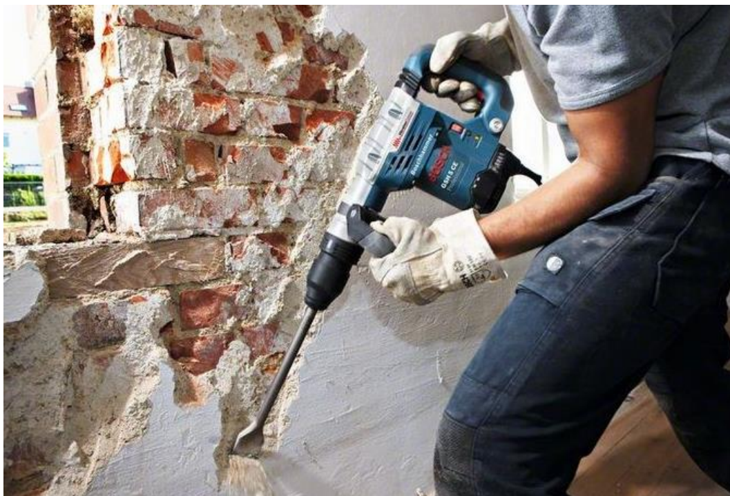
Εικόνα 1.3: Καθαίρεση σοβάδων.
