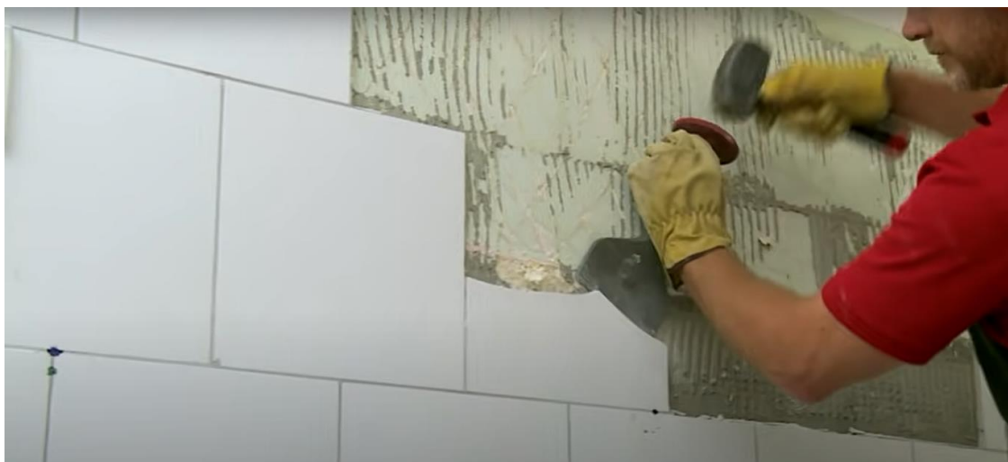
Εικόνα 1.7: Καθαίρεση πλακιδίων μπάνιου ( channel=BunningsWarehouse )
