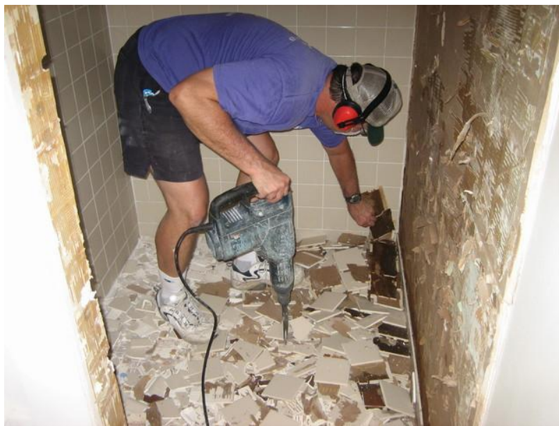
Εικόνα 1.4: Αποξήλωση μαρμαροπλακών.
