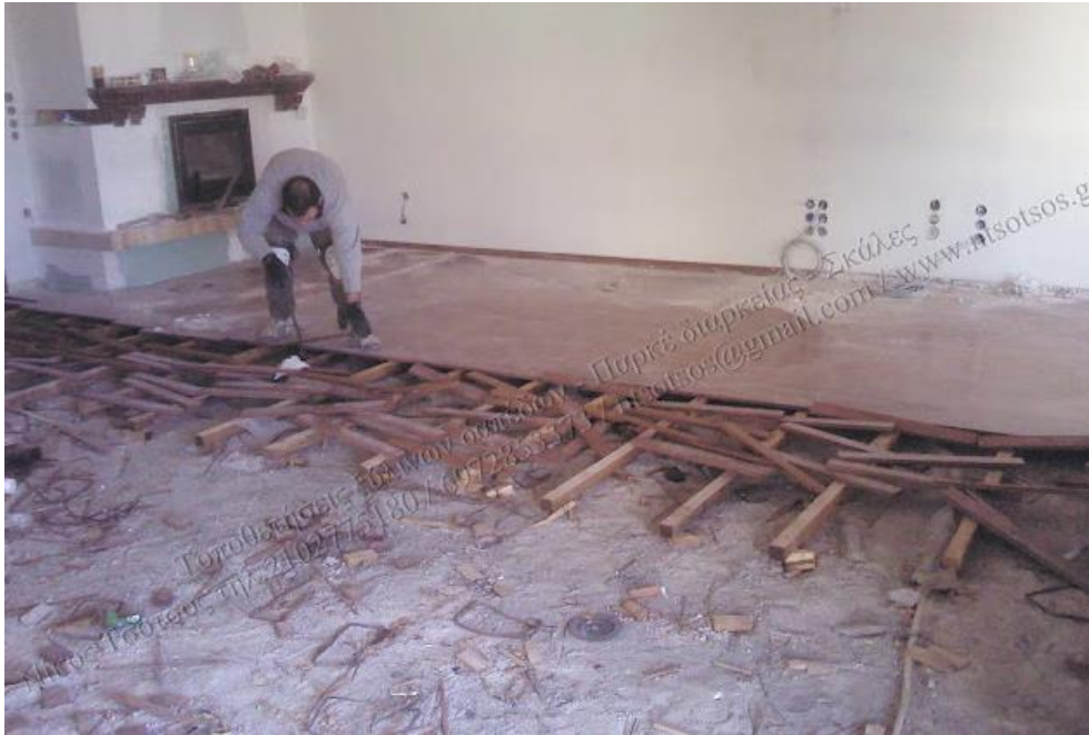
Εικόνα 1.5: Αποξήλωση ξύλινου δαπέδου. ( MG_20120121_092156.jpg )
