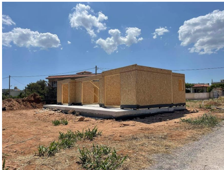
Εικόνα 92: Ολοκλήρωση σταδίου τοποθέτησης τοιχοποιίας
