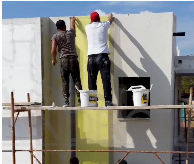
Εικόνα 113: 2 η Στρώση Θερμοσοβά
