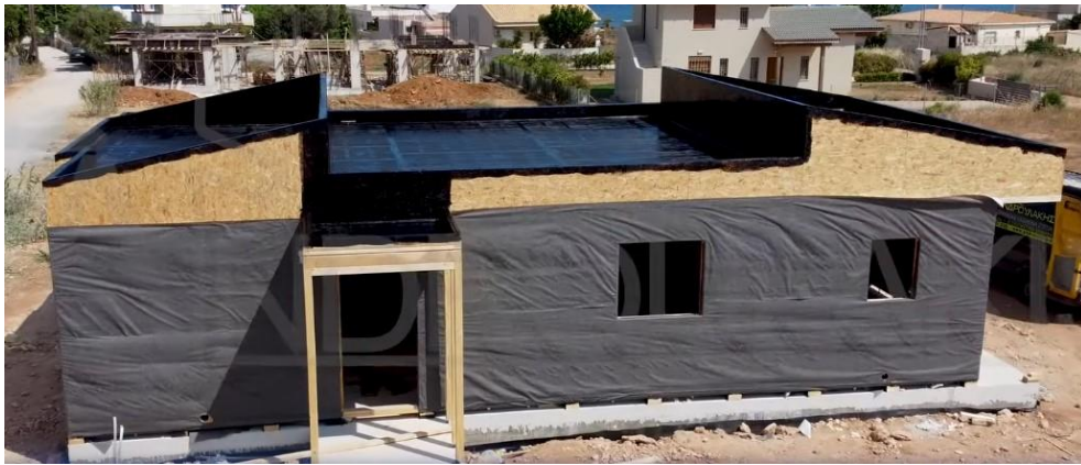
Εικόνα 111: Τοποθετημένη Στεγανωτική Μεμβράνη
