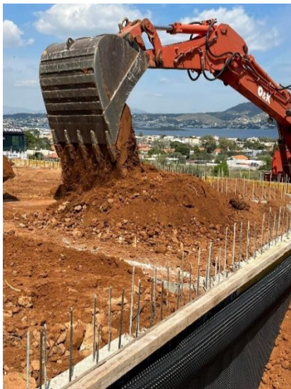
Εικόνα 75: Επιχωμάτωση
