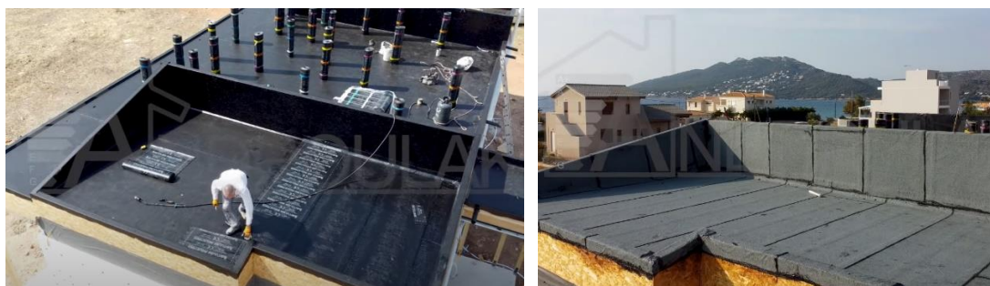
Εικόνα 97,98: 1 η & 2 η Στρώση Ασφαλτικών Μεμβρανών
