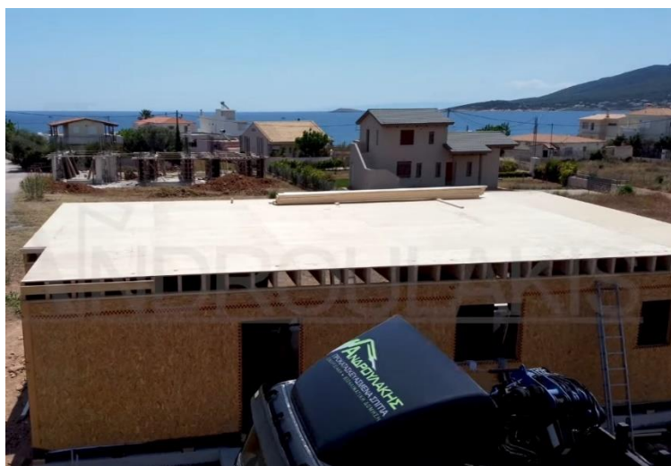
Εικόνα 95: Ολοκλήρωση Συναρμολόγησης Δώματος
