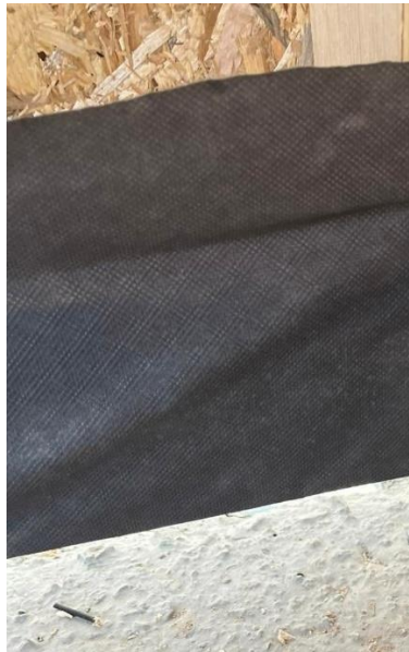
Εικόνα 26: Υδατοαποθητική Μembrάνη Τοποθετημένη Σε Τοιχοποιία
