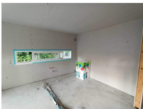
Εικόνα 109: Τοποθέτηση Γυψοσανίδων
