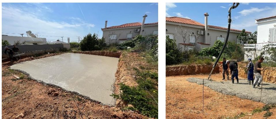
Εικόνα 66,67: Χύτευση Σκυροδέματος Εξυγίανσης
