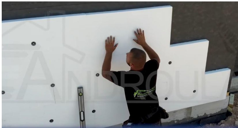
Εικόνα 112: Τοποθέτηση Εξωτερικής Θερμοπρόσοψης
