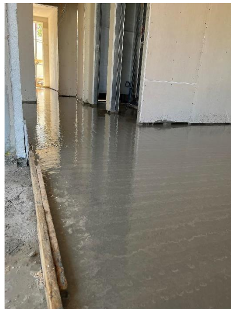
Εικόνα 105,106: Χύτευση Τσιμεντοκονίας
