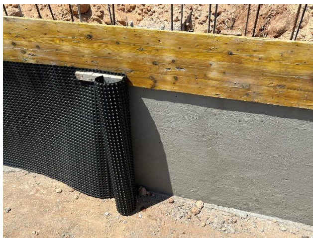
Εικόνα 77: Τοποθέτηση αποστραγγιστικής Μεμβράνης και επάλειψη τσιμεντοειδούς
