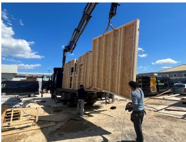
Εικόνα 80: Τοποθέτηση της τοιχοποιίας στο γερανοφόρο όχημα
