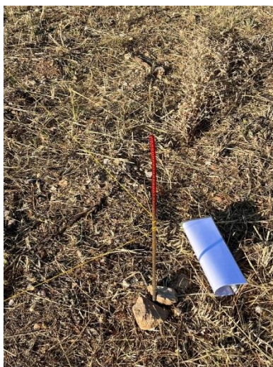
Εικόνα 61: Διαδικασία Χάραξης Εκσκαφής
