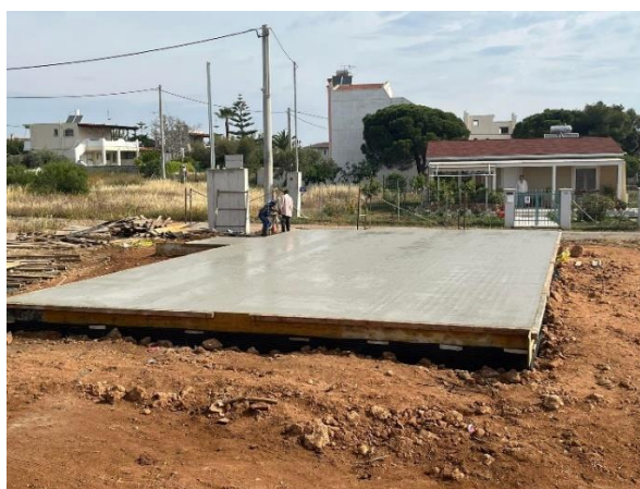
Εικόνα 57: Ολοκλήρωση Θεμελίωσης Ραντιέ
