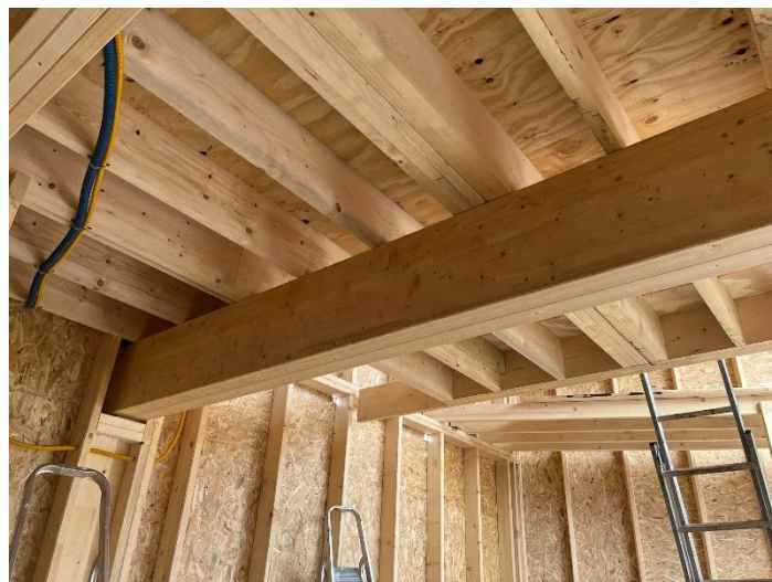
Εικόνα 47: Μεσοπάτωμα κατά την διάρκεια κατασκευής
