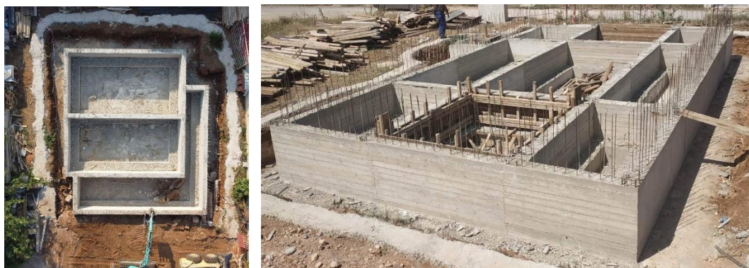
Εικόνα 58,59: Διαδικασία Θεμελίωσης Με Πεδιλοδοκάρια
