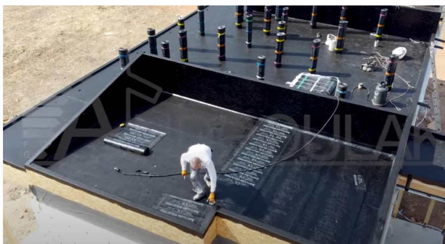
Εικόνα 43: Τοποθέτηση Ασφαλτόπανου
