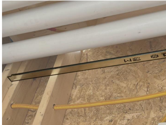
Εικόνα 49: Τοποθετημένος Γαλβανιζέ Μεταλλότυπος
