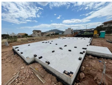
Εικόνα 82,83: Διαδικασία Επάλειψης με Πίσσα
