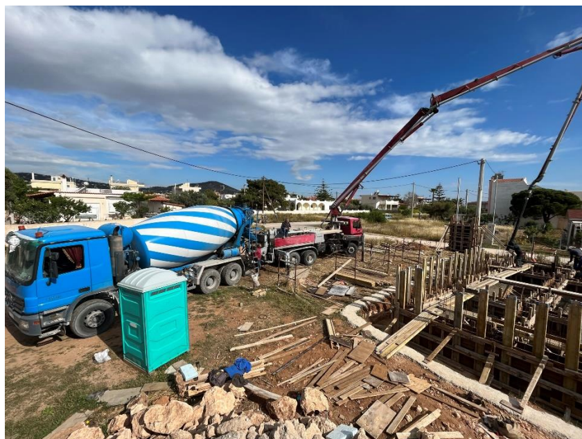
Εικόνα 73: Χύτευση Σκυροδέματος στην Θεμελίωση
