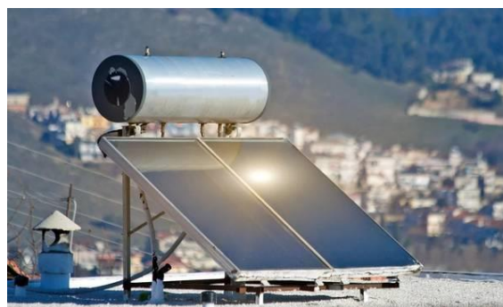
Εικόνα 8: Ηλιακός Θερμοσίφωνας
