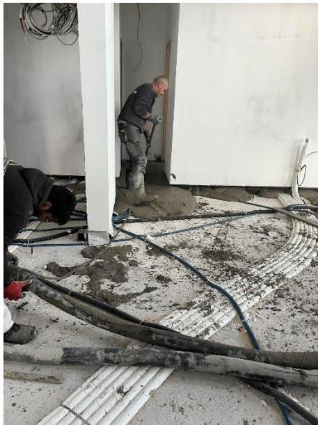
Εικόνα 105,106: Χύτευση Τσιμεντοκονίας
