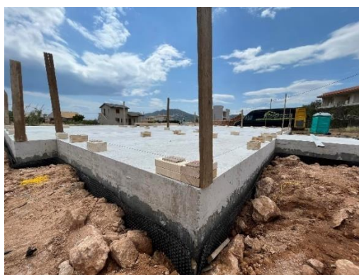
Εικόνα 81: Τοποθέτηση τακιδίων ευθυγράμμισης
