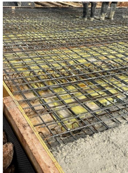
Εικόνα 76: Χύτευση Σκυροδέματος
