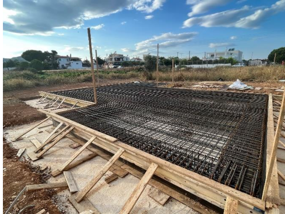
Εικόνα 69: Τοποθέτηση Οπλισμού σε Θεμελίωση - Ραντιέ
