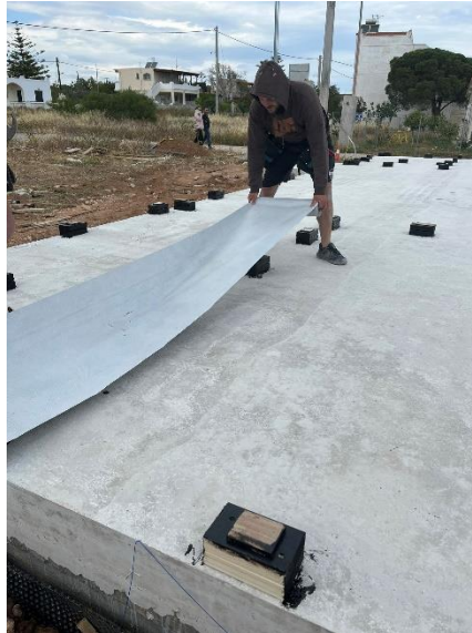
Εικόνα 84: Τοποθέτηση Στεγανωτικής Μεμβράνης
