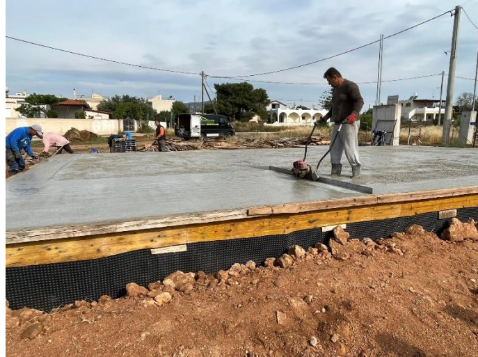
Εικόνα 74: Λείανση Σκυροδέματος
