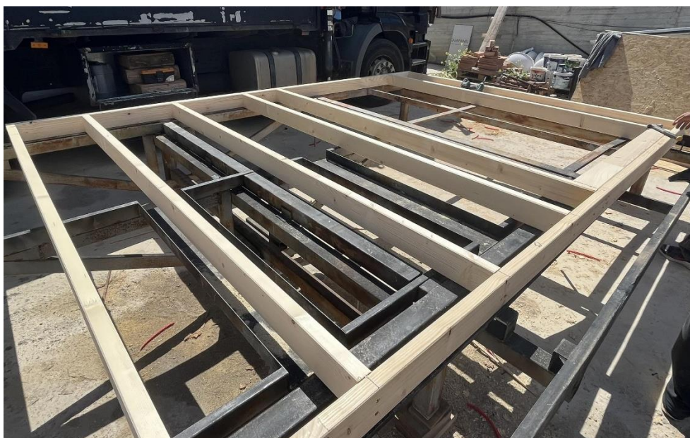
Εικόνα 20: Ξύλινος Σκελετός Κατά Τη Συναρμολόγηση
