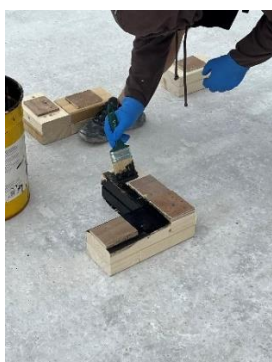
Εικόνα 82,83: Διαδικασία Επάλειψης με Πίσσα
