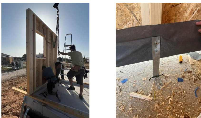
Εικόνα 88,89: Πάκτωση πλαισίων
