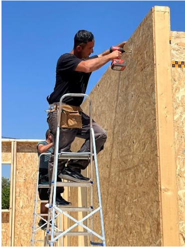
Εικόνα 90: Συναρμολόγηση πλαισίου
