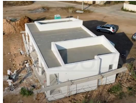
Εικόνα 100: Επενδεδυμένο Δώμα με Τσιμεντοκονία
