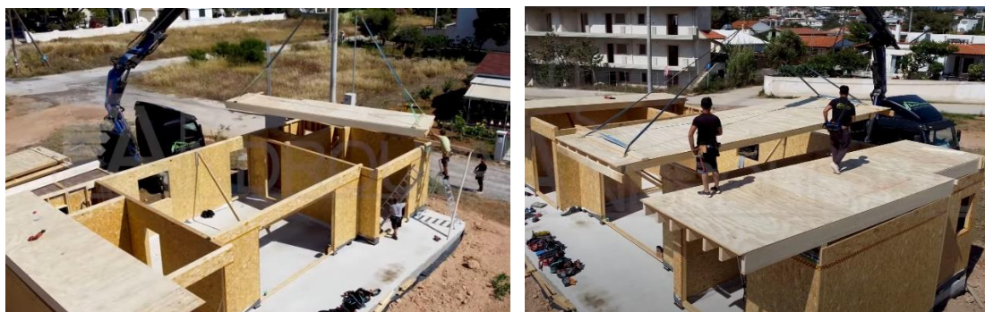
Εικόνα 93,94: Τοποθέτηση Δώματος
