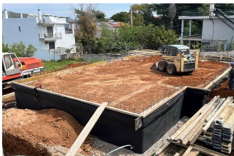
Εικόνα 60: Διαδικασία Επιχωμάτωσης
