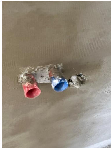
Εικόνα 104: Εσωτερική Αποπεράτωση Υδρ. Εγκαταστάσεων
