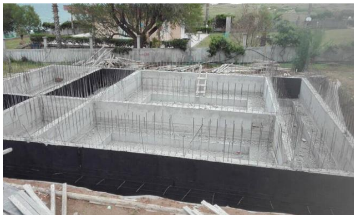
Εικόνα 55: Παράδειγμα Θεμελίωσης με Πεδιλοδοκάρια
