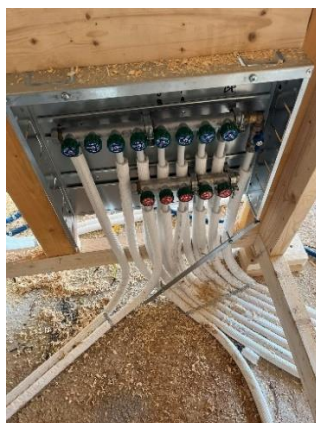
Εικόνα 103: Collector Νερού
