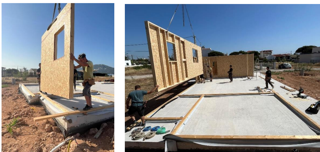
Εικόνα 86,87: Τοποθέτηση Πλαισίου στους Οδηγούς
