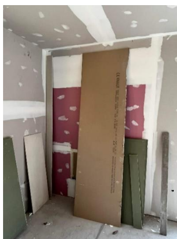
Εικόνα 110: Στοκάρισμα Γυψοσανίδων
