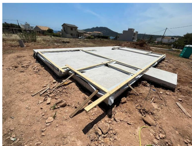
Εικόνα 85: Ολοκλήρωση Βασικού Σταδίου Προετοιμασίας
