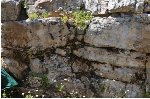
Εικ. 2.9: Σύγκριση της όψης ενός θερμικά διαβρωμένου λίθου (αριστερά) με ένα υγιή που φέρει μόνο την τυπική πατίνα του χώρου (δεξιά), Φωτογραφία: Θ. Κατρακάζης
