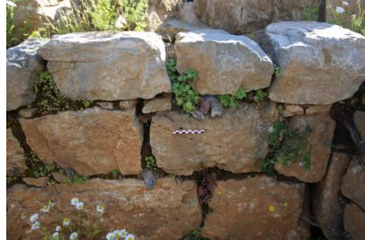
Εικ. 2.9: Σύγκριση της όψης ενός θερμικά διαβρωμένου λίθου (αριστερά) με ένα υγιή που φέρει μόνο την τυπική πατίνα του χώρου (δεξιά), Φωτογραφία: Θ. Κατρακάζης
