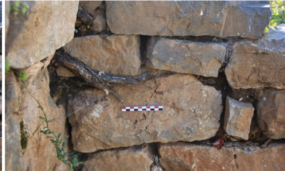
Εικ. 2.14: Ανάπτυξη ριζικού συστήματος δέντρου στα κενά των αρμών, Φωτογραφία: Θ. Κατρακάζης.
