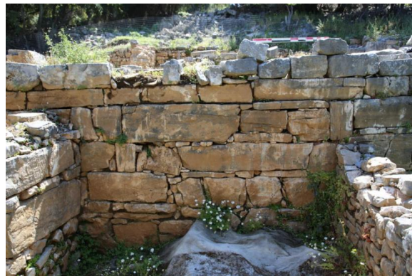
Εικ. 1.11: Λιθοδομή με ημιλαξευτούς λίθους, Φωτογραφία: Θ. Κατρακάζης
