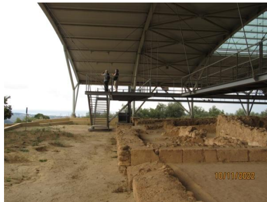
Εικ.16 Πλάγια όψη του κλιμακοστασίου που οδηγεί στον αιωρούμενο διάδρομο. Στο βάθος διακρίνεται ο ανελκυστήρας για τα άτομα με ειδικές κινητικές ανάγκες.
