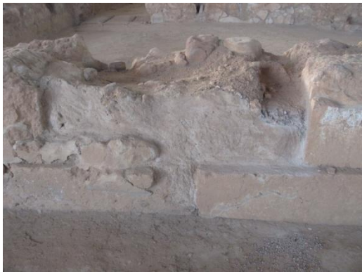
Εικ.48 Περιοχή της νότιας λιθοδομής του Χώρου 26 μετά τις προβληματικές επεμβάσεις.
