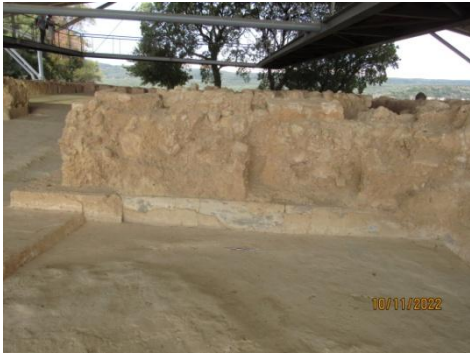
Εικ.96 Η τεχνολογία κατασκευής του επιχρίσματος στη Βορειοανατολική λιθοδομή του Χώρου 4 πάνω στο λίθο.
