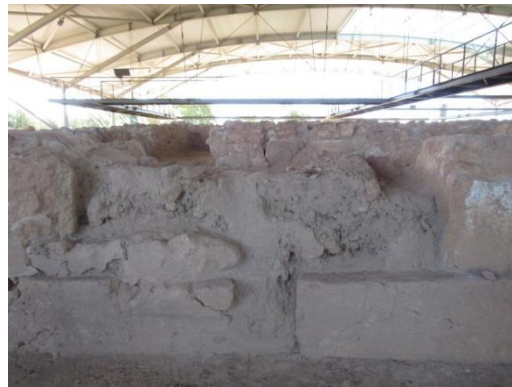
Εικ.49 Η περιοχή της εικόνας 48 μετά την αφαίρεση των προβληματικών επεμβάσεων.
