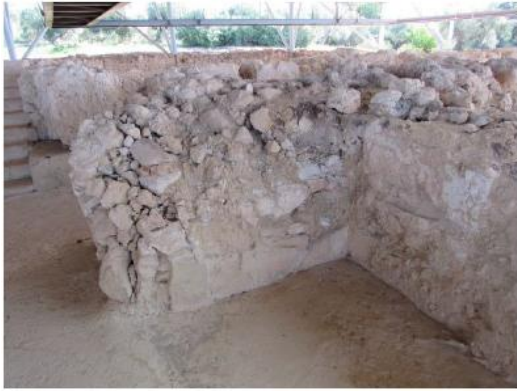
Εικ.42 Η νοτιοανατολική λιθοδομή του Χώρου 5 πριν τις στερεώσεις.
