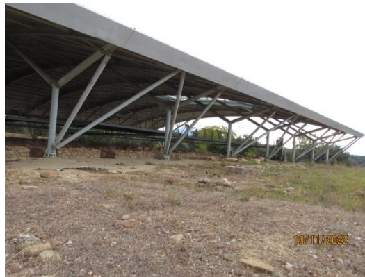
Εικ.20 Άποψη των υποστηλωμάτων της δυτικής πλευράς του στεγάστρου.
