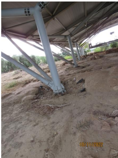
Εικ.19 Άποψη των υποστηλωμάτων της ανατολικής πλευράς του στεγάστρου.
