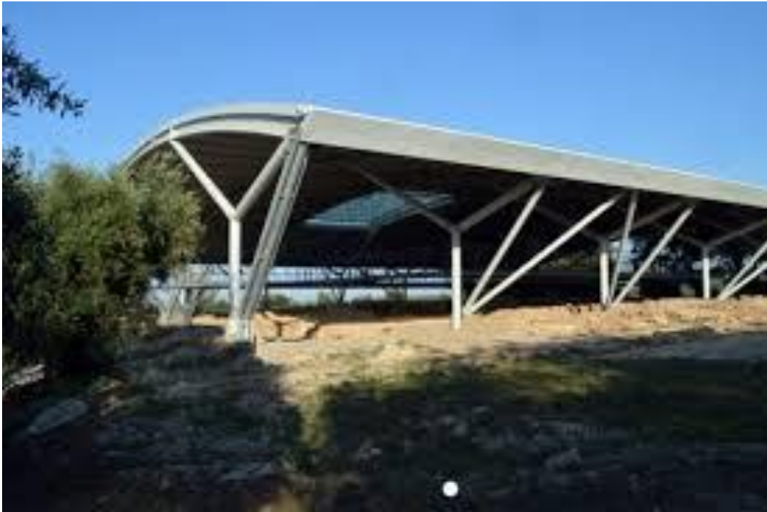
Εικ.14 Άποψη του σύγχρονου στεγάστρου από την νοτιοανατολική πλευρά.
