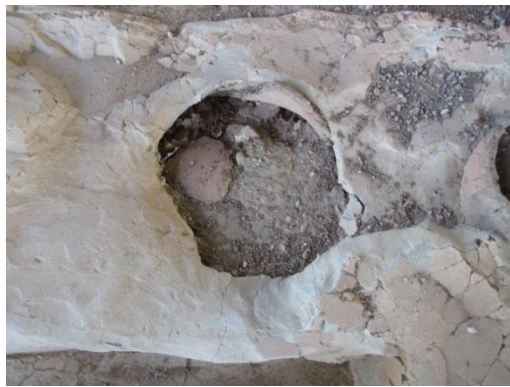
Εικ.50 Ενδεικτικά η αρχική κατάσταση του πύθου 8 στο Χώρο 23. Είναι φανερή η διατάραξη όπως και η εφαρμογή των τσιμεντοκονιάματων από παλιότερες επεμβάσεις.
