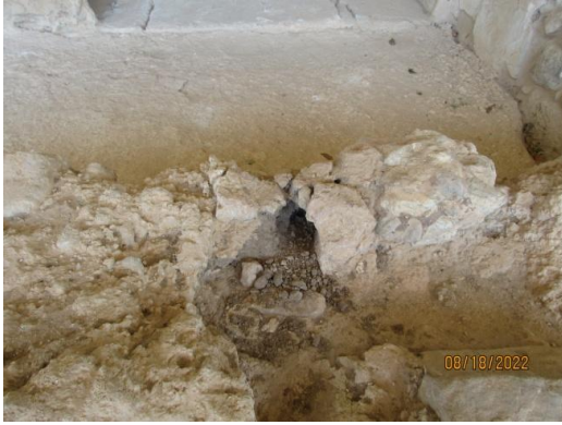
Εικ.35 Φθορά από ζώο στη βόρεια λιθοδομή του Χώρου 50 για δεύτερη φορά.
