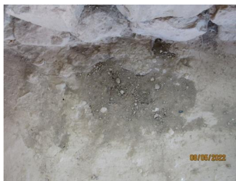
Εικ.22 Τα υποστυλώματα του πρώτου στεγάστρου που κόπηκαν έτσι ώστε τα θεμέλια τους να βρίσκονται στα δάπεδα του Κεντρικού Κτηρίου. Στην εικόνα το κομμένο υποστύλωμα στο Χώρο 8.
