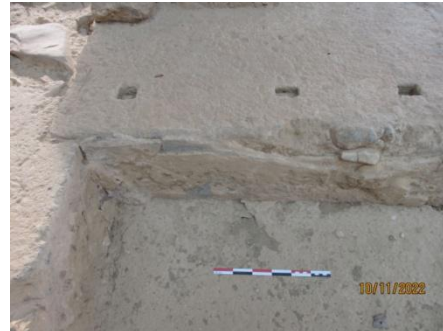
Εικ.101 Η τεχνολογία κατασκευής του επιχρίσματος στη Νοτιοανατολική λιθοδομή του Χώρου 3 πάνω στο λίθο. Λήψη από πιο κοντά.
