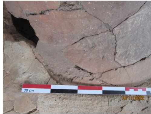
Εικ.57 Συμπλήρωση με πηλοκονίαμα στον πίθο 7 του Χώρου 24 για στατικούς λόγους.
