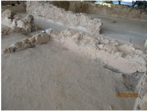
Εικ.46 Άποψη του Χώρου 50 κατά την έναρξη αφαίρεσης των προβληματικών επεμβάσεων. Στο δάπεδο είναι χαρακτηριστικές οι φθορές από τη δράση της πανίδας.
