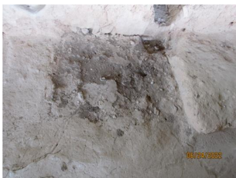
Εικ.21 Τα υποστυλώματα του πρώτου στεγάστρου που κόπηκαν έτσι ώστε τα θεμέλια τους να βρίσκονται στα δάπεδα του Κεντρικού Κτηρίου. Στην εικόνα το κομμένο υποστύλωμα στο Χώρο 18.
