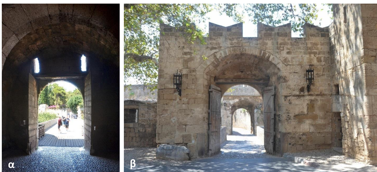
Εικόνα 1.4 Ξύλινες πόρτες με τα υπέρθυρα δοκάρια τους από την πύλη Ντ' Αμπουάζ: α) με μεταλλική επένδυση από την εξωτερική πύλη, β) από την εσωτερική πύλη (ζωγράφος).
