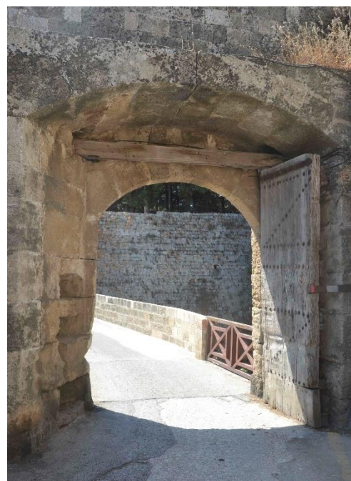
Εικόνα 2.1 Ξύλινη πόρτα εξωτερικής πύλης Αγίου Αθανασίου, γενική άποψη, διατηρείται το ένα φύλλο και η ξύλινη υπέρθυρη δοκός.
