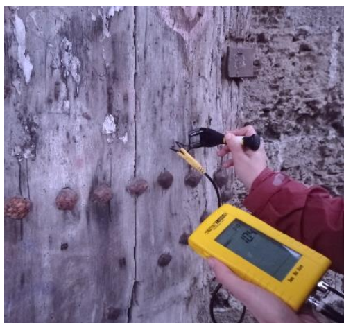
Εικόνα 2.22 Υγρομέτρηση σημείων στην πόρτα Αγ. Αθανασίου με υγρόμετρο T2000, με αισθητήρα ηλεκτρικής αντίστασης TS 50.
