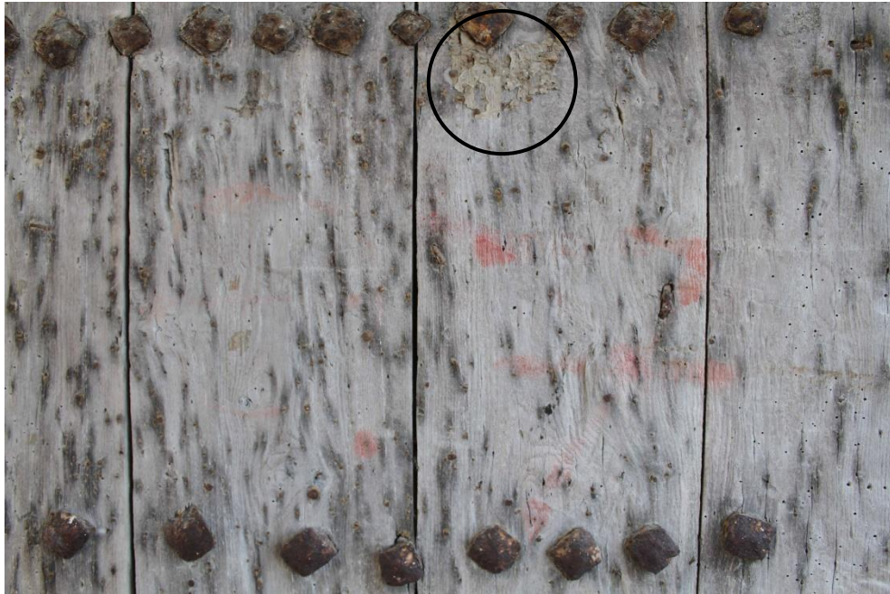
Εικόνα 2.12 Προϊόντα οξείδωσης από νεότερα μεταλλικά καρφάλια κ.ά., διακρίνονται υπολείμματα κόκκινου σπρέι και στρώμα που παραπέμπει σε πλαστικό (έλλειψη).
