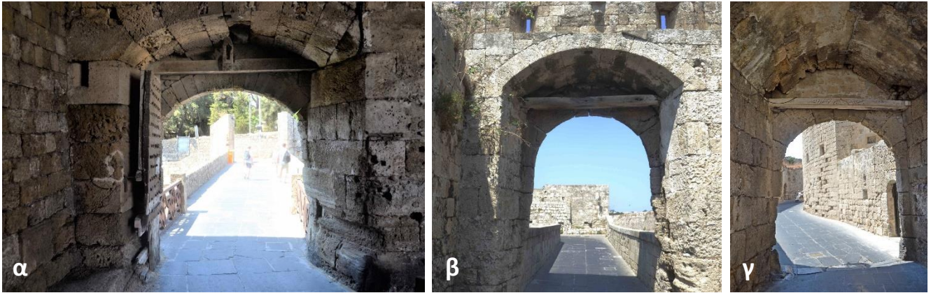
Εικόνα 1.10 Οι τρεις επιμέρους πύλες του Αγίου Ιωάννη όπως διατηρούνται σήμερα: α) εξωτερική πύλη ( Κόκκινη Πόρτα ) διατηρείται το ένα φύλλο της ξύλινης πόρτας με μεταλλική επένδυση και υπέρθυρη δοκό, μόνο η ξύλινη υπέρθυρη δοκός διατηρείται στην β) ενδιάμεση και γ) εσωτερική πύλη.
