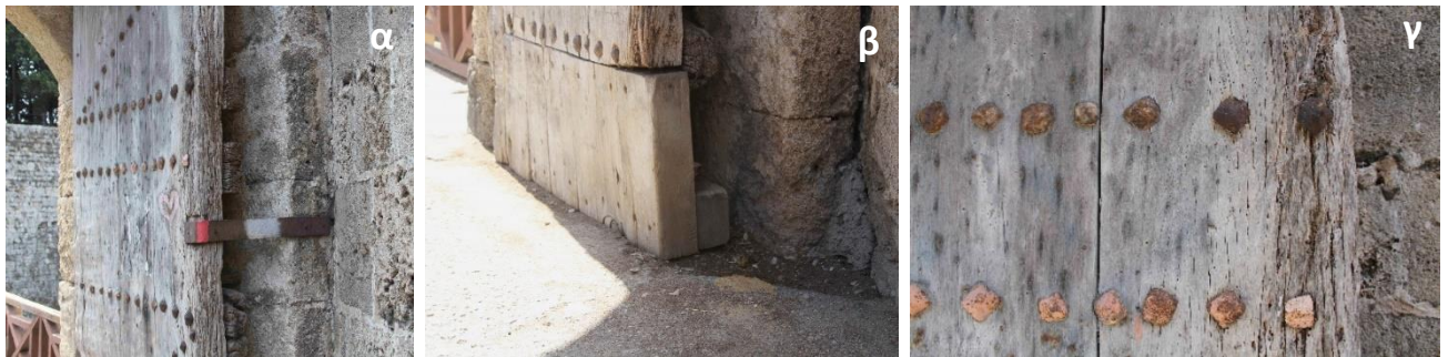
Εικόνα 2.4 Λεπτομέρειες από την πόρτα Αγ. Αθανασίου: α) το μεταλλικό έλασμα που συγκρατεί το φύλλο ανοιχτό, β) κάτω τμήμα της πόρτας με συμπλήρωση νεότερων τμημάτων και τραβέρσας, και το ανασηκωμένο επίπεδο του δαπέδου που εγκιβωτίζει την πόρτα, γ) κεφαλές από μεταλλικά γυφτόκαρφα, στην κάτω σειρά διακρίνονται υπολείμματα επιχρίσματος.
