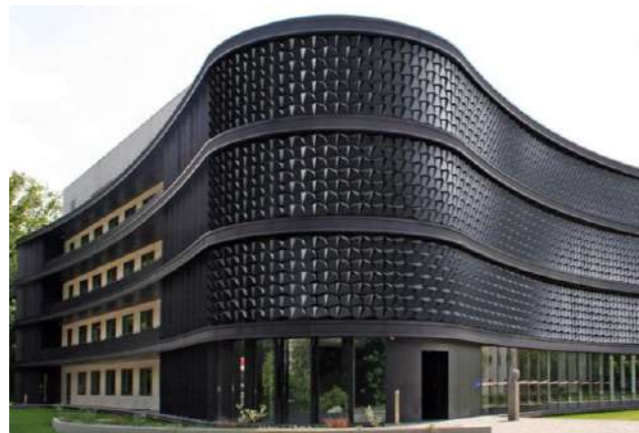
Εικόνα 9. Εξωτερική όψη κτιρίου.
