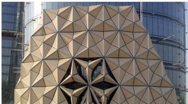
Εικόνα 11. Al Bahar Towers
