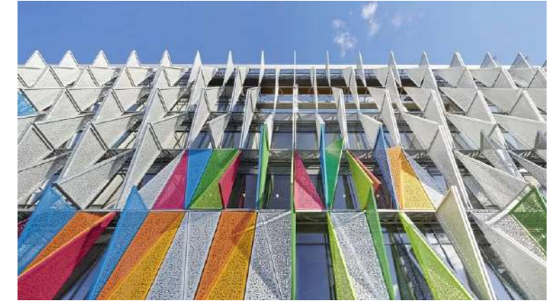
Εικόνα 33. Έγχρωμα στοιχεία του κινητικού συστήματος που αποδίδουν την ώρα της ημέρας
