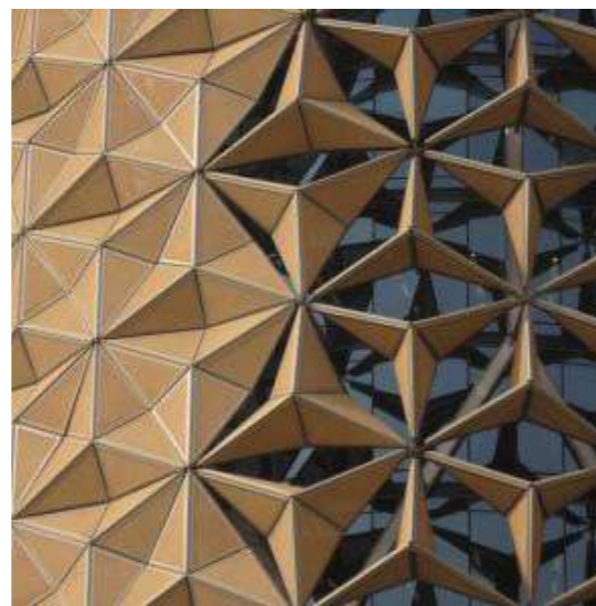
Εικόνα 1. Τμήμα των Πύργων Al Bahar
