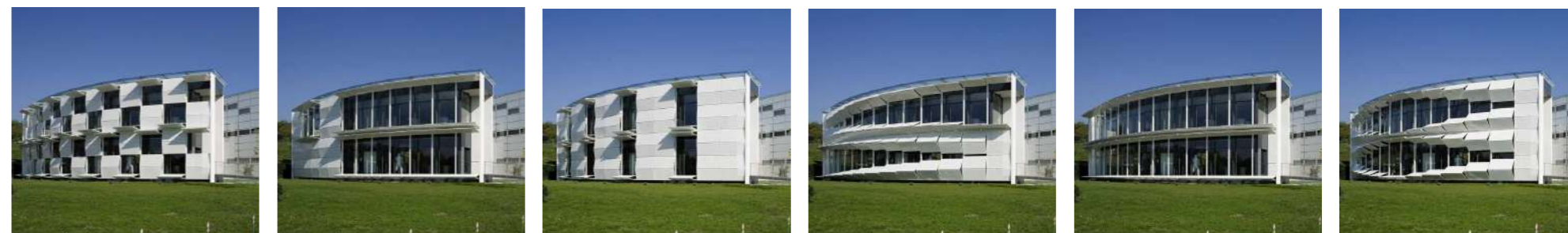
Εικόνα 24,25,26,27,28,29. Διαφορετικές φάσεις της κινητικής πρόσοψης κατά τη διάρκεια της ημέρας ελέγχου
