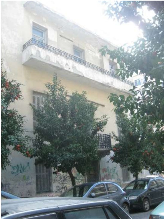
Η όψη της οδού Σαλαμινομάχων
