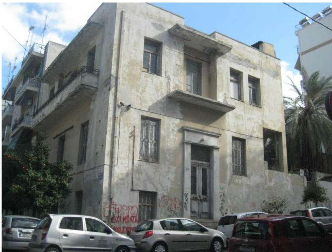
Γωνία Σαλαμινομάχων και Ευπλοίας, η σημερινή όψη του κτιρίου
