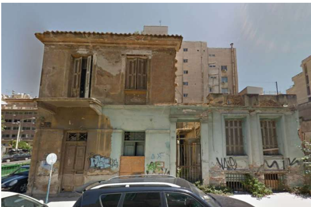
Η όψη επί της οδού Μπότσαρη (πηγή: google street view-2009)
