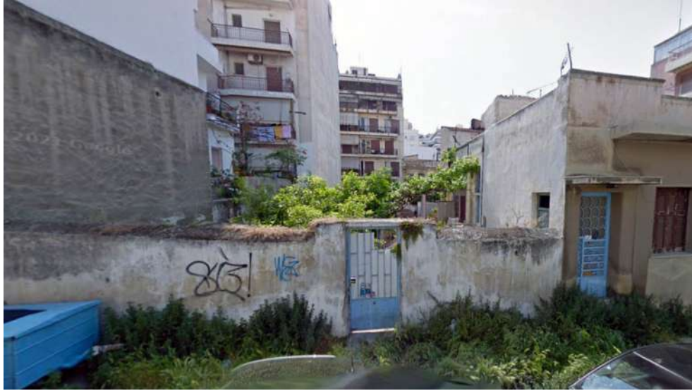
Οδός Φλέσσα, άποψη πριν την αποκατάσταση (πηγή: google street view-2009)
