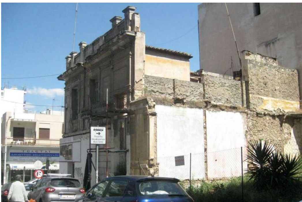
Άποψη από το πλάι. Πάνω από την αυλόπορτα ο τοίχος δεν αντιστοιχεί σε εσωτερικό χώρο.
