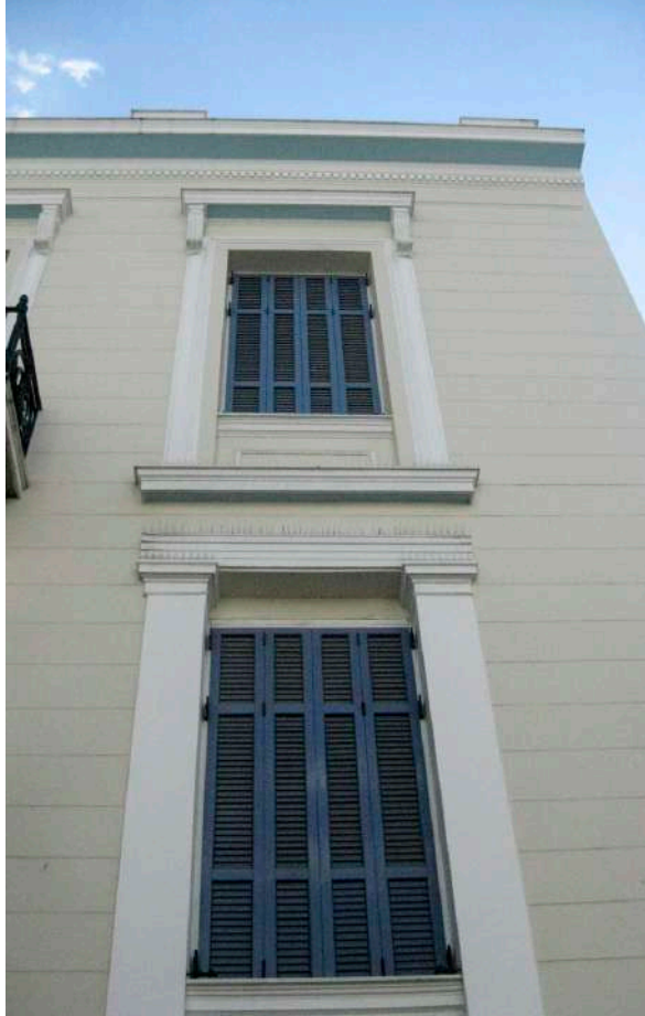
Πλαισίωση ανοιγμάτων 1ου και 2ου ορόφου
