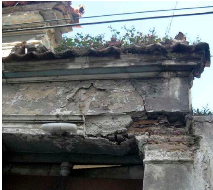
Λεπτομέρεια των κατασκευαστικών στοιχείων του θριγκού της αυλόπορτας.
