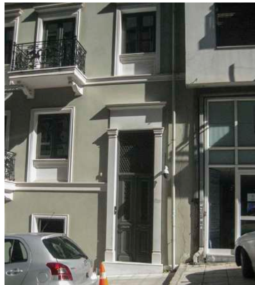
Η θύρα εισόδου μετά την αποκατάσταση
