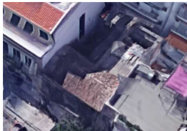
Στέγαση (πηγή: google earth-2014)
