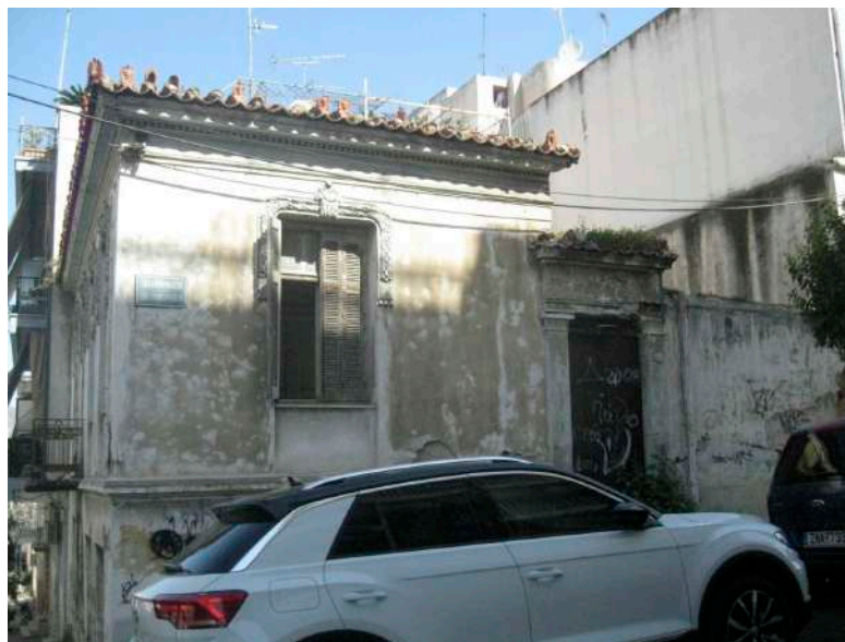
Η όψη στην οδό Σαλαμινομάχων
