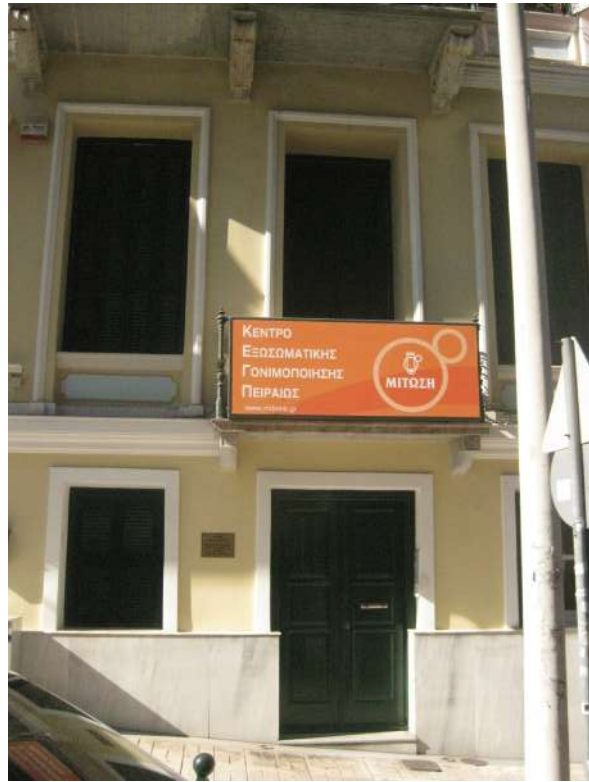
Πλαισίωση ανοιγμάτων, θύρα ημυπογείου
