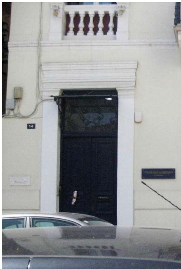
Η θύρα εισόδου με αλλαγές στο θριγκό μετά την αποκατάσταση
