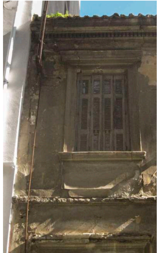
Λεπτομέρεια της στέψης και της πλαισίωσης του ανοίγματος του ορόφου.
