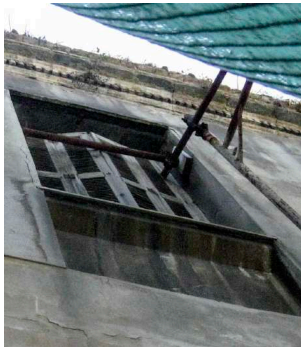
Το άνοιγμα του παραθύρου του ορόφου. Διακρίνεται το μεταλλικό πρέκι και η «ξυρισμένη» πλαισίωσή του.
