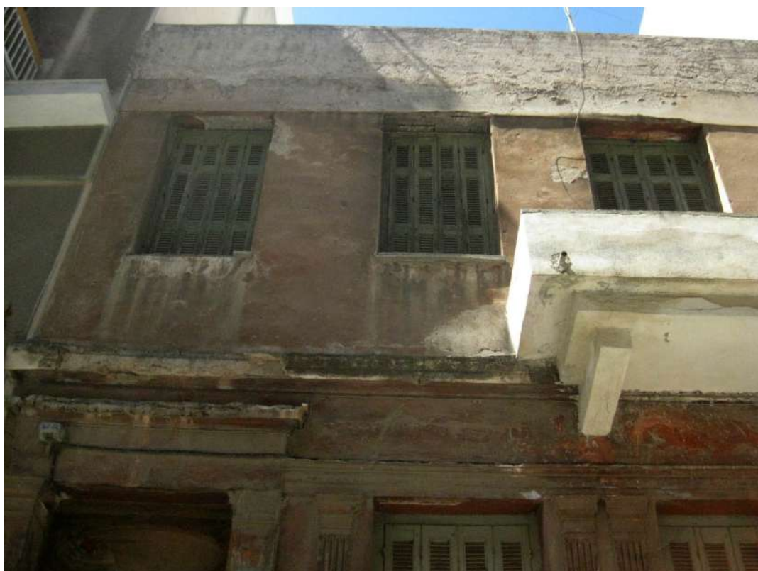
Λεπτομέρεια από το νεότερο εξώστη, τα ανοίγματα του ορόφου και την αλλοίωση με το μπετόν στη στέψη.
