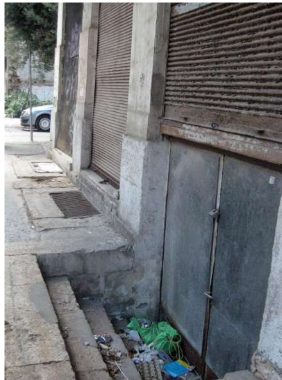
Κάτω από το άνοιγμα του καταστήματος καλυμμένη με λαμαρίνα η είσοδος για το υπόγειο.
