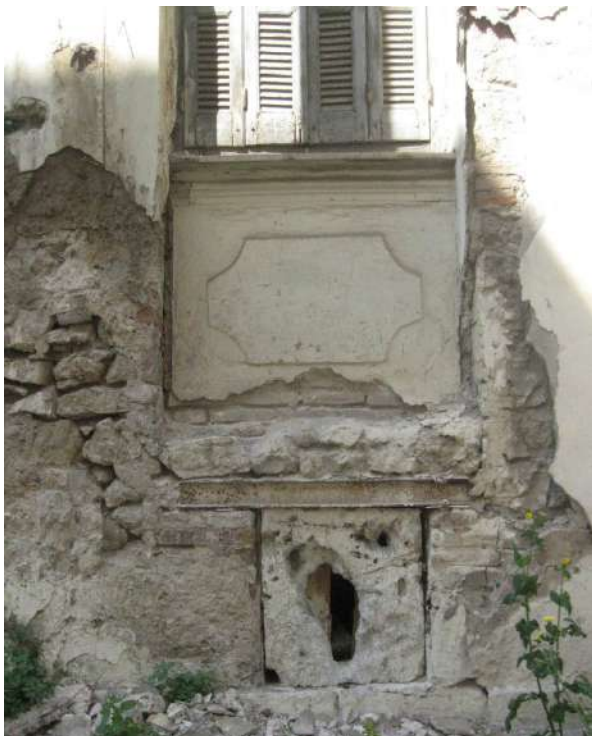
Το θωράκιο του παραπάνω ανοίγματος και υπόγειο άνοιγμα που έχει κλειστεί με λίθο.
