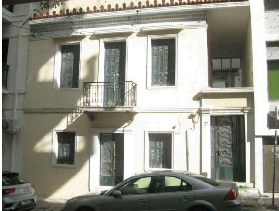
Το νεότερο δώμα από μπετόν έχει επεκταθεί ώστε να σκεπάσει και την πλαϊνή θύρα εισόδου.
