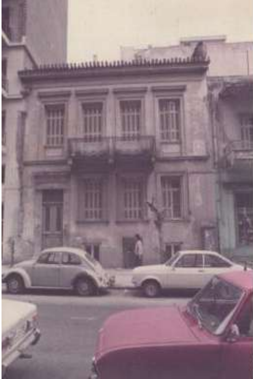
Σαχτούρη 30, η όψη του κτιρίου πριν την αποκατάσταση (πηγή: αρχείο διατηρητέων ΥΠΕΧΩΔΕ -1987)
