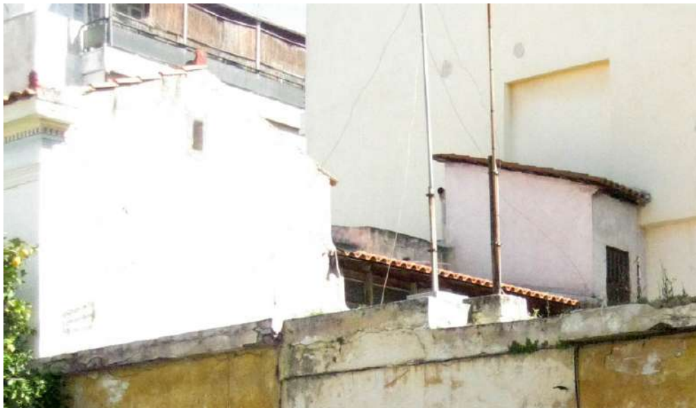
Από το διπλανό κτίριο διακρίνεται η νεότερη κάλυψη με στέγη της αυλής ή του ημιυπαίθριου χώρου
