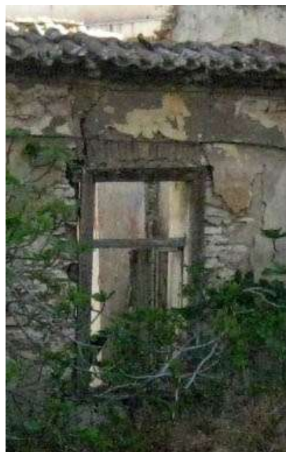
Άνοιγμα παραθύρου προς την αυλή. Διακρίνεται το πρέκι-γαμηλωμένο τόξο από οπτόπλινθους.
