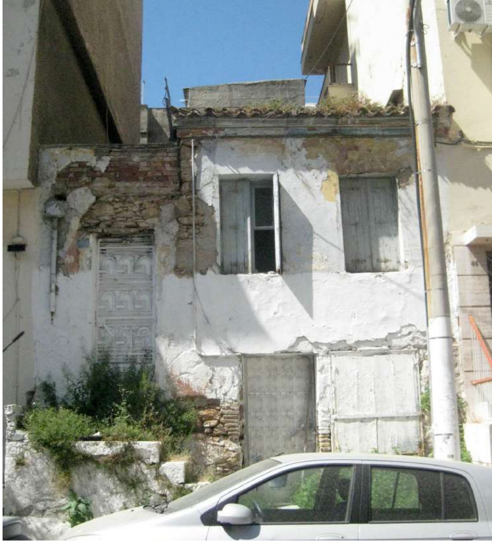
Ηροδότου 48, η σημερινή όψη του κτιρίου
