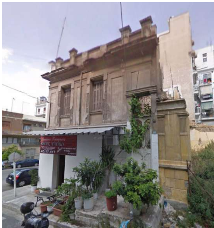
Η όψη στην οδό Θουκυδίδου. Στο πλάι της θύρας φαίνεται κομμάτι του διπλανού κτιρίου που έχει κατεδαφιστεί. (πηγή: google street view-2009)
