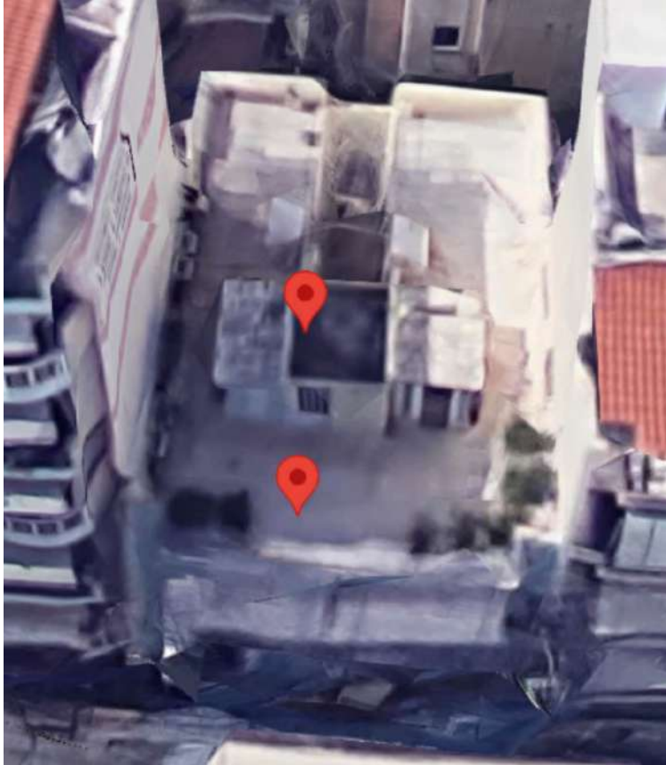
Στέγαση (πηγή: google earth-2014)
