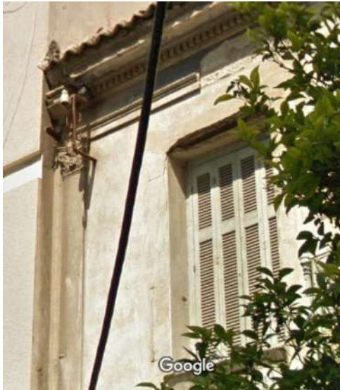
Πριν και μετά την αποκατάσταση, παραστάδα με κιονόκρανο, γείσο, πλαισίωση ανοίγματος
