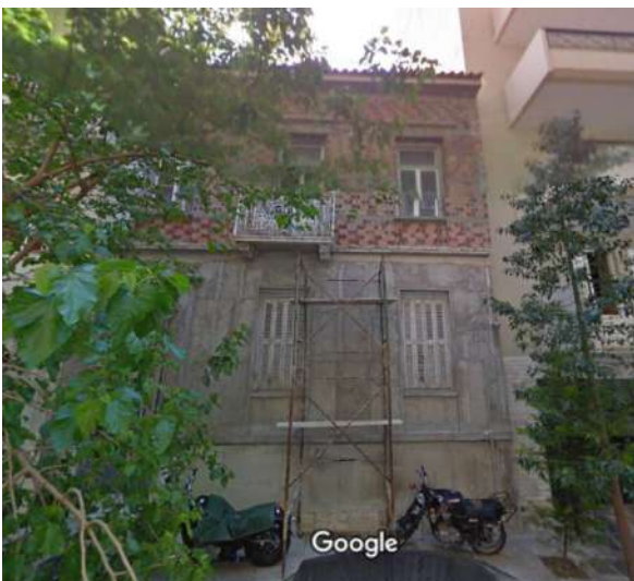
Κατά την αποκατάσταση της όψης. Ο όροφος μοιάζει με νεότερος ή πλήρως ανακατασκευασμένος, αφού φαίνεται νέα σειρά διάτρητων τούβλων σε όλη την όψη. (πηγή: google street view 2009)
