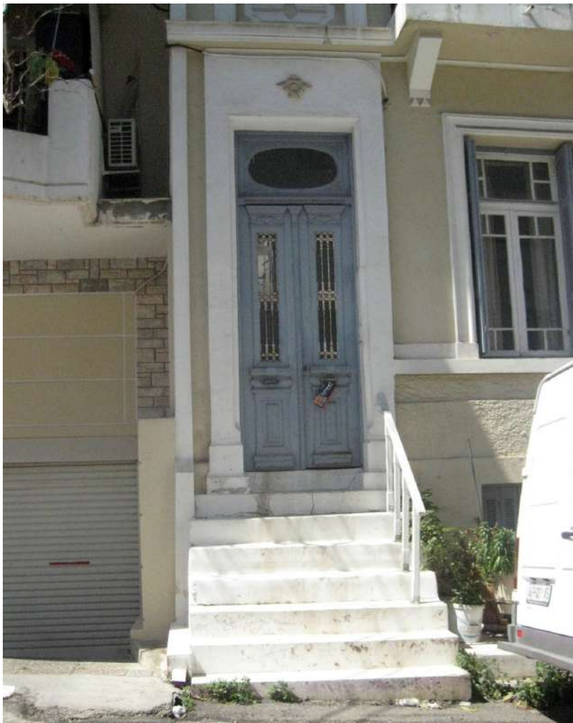
Η κοινή θύρα εισόδου για το ισόγειο και τον όροφο.
