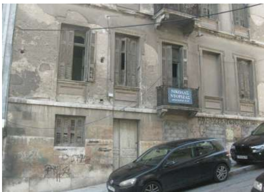
Η θύρα του υπογείου, οδός Κανθάρου.
