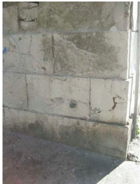
Η βάση του κτιρίου με τους ορθογωνισμένους λίθους
