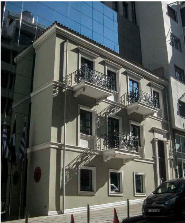
Μετά την αποκατάσταση Δεν υπάρχει πλέον είσοδος για το ημιυπόγειο
