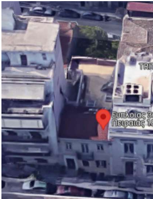
Στέγαση (πηγή: google earth-2014)
