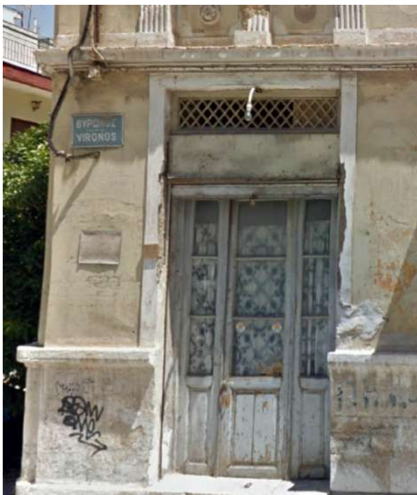
Το άνοιγμα του ισόγειου καταστήματος, οδός Βύρωνος (πηγή: google street view-2009)
