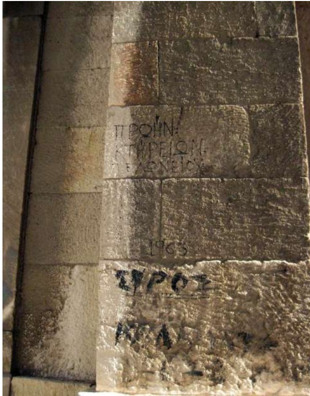
Λεπτομέρεια της κατασκευής των παραστάδων από ορθογωνισμένους λίθους
