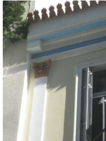
Πριν και μετά την αποκατάσταση, παραστάδα με κιονόκρανο, γείσο, πλαισίωση ανοίγματος
