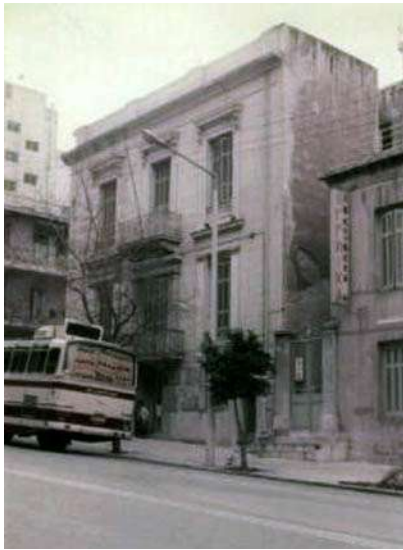
Όψη επί της Χατζηκυριάκου πριν την αποκατάσταση (πηγή: αρχείο διατηρητέων του ΥΠΕΧΩΔΕ-1987)
