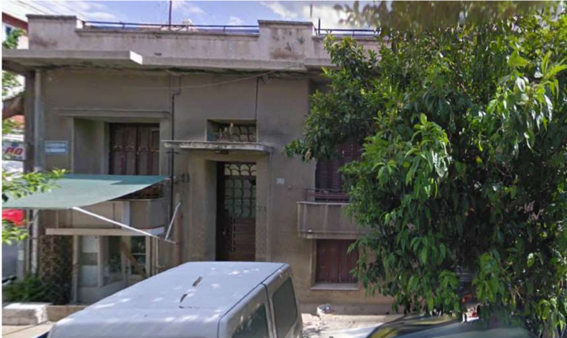
Οδός Σαλαμινομάχων, άποψη πριν την αποκατάσταση (διακρίνεται η χρήση του αριστερού ημιπογείου ως κατάστημα) (πηγή: google street view-2009)
