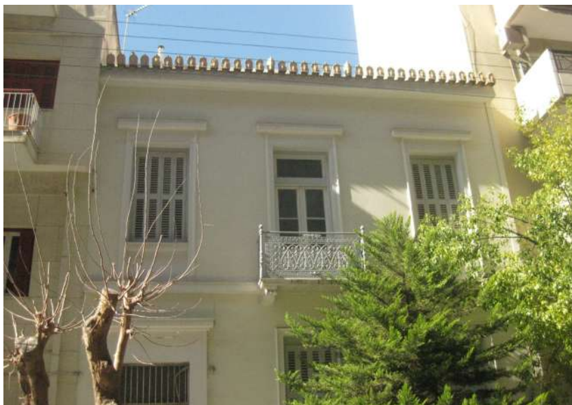
Πλαισίωση ανοιγμάτων, στέγη.
