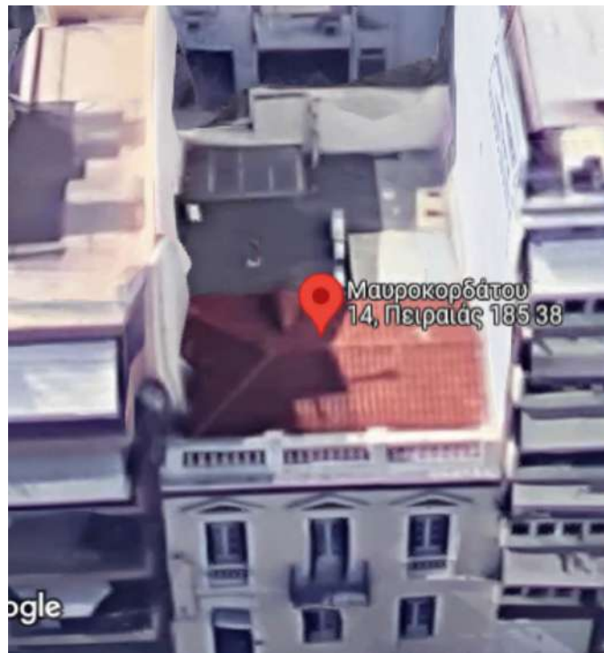
Στέγαση (πηγή: google earth-2014)
