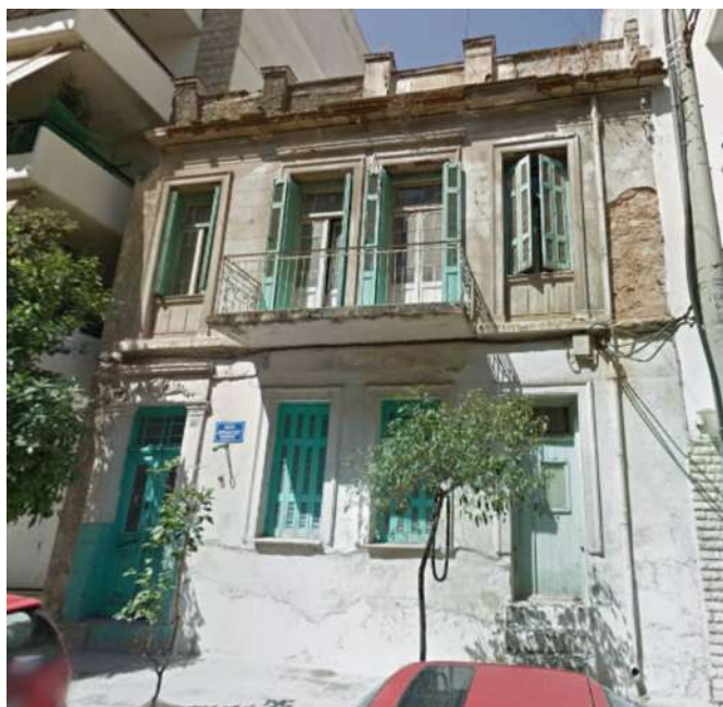
Εικ. 32-33, Ηροδότου 58, (ΔΚ45), λαϊκό νεοκλασικό με υστεροκλασικιστικά στοιχεία. Διακρίνεται το προκατασκευασμένο ανάγλυφο προσαρμοσμένο στο επίπεδο του θριγκού της θύρας. Ο όροφος πιθανά λίγο μεταγενέστερος.
