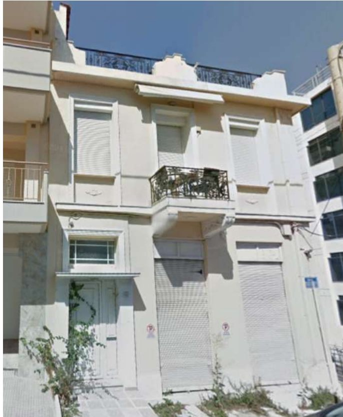
Η όψη της οδού Θουκυδίδου (πηγή: google street view-2014)
