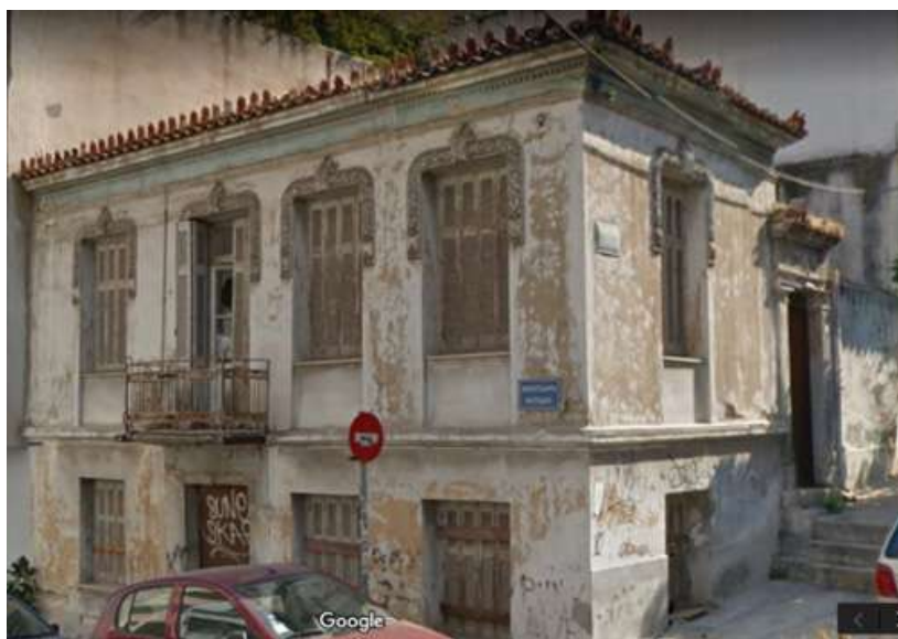
Εικ. 29, Σαλαμινομάχων 24 και Μπότσαρη 25, (ΔΚ26), λαϊκό με υστεροκλασικά στοιχεία. Χαρακτηριστική η φορτωμένη γύψινη καμπύλη πλαισίωση των ανοιγμάτων των παραθύρων με φυτομορφικό ανάγλυφο σχέδιο.
