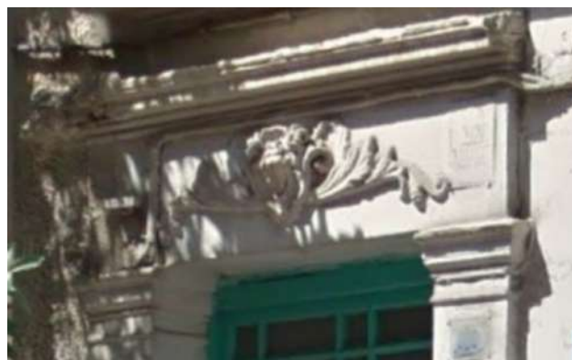
Εικ. 32-33, Ηροδότου 58, (ΔΚ45), λαϊκό νεοκλασικό με υστεροκλασικιστικά στοιχεία. Διακρίνεται το προκατασκευασμένο ανάγλυφο προσαρμοσμένο στο επίπεδο του θριγκού της θύρας. Ο όροφος πιθανά λίγο μεταγενέστερος.
