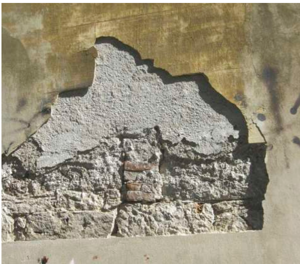
Η περιμετρική τοιχοποιία από αργολιθοδομή
