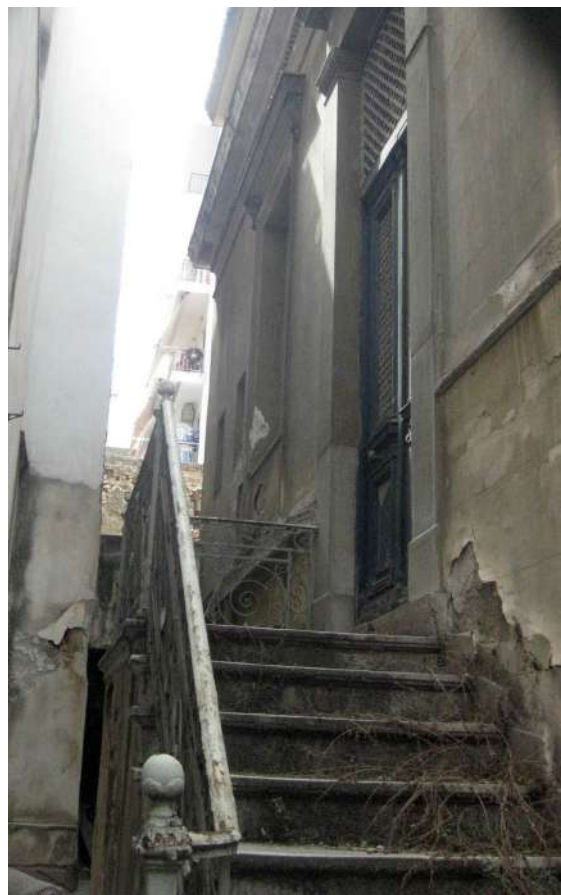
Η πλαϊνή όψη με την είσοδο για τον όροφο
