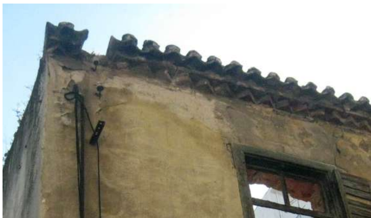
Το γείσο του κτιρίου από οπτόπλινθους
