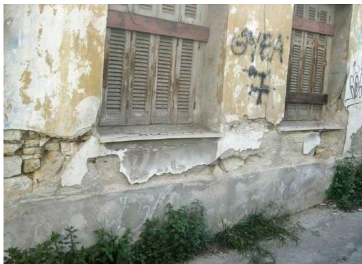
Πάνω: Η προεξέχουσα βάση του κτιρίου. Δεξιά: Η φέρουσα τοιχοποιία από αργολιθοδομή.
