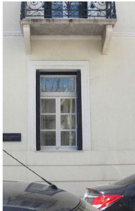
Η πλαισίωση των ανοιγμάτων στο ισόγειο και οι πιθανά νεότερη οριζόντιοι αρμοί στη βάση του κτιρίου.
