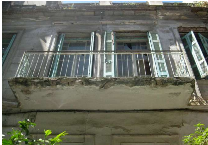
Ο εξώστης από μπετόν αρμέ και το απλό κιγκλίδωμα. Διακρίνεται η πλαισίωση των εξωστόθρων
