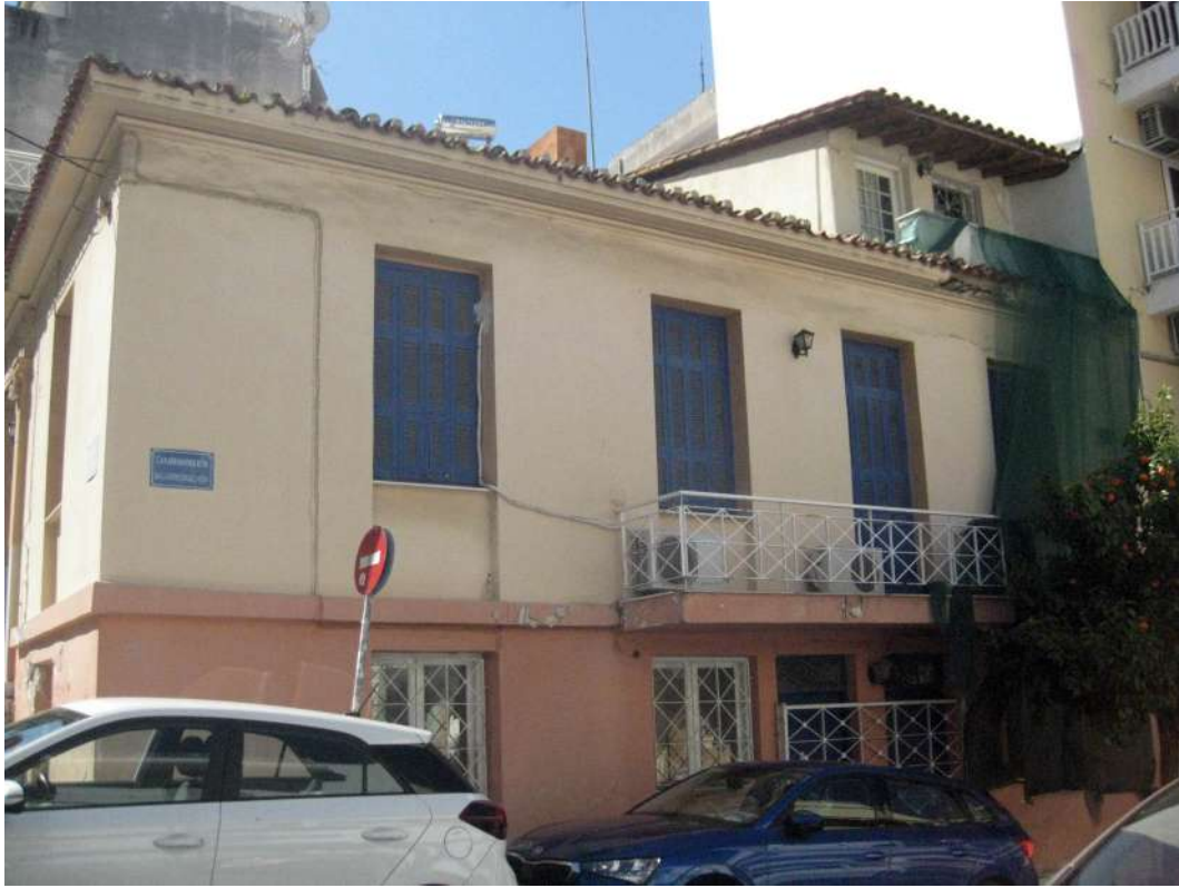
Η όψη στην οδό Σαλαμινομάχων
