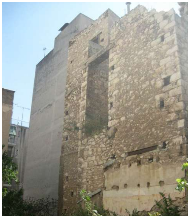
Η παλαινή όψη, διακρίνεται ο φέρον οργανισμός από αργολιθοδομή και ο φωταγωγός του κτιρίου
