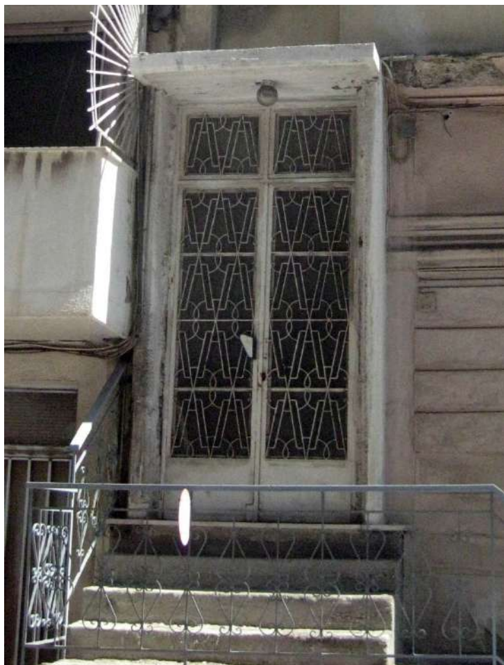
Η θύρα εισόδου για τον όροφο, νεότερη, λαμπάδες και προστέγασμα από μπετόν
