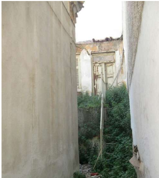
Από την αυλόπορτα ξεκινά διάδρομος προς την αυλή. Η είσοδος για τον όροφο πιθανά στο πίσω μέρος του κτιρίου. Διακρίνεται το βοηθητικό πίσω κτίσμα και η σκάλα ανόδου προς αυτό καλυμμένη με βλάστηση
