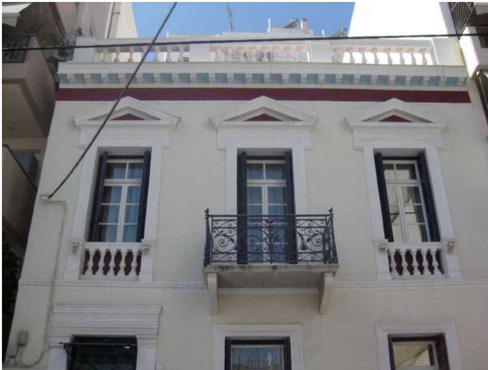
Η πλαισίωση των ανοιγμάτων του ορόφου, και η στέψη
