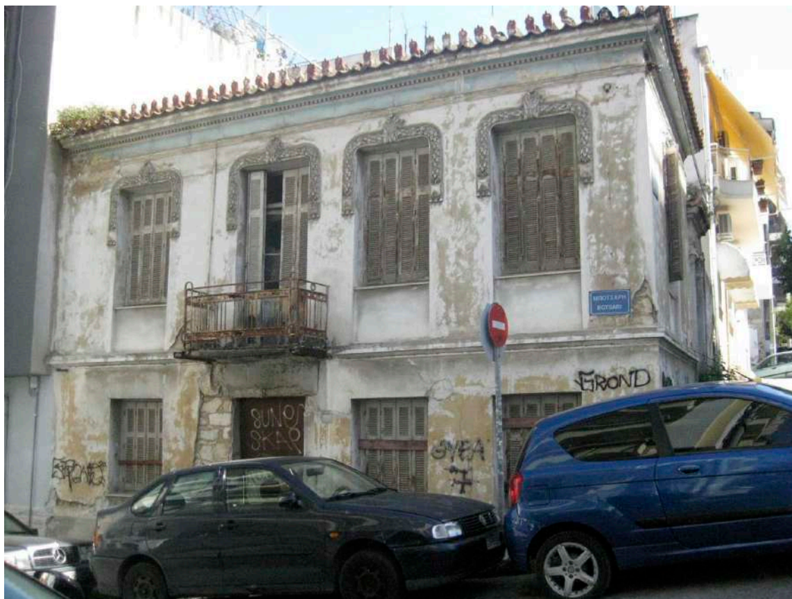
Η σημερινή όψη του κτιρίου (από την οδό Μπότσαρη)
