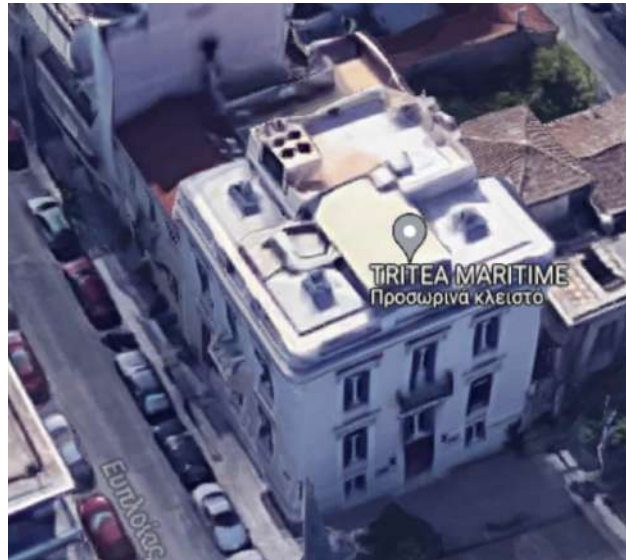
Στέγαση (πηγή: google earth-2014)
