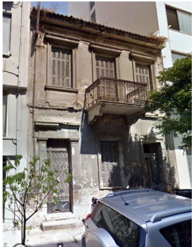
Η όψη του κτιρίου το 2014 (πηγή: google street view)
