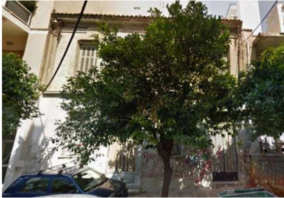
Η όψη του κτιρίου το 2014 (πηγή: google street view)
