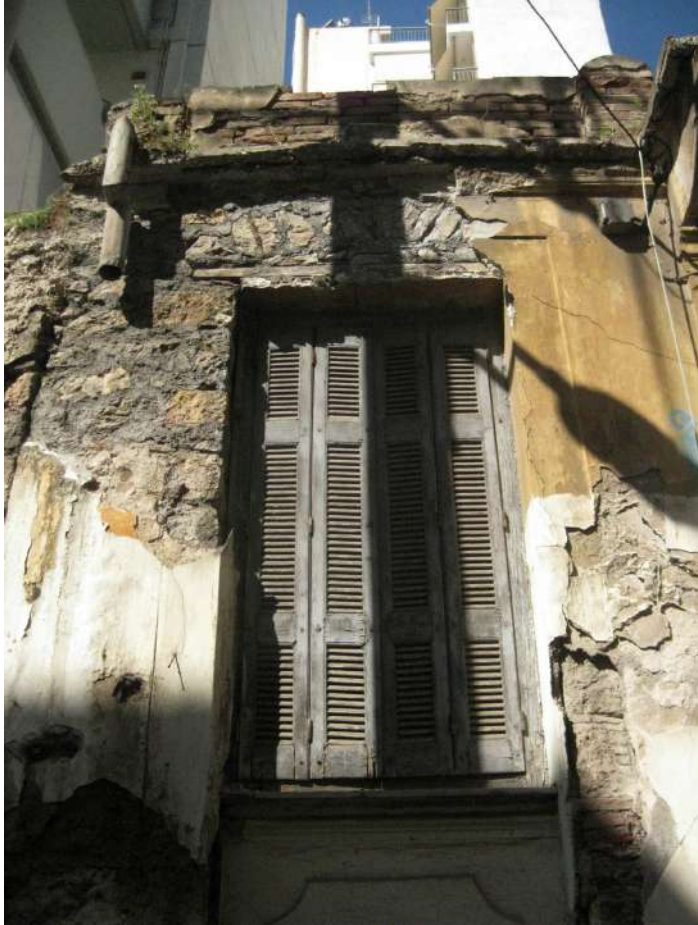
Το άνοιγμα του παραθύρου του ορόφου με το χαμηλωμένο τόξο από λίθους στο ανώφλι του. Διακρίνονται επίσης οι οπτόπλινθοι του στηθαίου του δώματος.
