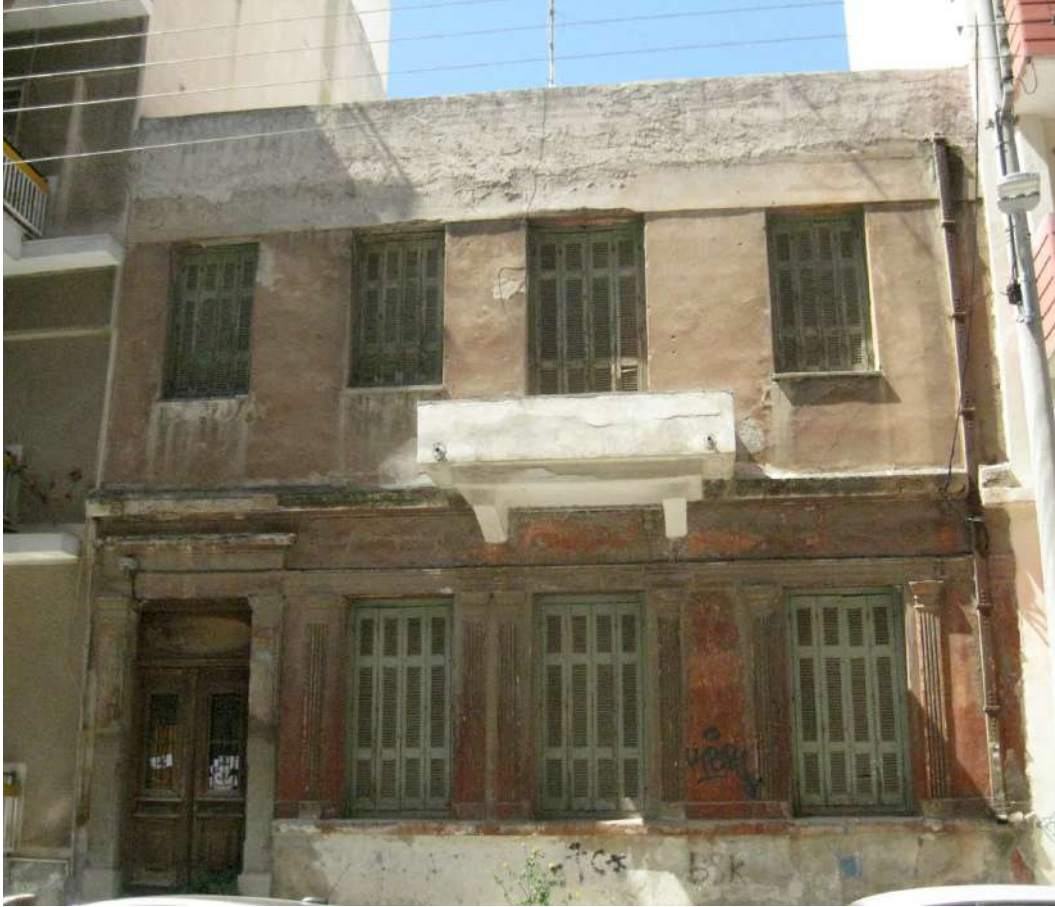
Ηροδότου 76, η σημερινή όψη του κτιρίου
