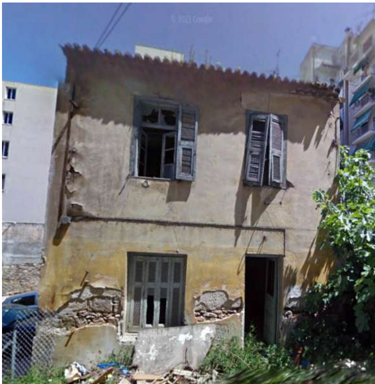
Η όψη πριν την φωτιά (πηγή: google street view-2009)
