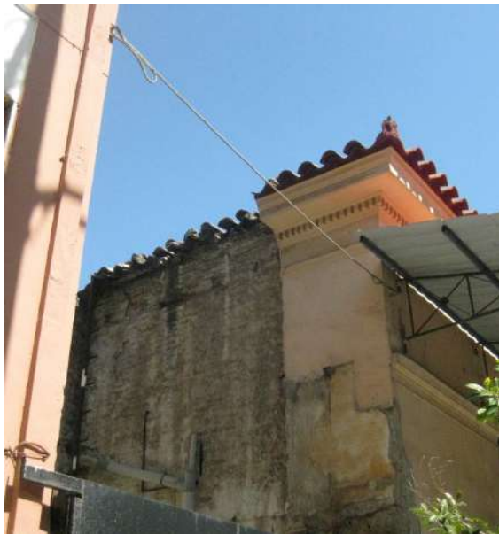
Πλαϊνή όψη, προς την αυλή. Διακρίνεται η τοιχοποι- ία στο άνω μέρος από οπτόπλινθους.
