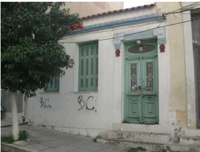
Εικ. 35, Τομπάζη 48, (ΔΚ16), λαϊκό εκλεκτιστικό με στοιχεία art deco στην άνω πλαισίωση της θύρας, οβάλ φεγγίτης, αρχές 20ου.
