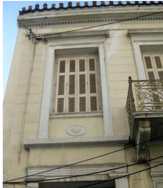
Πλαισίωση ανοιγμάτων ορόφου
