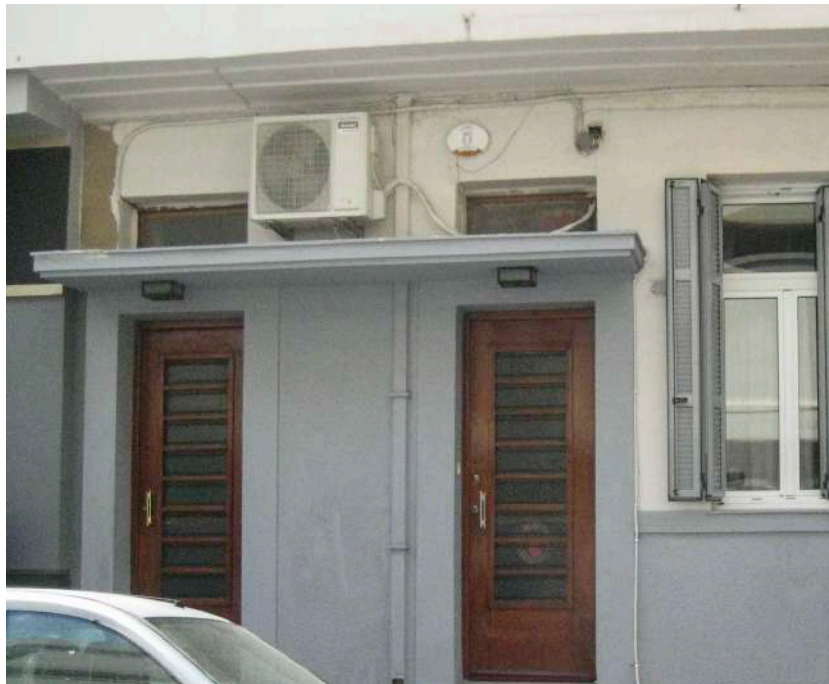
Οι ομαδοποιημένες θύρες εισόδου βρίσκονται στην οδό Τομπάζη. Διακρίνεται το κοινό στέγαστρο αλλά και το γείσο με τους τρεις αναβαθμούς.
