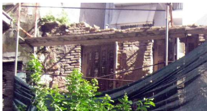
Η εξωτερική τοιχοποιία του ορόφου από οπτοπλινθοδομή
