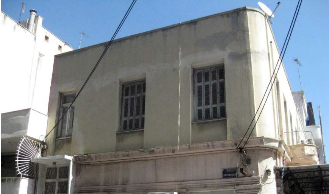
Ο μεταγενέστερος όροφος, οδός Μαυροκορδάτου
