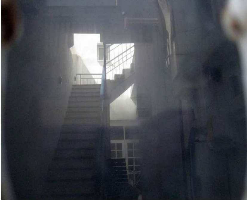
Άποψη μέσα από το τζάμι της θύρας. Διακρίνεται η σκάλα ανόδου προς τον όροφο και ο μικρός ακάλυπτος.
