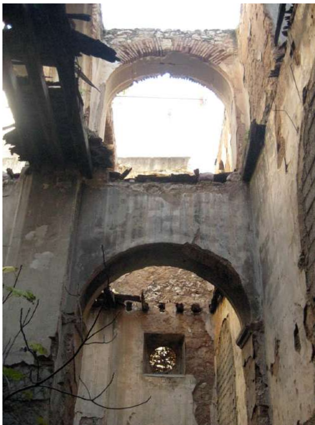
Τοξωτά ανοίγματα στο εσωτερικό του κτιρίου από οπτόπλινθους. Διακρίνονται τα δοκάρια και το σανίδωμα από το ξύλινο πάτωμα του παταριού.
