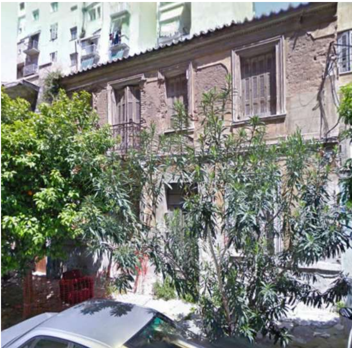
Η όψη του κτιρίου το 2009 (πηγή: google street view)
