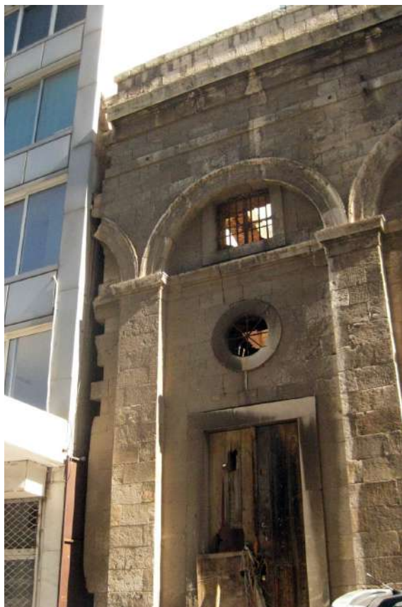
Το σημείο που γκρεμίστηκε το κτίριο προκειμένου να ανεγερθεί πολυκατοικία
