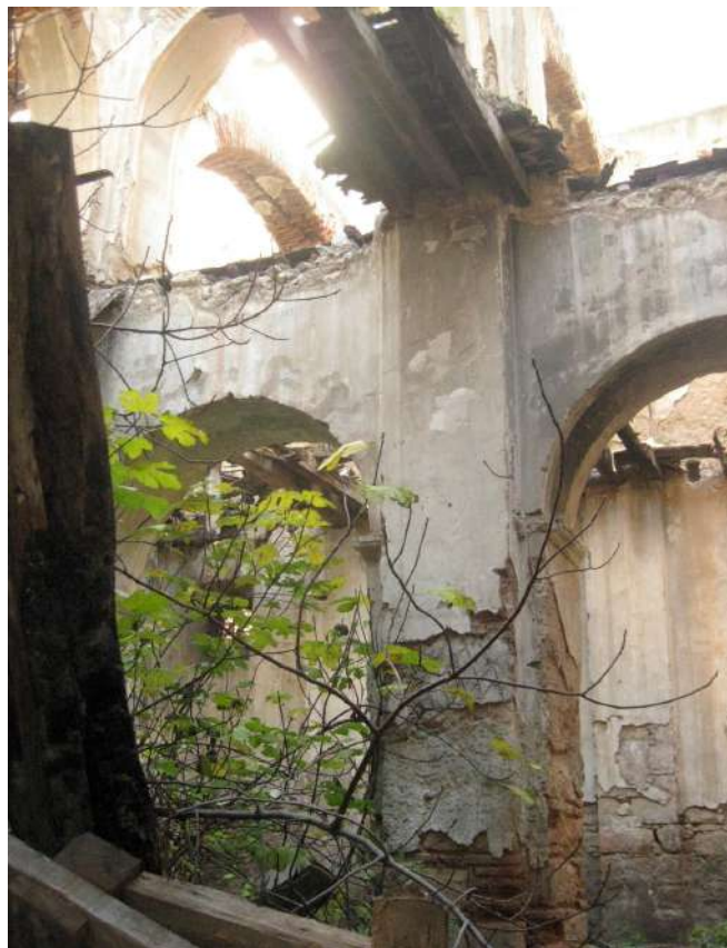
Τοξωτά ανοίγματα στο εσωτερικό του κτιρίου. Εδράζονται σε παραστάδες στο ισόγειο.
