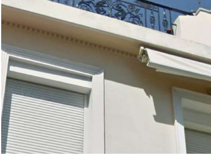
Η πλαισίωση των ανοιγμάτων του ορόφου και η ζώνη από οδόντες κάτω από το νεότερο γείσο της στέγης.
