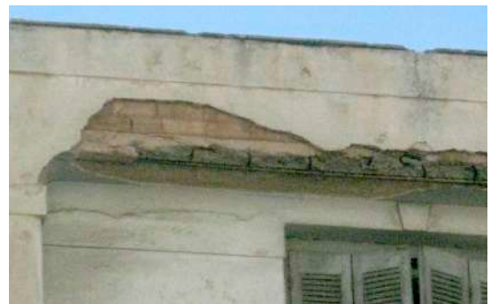
Οπλισμένο σκυρόδεμα και οπτόπλιθοι στο στηθαίο
