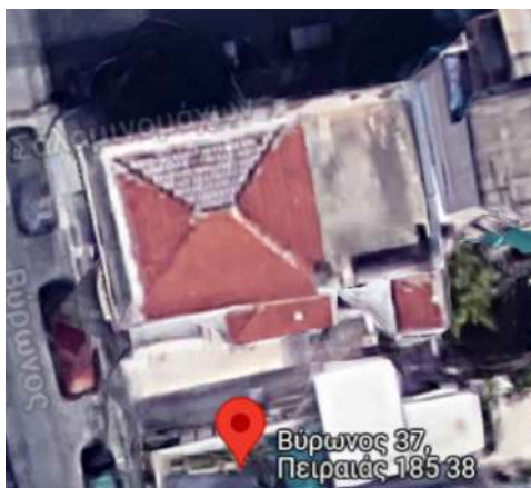
Στέγαση (πηγή: google earth-2014)
