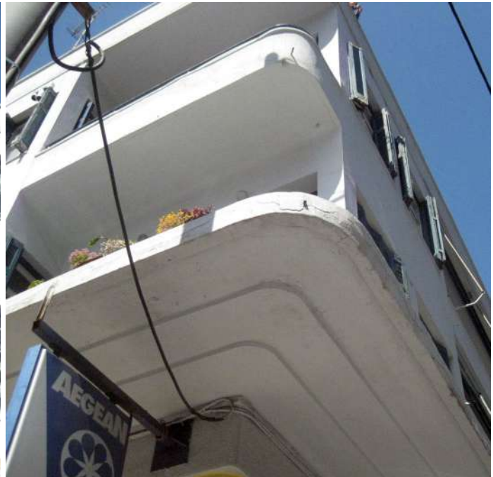
Οι τρεις αναβαθμοί στο στέγαστρο του ισόγειου-μεσοπολεμικό στοιχείο
