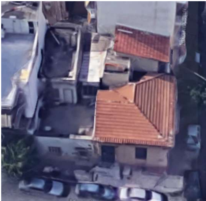
Στέγαση (πηγή: google earth-2014)
