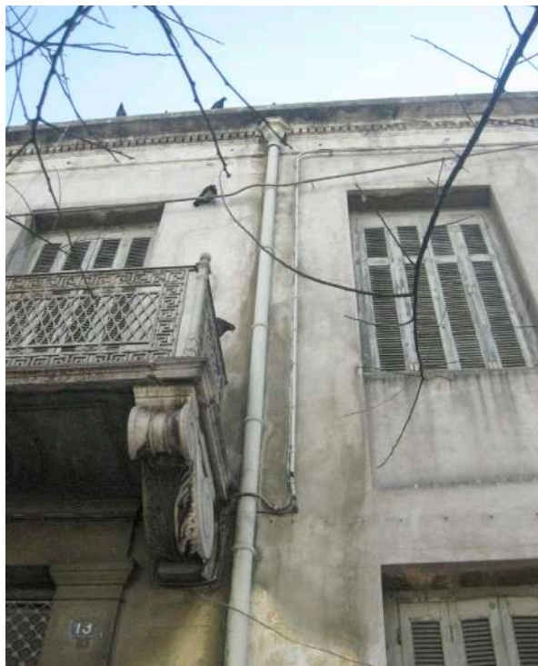
Επί της Χατζηκυριάκου, αλλοιωμένη όψη (ξυρισμένη πλαισίωση ανοιγμάτων, ορθογώνιο γείσο στέψης, απουσία κορωνίδας)
