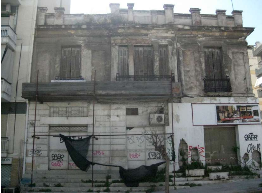
Η όψη στην οδό Χατζηκυριάκου. Διακρίνεται στον όροφο το προεξέχων μεσαίο τμήμα του με τον τριμερή διαχωρισμό των ανοιγμάτων. Στο ισόγειο υπενθύμιση του ισόδομου συστήματος.
