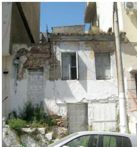
Εικ. 6, Ηροδότου 48, (ΔΚ42), Λαϊκό ισόγειο κτίριο. Παρόλη την απουσία συμμετρίας και των πολλών αλλαγών που έχει υποστεί, το μικρό αυτό κτίριο έχει ξύλινο νεοκλασικό γείσο στη στέψη γεγονός που μας οδήγησε στο χαρακτηρισμό του ως πρώιμο λαϊκό. Φαίνεται να είναι ένα από τα πιο παλιά σωζόμενα κτίρια της περιοχής.
