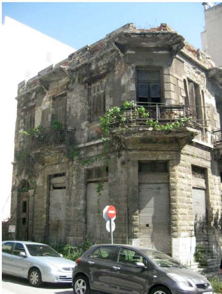
Η γωνία του κτιρίου
