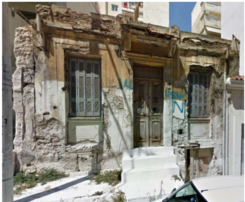
Παλαιότερη φωτογραφία. Διακρίνεται η πλαισίωση των ανοιγμάτων (πηγή: google street view-2009)
