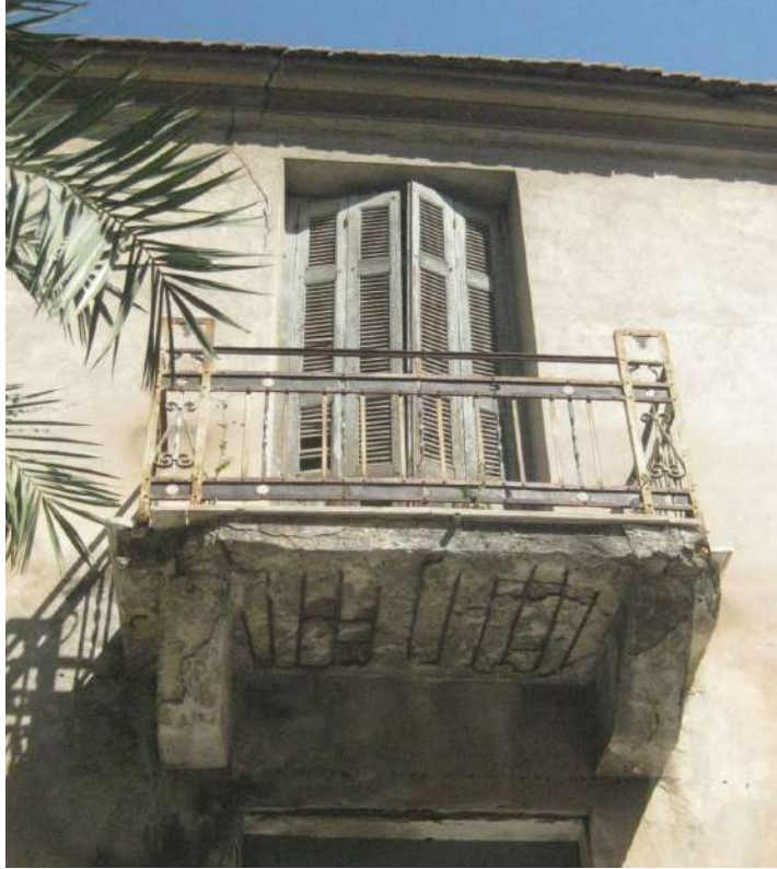
Ο εξώστης από μπετόν αρμέ. Διακρίνεται στο κάτω άνοιγμα το πρέκι με τη μεταλλική ράβδο σχήματος διπλού T.
