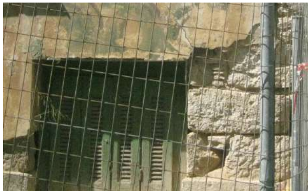
Η βάση του κτιρίου από μεγάλους ορθογωνισμένους λίθους και το άνοιγμα του ημιυπογείου
