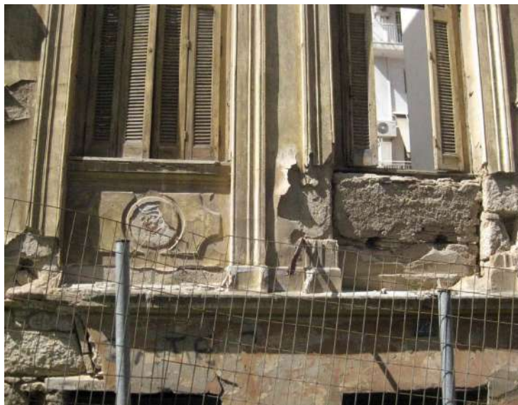
Η βάση του κτιρίου από μεγάλους ορθογωνισμένους λίθους και το άνοιγμα του ημιυπογείου
