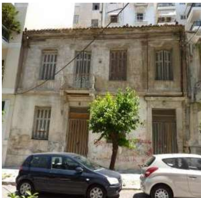
Εικ. 21, Ευπλοίας 23 (πριν την αποκατάσταση), (ΔΚ14).
