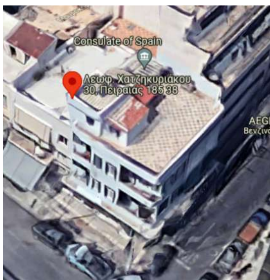
Στέγαση (πηγή: google earth-2014)
