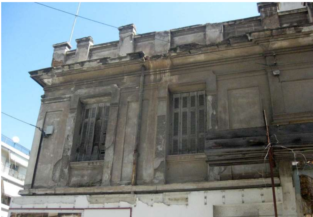
Οδός Θουκυδίδου, πλαισίωση ανοιγμάτων παραθύρων. Στο στηθαίο οι πεσσοί οριοθετούν νοητά τα ανοίγματα και τις άκρες των όψεων.
