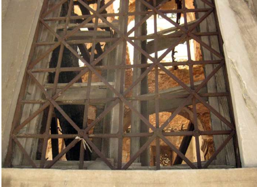
Το κούφωμα ανοίγματος παραθύρου του ισόγειου με το μεταλλικό κιγκλίδωμα
