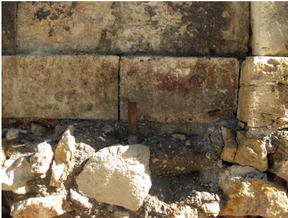
Η βάση του κτιρίου από ορθογωνισμένους λίθους.
