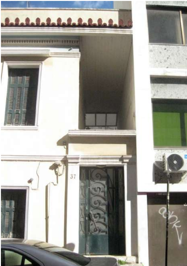
Η θύρα εισόδου, νεοκλασική πλαισίωση και νεότερο μεσοπολεμικό κούφωμα.
