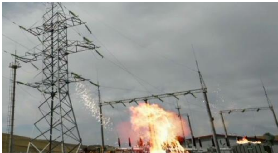
Εικόνα 2.13: Αναπαράσταση πρόκλησης πυρκαγιάς σε γραμμές μεταφοράς ηλεκτρικής ενέργειας.
