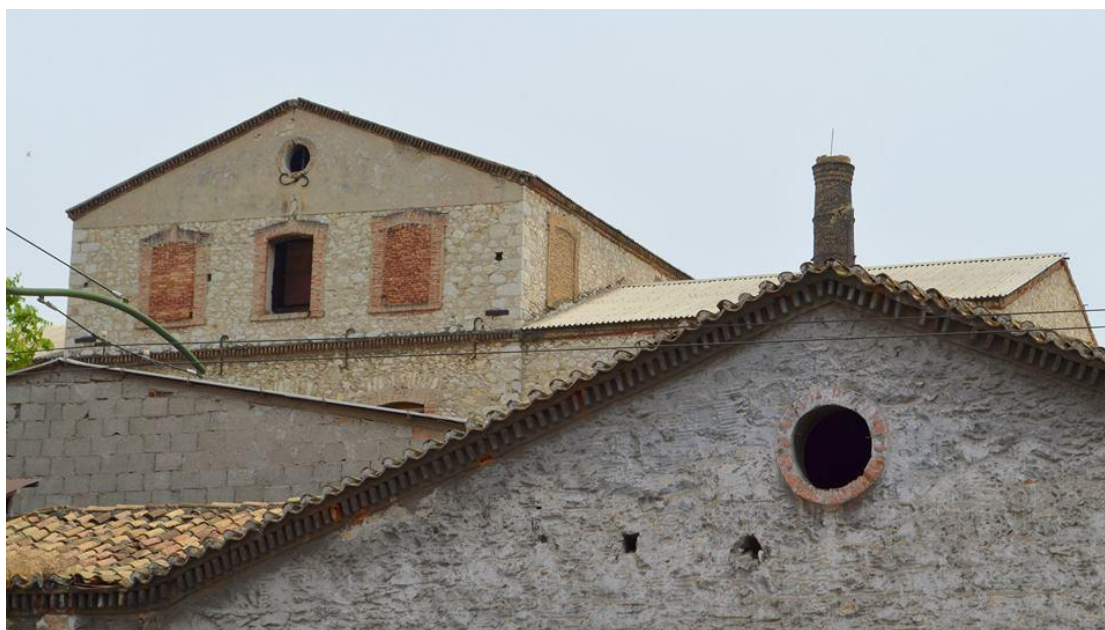
Εικόνα 14. Το εγκαταλελειμμένο εργοστάσιο HBH. Πηγή: (Μαυράκης, 2017)
