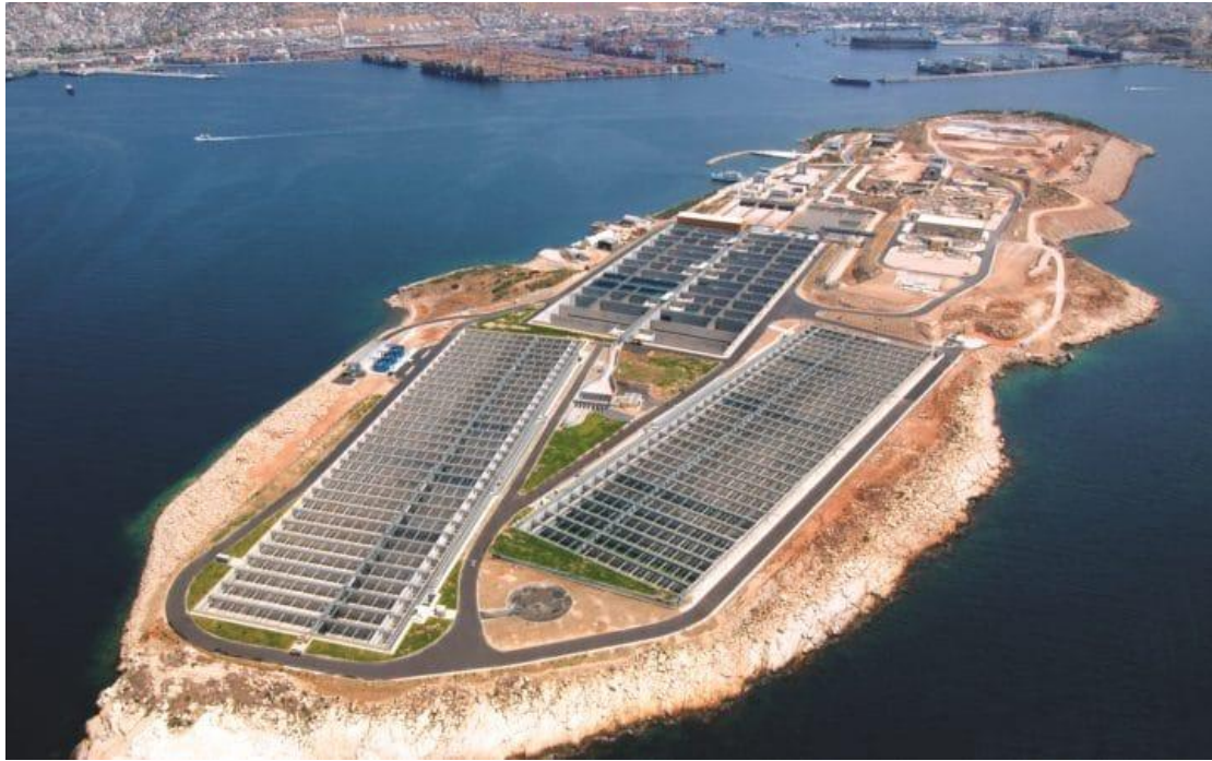
Εικόνα 9: Κέντρο Επεξεργασίας Λυμάτων Ψυττάλειας (ΚΕΛΨ) (Περιβαλλοντικό Παρατηρητήριο Ελλάδος, χ.χ.)
