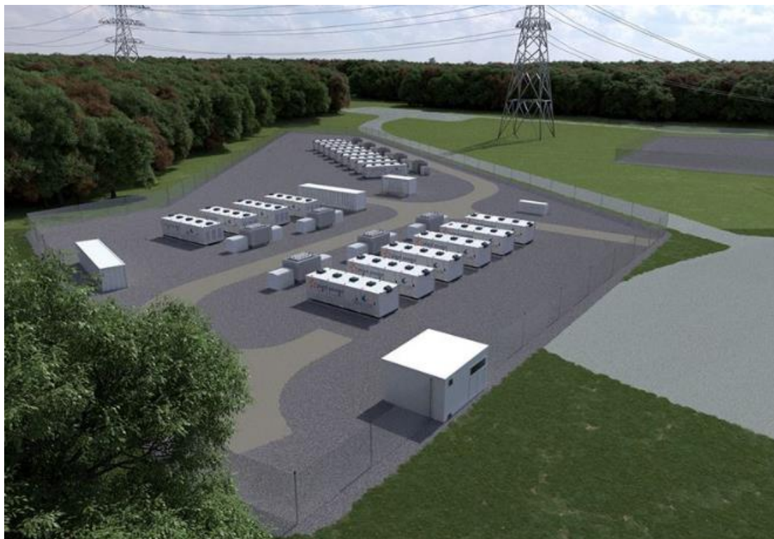
Εικόνα 5.22: Σύστημα αποθήκευσης, Pivot Power, Ηνωμένο Βασίλειο (Πηγή: Wärtsilä to deliver 100MW of energy storage for Pivot Power projects in the West Midlands, England to support renewable energy integration (wartsila.com) )
