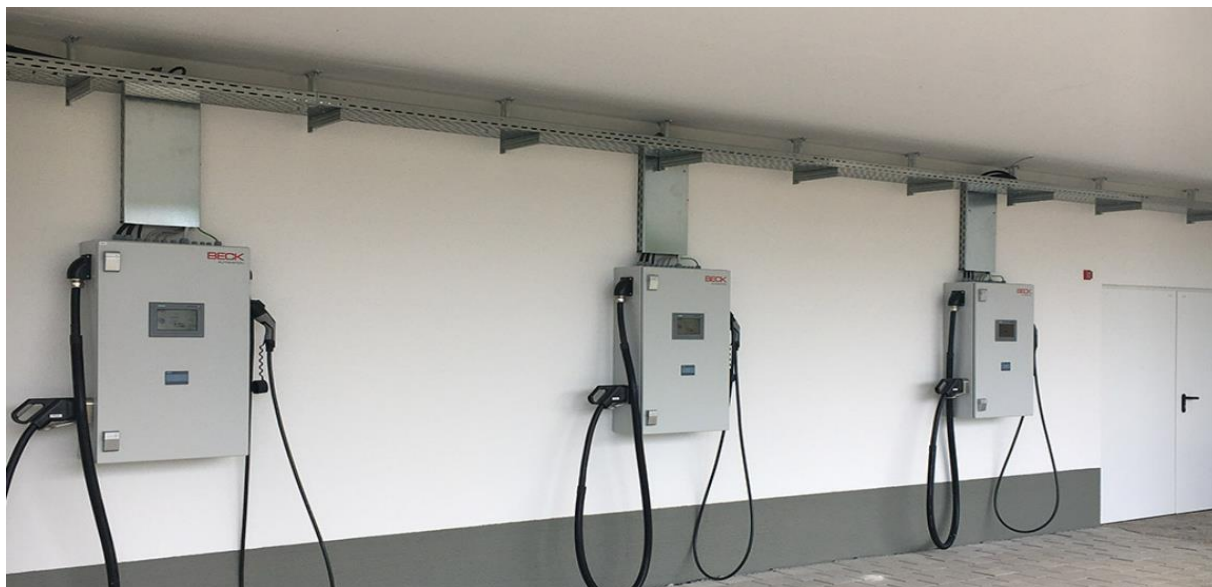
Εικόνα 6.21: Πλήρως συναρμολογημένοι και έτοιμοι προς χρήση σταθμοί φόρτισης AC-DC στον χώρο κοινής χρήσης αυτοκινήτων πολυκατοικιών, στο Weinsberg.( Πηγή: Emilas)
