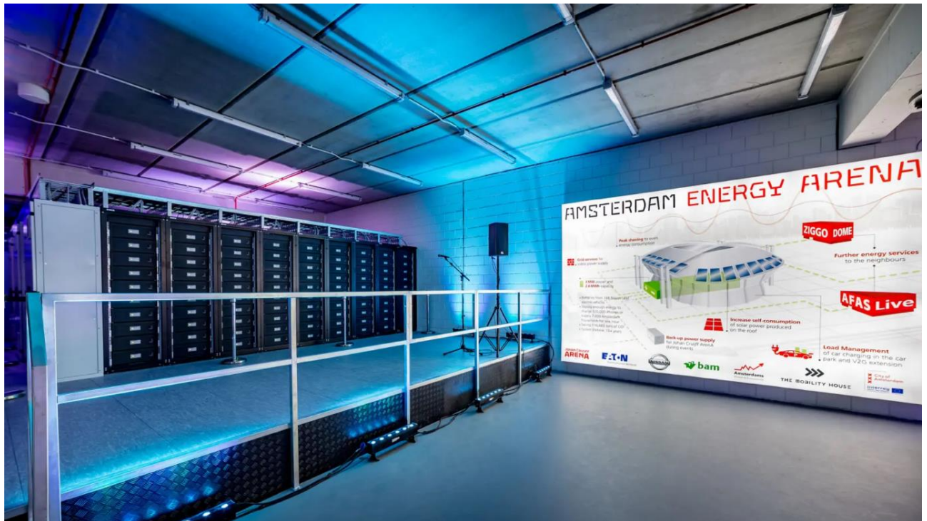
Εικόνα 6.10: Σύστημα Αποθήκευσης Άμστερνταμ (Πηγή: Johan Cruijff Arena | The 3 megawatt energy storage system in Johan...)
