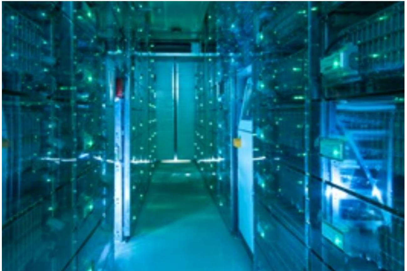
Εικόνα 6.14 : Εγκατάσταση αποθήκευσης μπαταριών τελευταίας τεχνολογίας στο Herdecke Βόρεια Ρηνανία-Βεστφαλία ( Πηγή: State-of-the-art battery storage facility in Herdecke, North Rhine-Westphalia)
