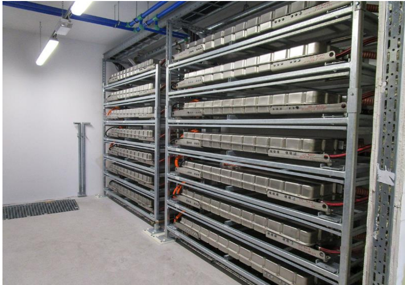
Εικόνα 6.6 : Σύστημα αποθήκευσης από μπαταρίες δεύτερης γενιάς ( Πηγή: Aktuelles - G UW+ (guwplus.de) )
