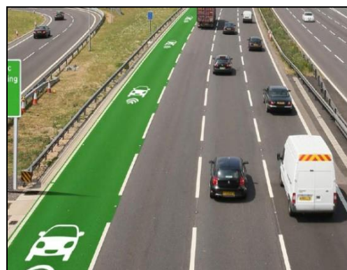
Εικόνα 1.1.1 : Λωρίδα δρόμου σε αυτοκινητόδρομο της Μεγάλης Βρετανίας όπου εφαρμόζεται επαγωγική φόρτιση ( UK to Trial In-Road Wireless Charging Tech for Electric Vehicles, 2015 )
