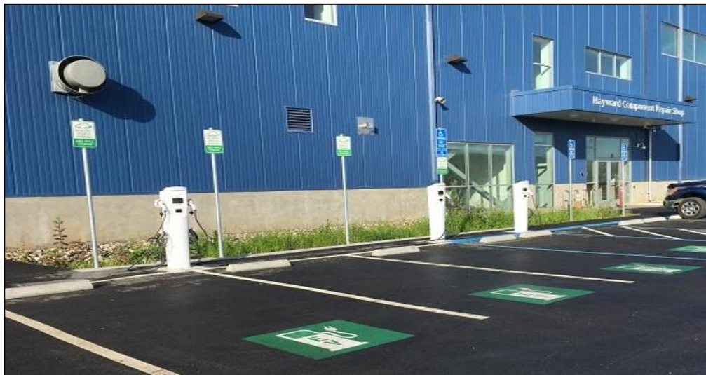
Εικόνα 1.2.2 : Εξωτερικός χώρος στάθμευσης με εγκατεστημένους φορτιστές ηλεκτρικών οχημάτων στις ΗΠΑ (Electric Vehicle (EV) Charging / Bart.Gov)
