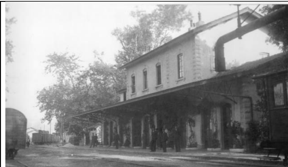
Εικόνα 20, Φωτογραφείο Φωτο- Διεθνές, Η νότια πλευρά του πρώτου Σιδηροδρομικού σταθμού, 1930-35. [φωτογραφία].
