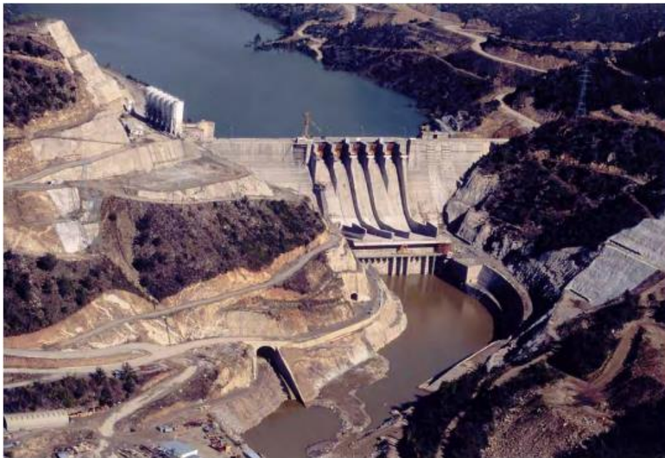
Εικόνα 6: Υδροηλεκτρικό Συγκρότημα Ποταμού Νέστου ΥΗΣ Θησαυρού - ΥΗΣ Πλατανόβρυσης [24]
