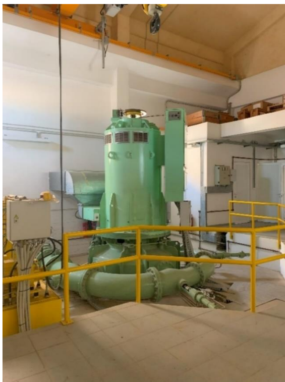
Εικόνα 17: Υδροστρόβιλος Κάθετου Άξονα ΜΥΗΣ Άνω Προεσπέρας Ικαρίας
