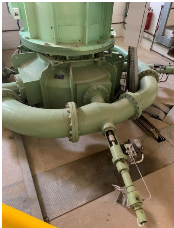
Εικόνα 17: Υδροστρόβιλος Κάθετου Άξονα ΜΥΗΣ Άνω Προεσπέρας Ικαρίας
