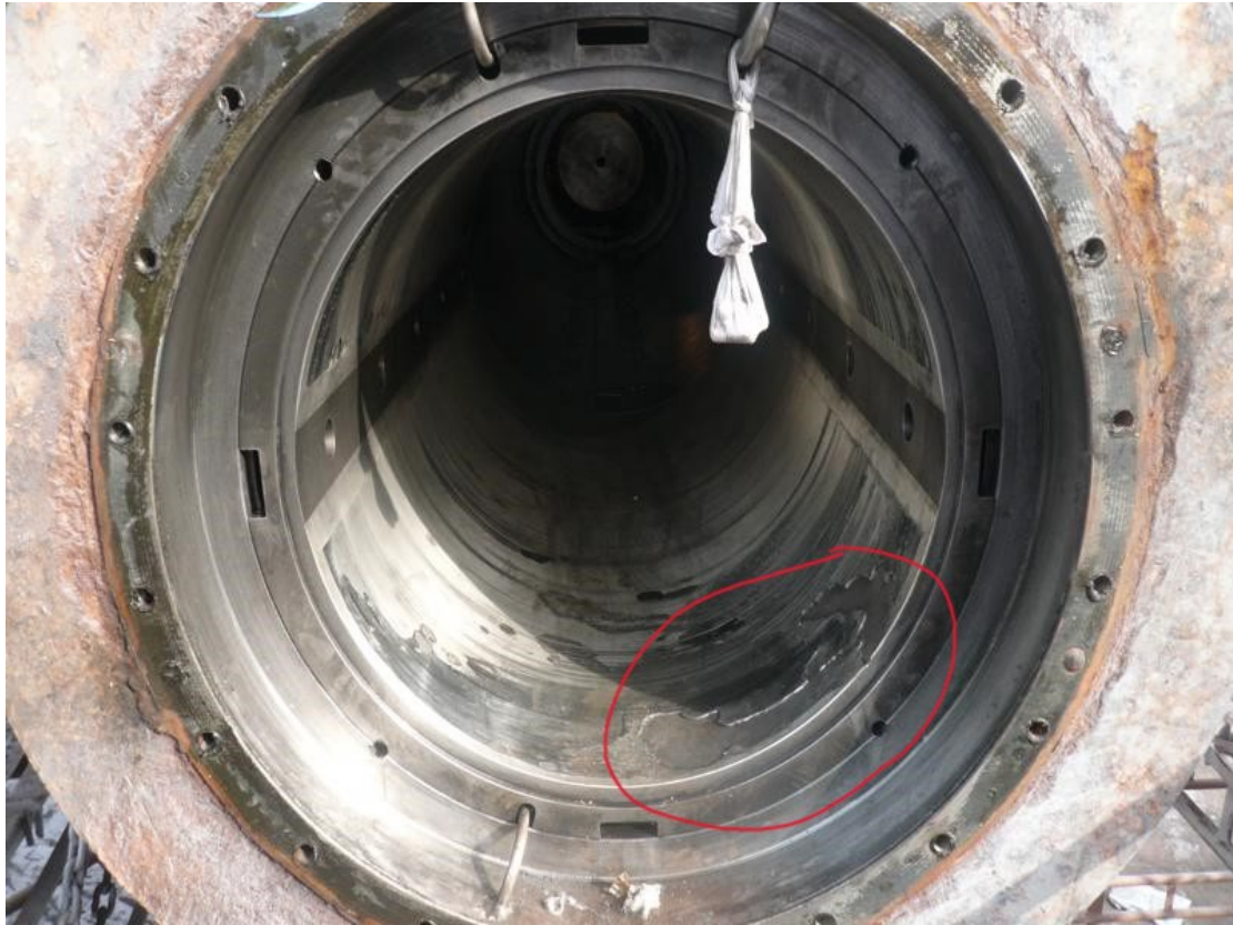
Εικόνα 11 Ζημιά στον πρυμναίο σωλήνα λόγω κακής ευθυγράμμισης του άξονα.
