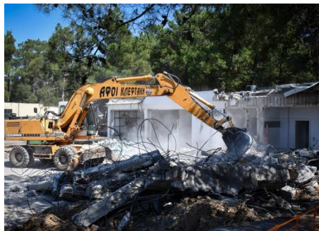
ΕΙΚΟΝΑ 1.4 : Κατεδάφιση Κτιρίου
