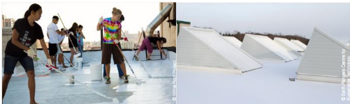
ΕΙΚΟΝΕΣ 3.12 & 3.13: Λευκές Ψυκτικές Στέγες στην Νέα Υόρκη της Αμερικής και το Γούντμπριτζ του Καναδά
