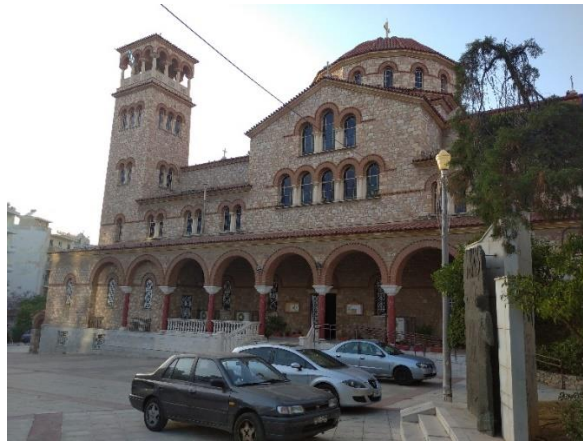
ΕΙΚΟΝΑ 4.11 : Πλατεία του εξωτερικού χώρου του ιερού ναού του Αγίου Νικολάου
