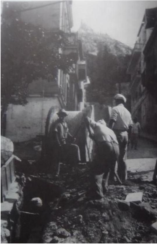
Εικ. 256. Έργα σε δρόμο στο Κολωνάκι, Αθήνα, [φωτογραφία].
