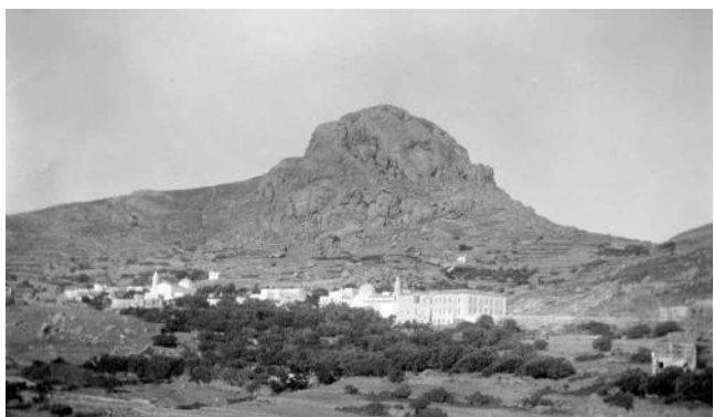
Εικ. 157. Άποψη Μονής Κεχροβουνιώτισσας (Αγ. Πελαγία), Τήνος, [φωτογραφία], (ΦΑ_19_72).
