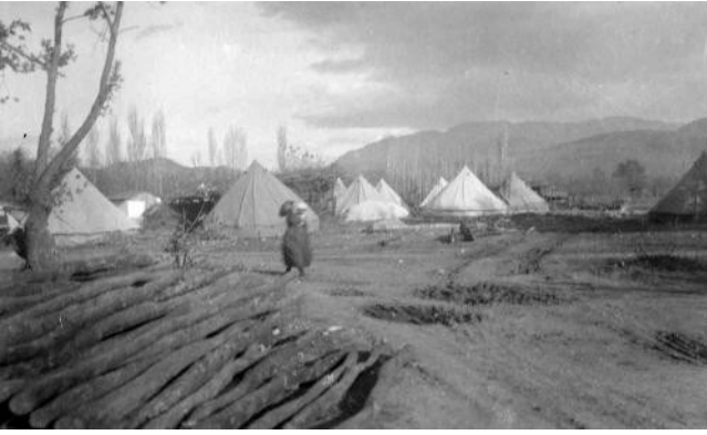
Εικ. 224. Καταυλισμός, Μεσολόγγι-Αιτωλικό, [φωτογραφία], (ΦΑ_19_565).
