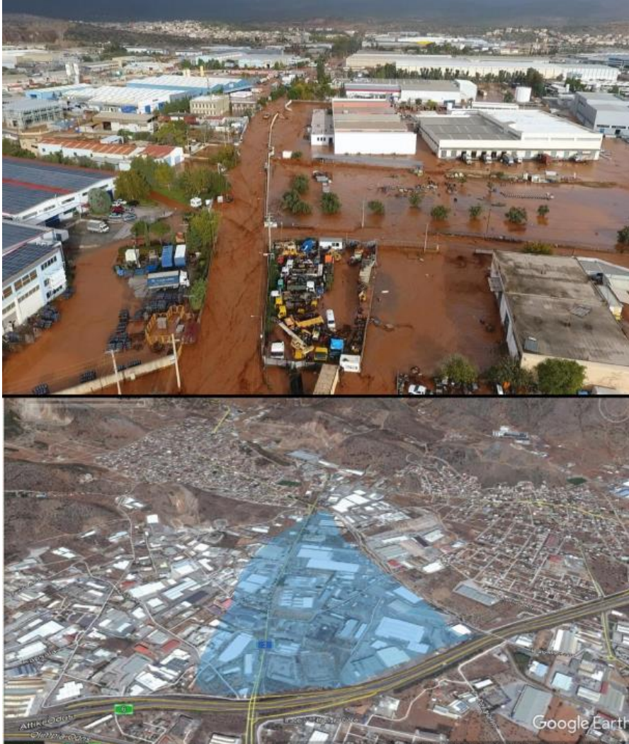
Σχήμα 26 : Πριν και μετά την πλημμύρα στο βιομηχανικό πάρκο της Μάνδρας [Μαλακοδήμος, 2020].
