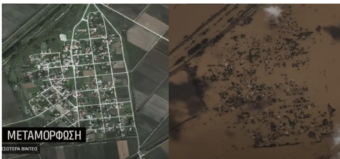
Σχήμα 30 : Πριν και μετά την πλημμύρα περιοχή Μεταμόρφωσης [News24/7.gr].
