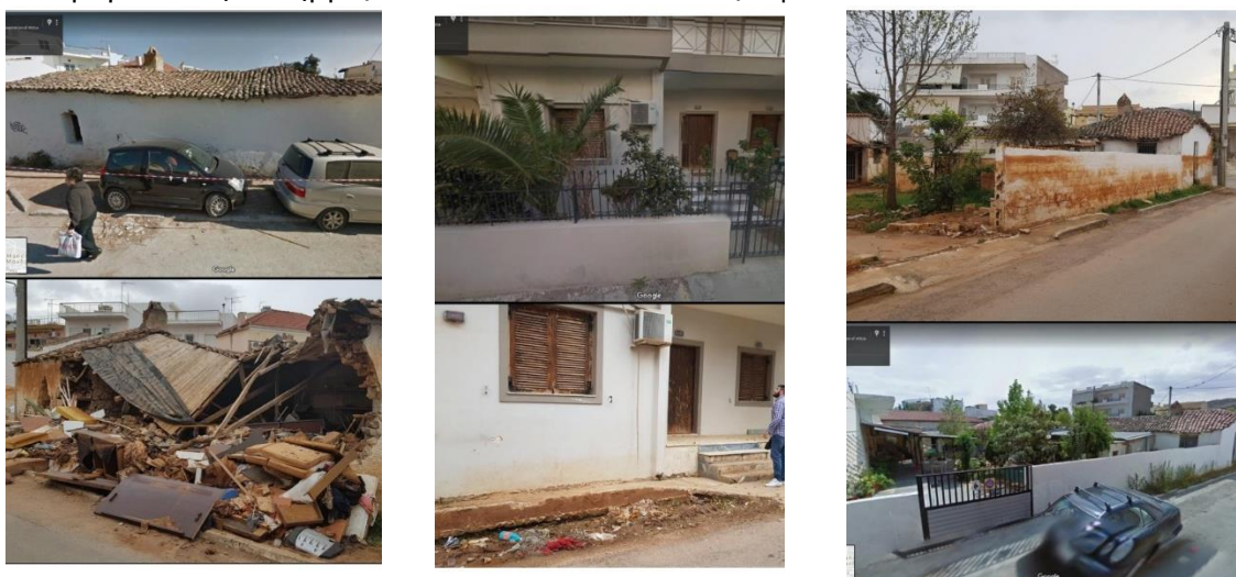
Σχήμα 24 : Καταστροφές κτηρίων στην περιοχή της Μάνδρας πριν και μετά το πέρασμα του χειμάρου [Μαλακοδήμος, 2020].
