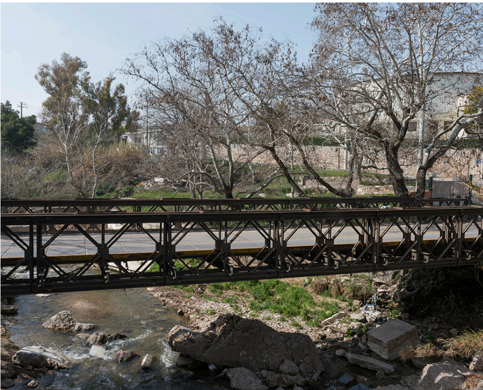
Κατερίνα Σταθοπούλου, Γέφυρα που διασχίζει τον Κηφισό , Μεταμόρφωση, 2023, [φωτογραφία].
