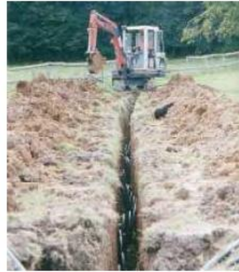
Εικόνα 1.22: Σύστημα οριζόντιου γεωεναλλάκτη με σπειροειδή διάταξη (slinky) – Κατακόρυφη τοποθέτηση. [12]
