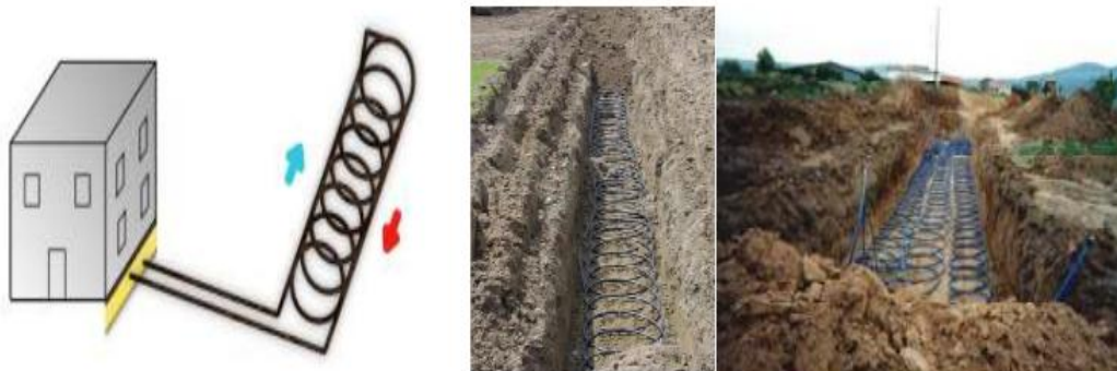
Εικόνα 1.21: Σύστημα οριζόντιου γεωεναλλάκτη με σπειροειδή διάταξη (slinky) – Οριζόντια τοποθέτηση. [12]
