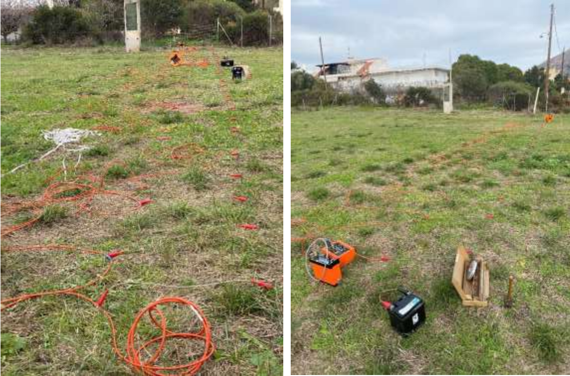
Εικόνα 17. Γραμμή ηλεκτροδίων κατά την πραγματοποίηση των τομογραφιών. Φαίνεται επίσης το πολυπύρηνο καλώδιο συνδεδεμένο με το όργανο μέτρησης και αποθήκευσης των μετρήσεων.
